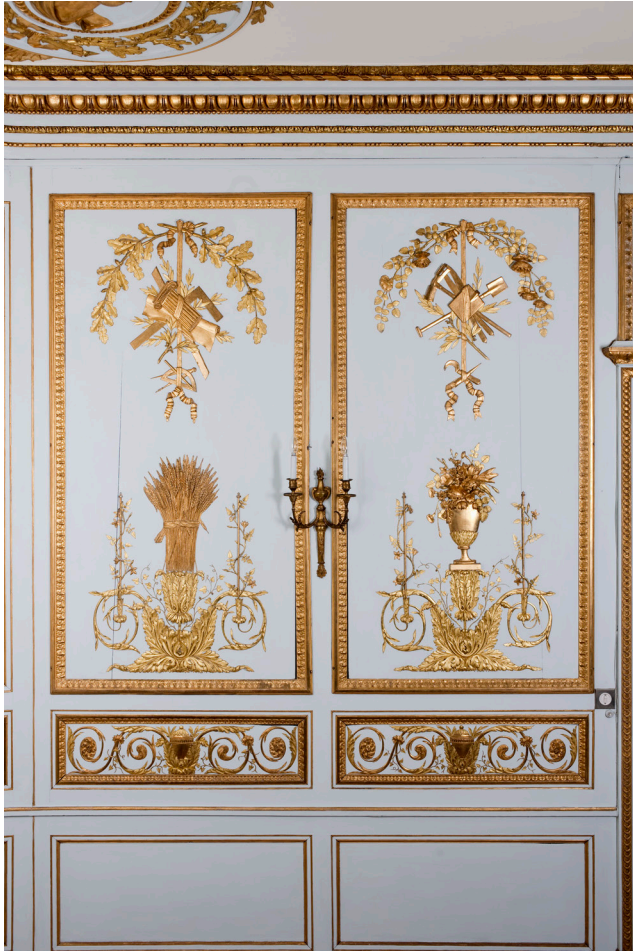
Fig. 16. Panneaux de hauteur du grand salon de la maison de Meuron, Neuchâtel.
