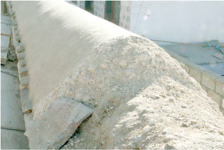
Fig. 66.3 Lhasa. Jokhang. Arga parapet.
