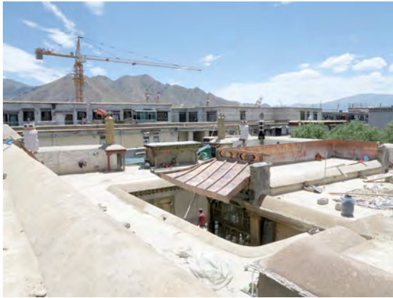
Fig. 15.3 Lhasa. Gyüme Dratsang. Arga roof.
