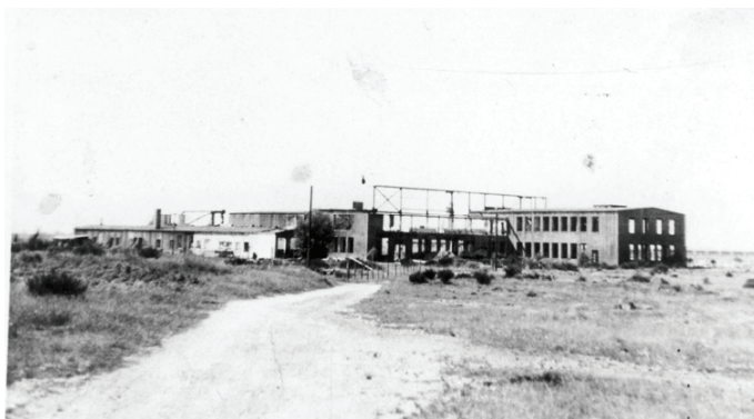
BCSB-Gebäude in Hangelar: Außenansicht zwischen 1949 und 1952.
