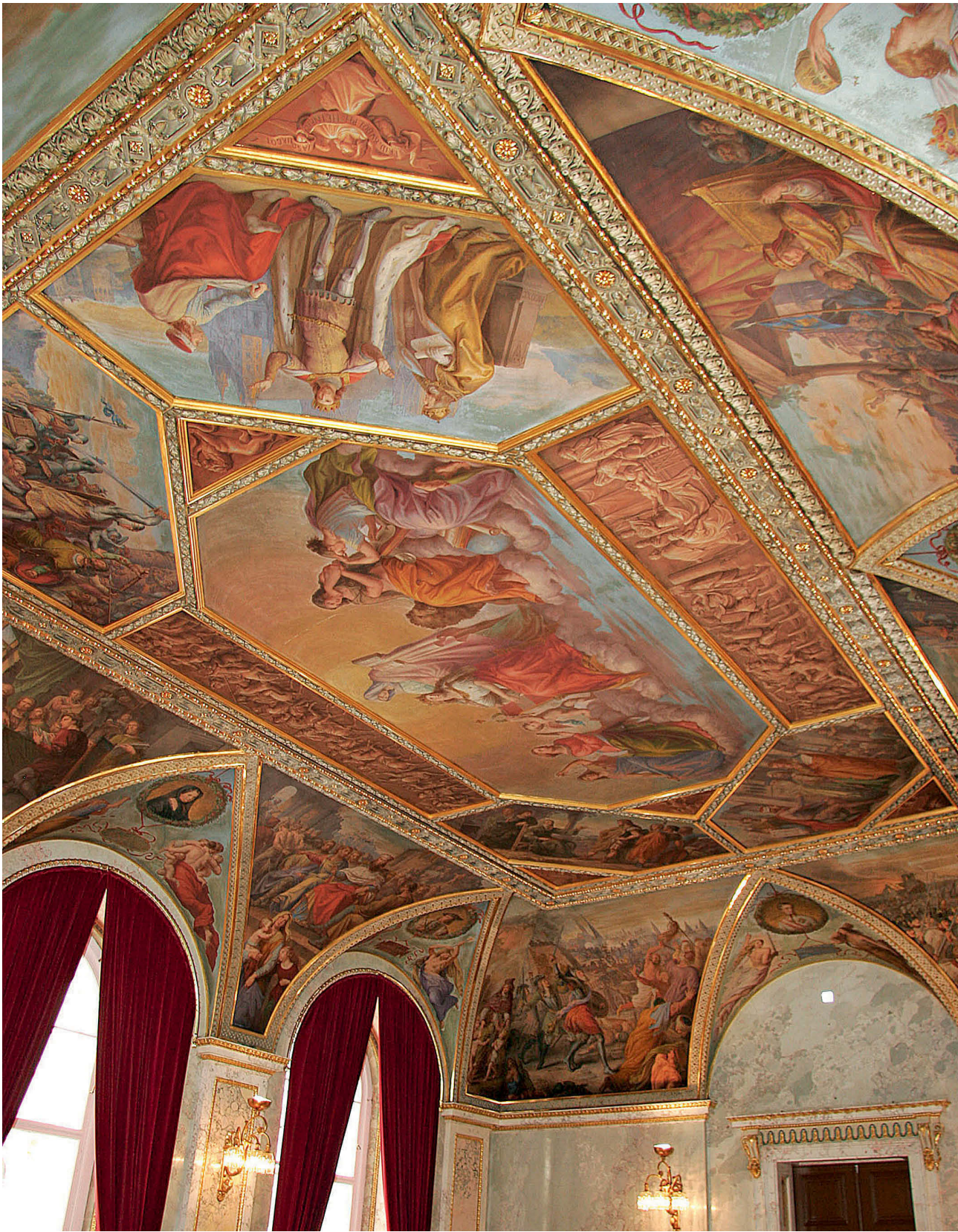
Abb. 295: Geschnitzte und vergoldete Rahmenleisten; Decke des Marmorsaaes im Gebäude der Niederösterreichischen Statthalterei.
