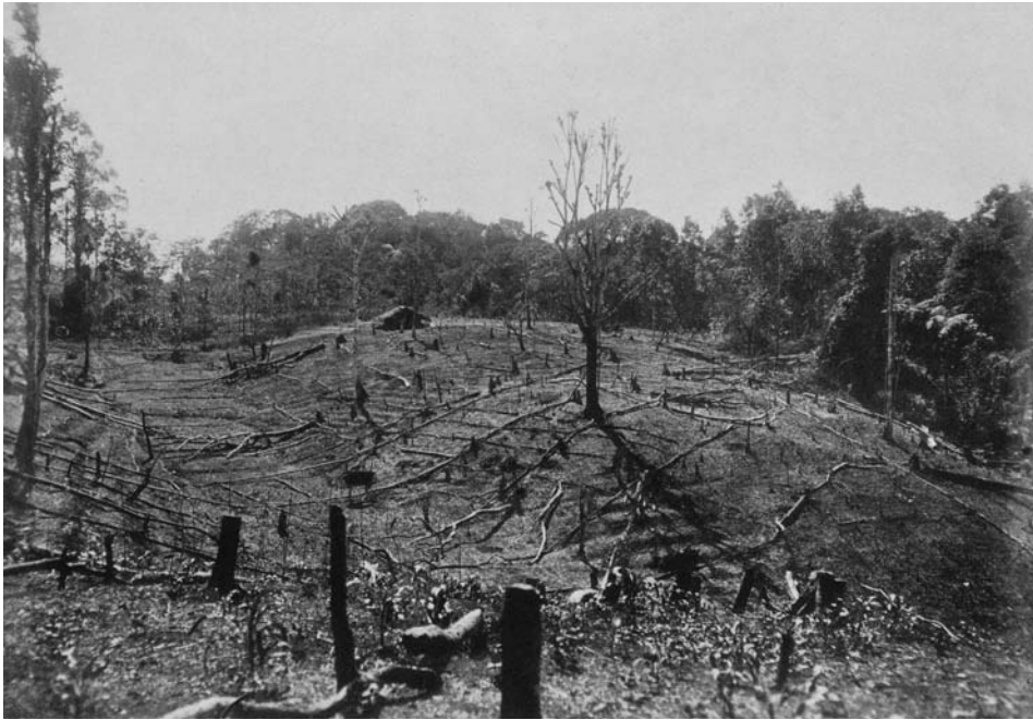
Gaga of bouwveld van zwervboer in Djampang aan het begin van de 20e eeuw. De gekapte bomen zijn op het terrein gelegd om het afspoelen van de bovengrond door de regen te beletten en de terrasvorming te bevorderen. Bron: F. de Haan – Priangan dl. 1, p. 376
