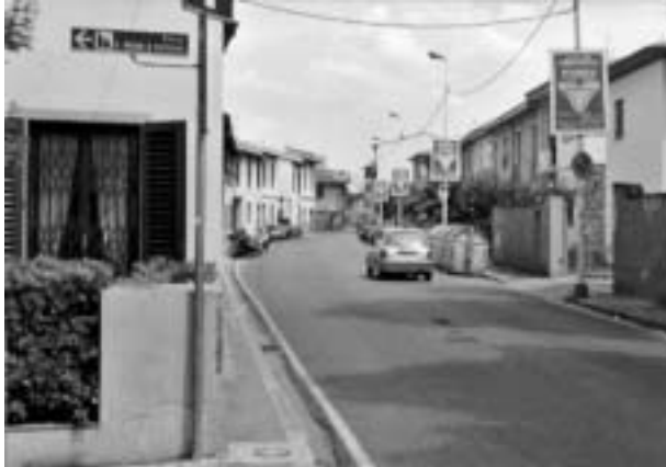
L'insediamento lineare di origine storica è caratterizzato da una specifica identità spaziale che oggi si scontra con un carico infrastrutturale sovralocale incompatibile con la sua configurazione.
