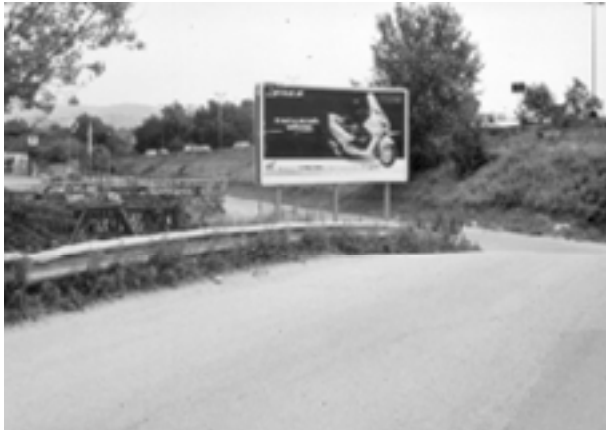
Nel paesaggio di pianura le maggiori infrastrutture stradali sono in genere caratterizzate da sezioni in rilevato, più frequentemente su terrapieno, ma talvolta anche su viadotto.
