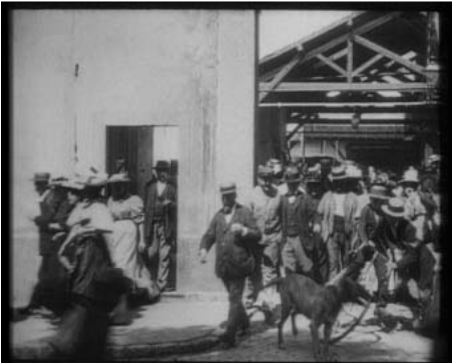
Illustration 70: ARBEITER VERLASSEN DIE FABRIK
