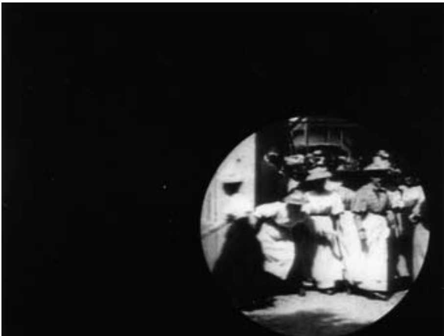
Illustration 71: ARBEITER VERLASSEN DIE FABRIK
