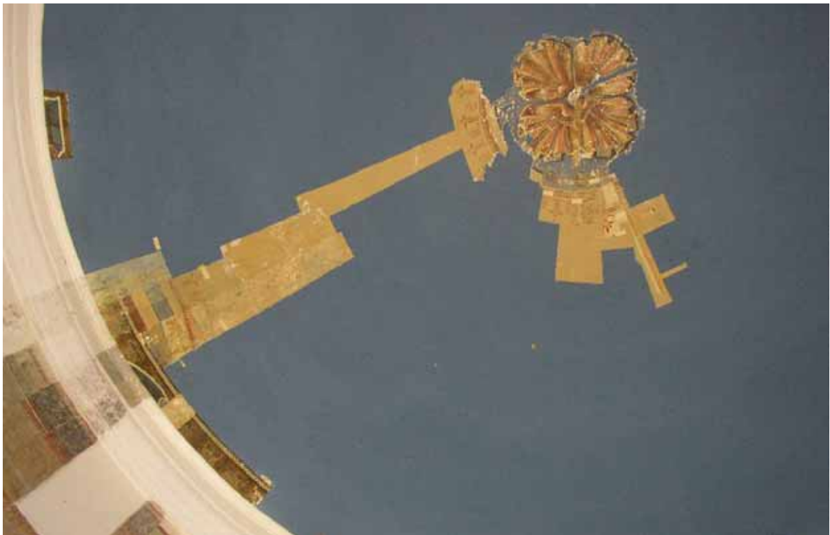
Abb. 18: Freilegung früherer Ausmalungen des Kuppelraumes im Erdgeschoss des Hauptgebäudes (Photo R. Förster).
