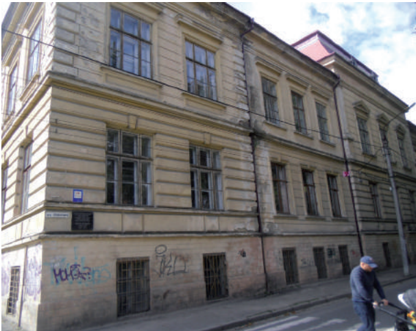
Abbildung 14 – k.k. Exekutivgebäude, nördliche Gartengasse.
