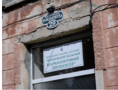
Abbildung 16 – Öffentliches Gebäude Gartengasse.
