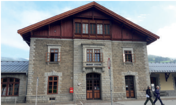
Abbildung 16 – Bahnhof Toblach im Südtiroler Pustertal.
