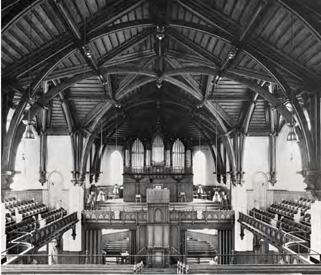
Abb. 19: Zürich-Wiedikon, ref. Kirche (Paul Reber, 1896). Der Blick zur Kanzelwand veranschaulicht das System der faltbaren Trennwände, hinter denen sich weitere Sitzplätze befanden, die je nach Anlass für den Konfirmandenunterricht oder für den Gottesdienstbesuch genutzt werden konnten. – Meyer 1973, 93.
