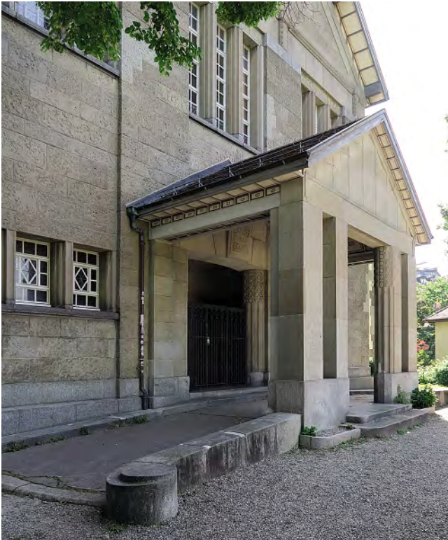
Abb. 506: Zürich-Oberstrass, ref. Kirche (Pfleghard & Haefeli 1908–10), Vorhallen. – Autor, 2019.
