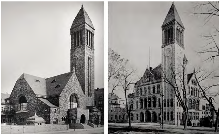
Abb. 88, 89: Links: Karlsruhe, Lutherkirche (Curjel & Moser, 1905–07). Gliederung und Aufbau des Turmes, die Bossenquaderung und der stumpfe Steinhelm zeigen die integrale Verwandtschaft mit der Richardsonian Romanesque auf. – Rechts: Albany (USA), City Hall (Henry H. Richardson, 1880–82). Der Turm mit seinem schlanken, von Lisenen statt Gesimsen besetzten Schaft, dem hochliegenden Zwischengeschoss und Pyramidenhelm ist ein Markenzeichen des späten Richardson und wurde in Nordamerika für diverse City Halls nachgeahmt. – AXXJ 8 (1908), T. 80. | Rensselaer 1888, Taf.
