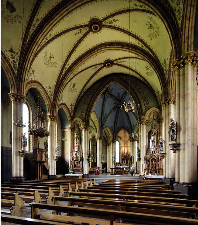
Abb. 39: Dussnang TG, kath. Kirche (August Hardegger, 1889–90). In der Schweiz frühes Beispiel einer Staffelhalle mit stark reduzierten Seitenschiffen. – Sebastian Schritt, 2015.
