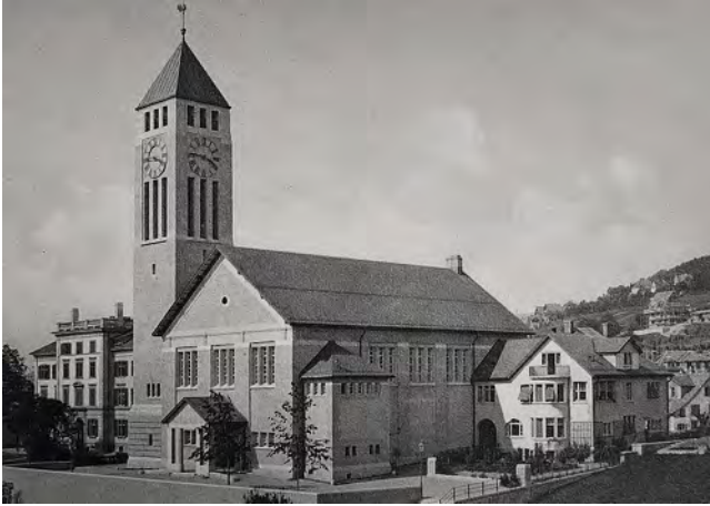
Abb. 309: Zürich-Oberstrass, ref. Kirche mit angebautem Pfarrhaus (Pfleghard & Haefeli 1908–10). – Ews Oberstrass, 1911, 54.
