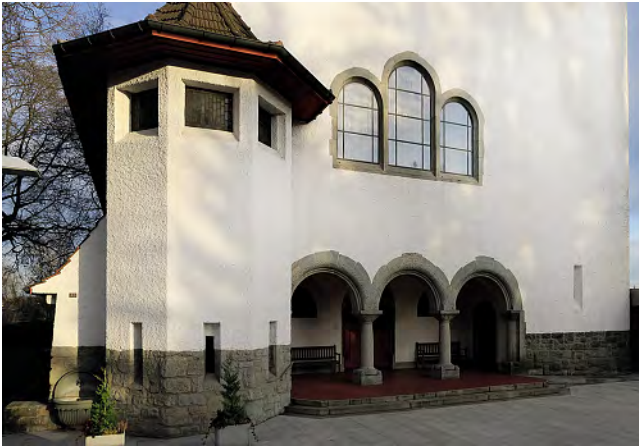
Abb. 195: Biberist-Gerlafingen, ref. Kirche (Widmer & Erlacher, 1909). Spiel mit den durch Grobkörnigkeit und Schattenwirkung belebenden Putzflächen an Emporentreppenturm, Fensterleibungen und Seiteneingangspfeiler. – Autor, 2020.
