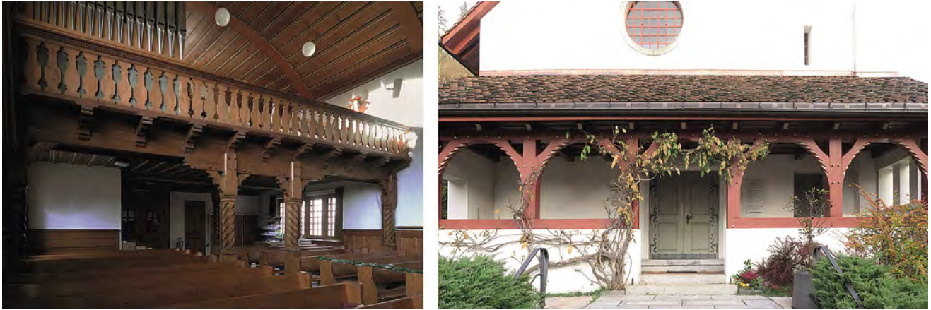
Abb. 189, 190: Röthenbach, ref. Kirche (Karl Indermühle, 1904–05). An der Eingangsempore mit ihren gedrehten Pfosten, konturierten Kopfhölzern und den Brüstungsausschnitten werden Bearbeitungsweisen aufgenommen, wie sie der lokalen Zimmermeistertradition der Umgebung entsprechen, die teilweise auch in der Abbildung bei Gladbach dargestellt ist. An der Vorhalle wird das Motiv noch freier umgesetzt und in Arkaturen gebogen. – Autor, 2019.
