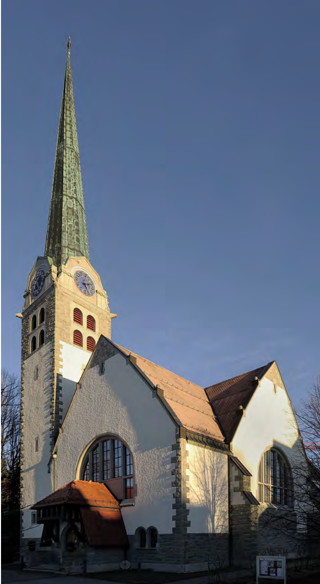
Abb. 90: St. Gallen-Bruggen, ref. Kirche (Curjel & Moser 1904–06). Durch die zahlreichen konvex gebrochenen Verläufe an Kirchen- und Turmgiebel, des Vorhallendachs und bei genauer Betrachtung auch des Turmschafts (bereits auf Höhe der Schiffstraupe) entsteht eine ausdrucksvolle Gravität, zu welcher der nadelspitze Turmhelm einen eleganten Kontrast setzt. – Autor, 2020.
