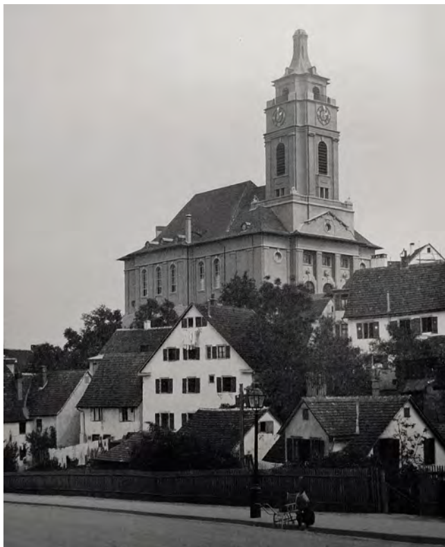
Abb. 284: Stuttgart-Gaisburg, ev. Kirche (Martin Elsaesser, 1910–13). Die mögliche Vorbildwirkung für die Kirchen Fluntern und vor allem für die Friedenskirche Bern liegt sowohl in der Gesamtanlage der Kirche, ihrer Positionierung über der Stadt, der rückwärtigen Unterkellerung, der inneren Säulenstellung sowie in klassizisierenden Formulierungen, die hier freilich noch etwas freier ausfielen. – MBF 17 (1918), T. 11.
