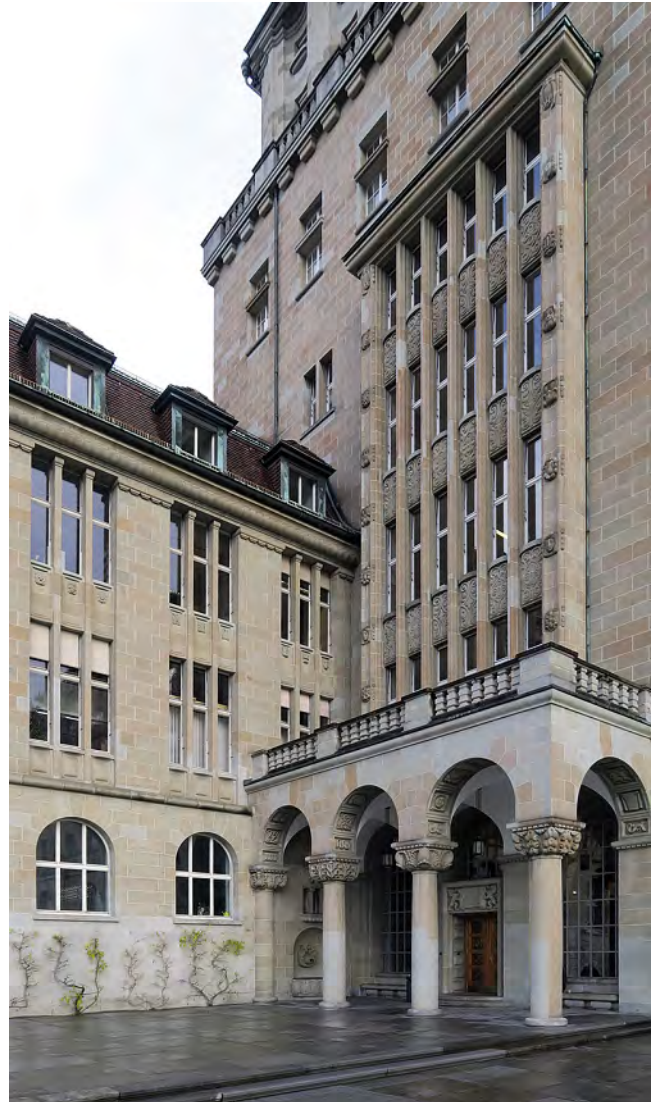
Abb. 243: Zürich, Universität (Curjel & Moser, 1911–14), Südeingang mit Kapitellen und Skulpturen von Wilhelm Schwerzmann. – Autor, 2019.
