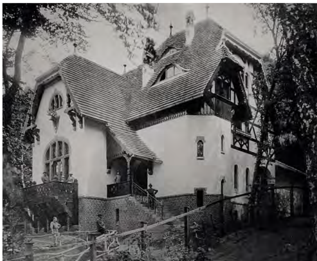
Abb. 127: Eberswalde (Brandenburg), Forstkasino (Emil Jacob, 1892–93), ein klarer Reflex auf Ungewitters Pfarrhaus für Darmstadt (Abb. 123), jedoch von den gotischen Stilreminiszenzen weitgehend befreit und verstärkt auf flächig-physiognomische Wirkung ausgerichtet. – BAK 6 (1893), Taf.
