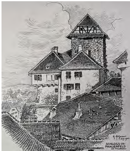
Abb. 113: Roland Anheisser: Frauenfeld, Schloss, Bergfried mit Megalithmauerwerk, das auch in der Schweiz um 1200 aus funktionalen Gründen gewählt worden war, einerseits als Arbeitersparnis, zugleich aber, um dem Feind das Heraufschieben von Sturmleitern zu erschweren. – Anheisser 1910, 87.
