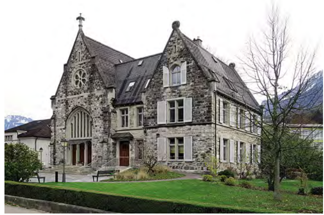
Abb. 306: Ingenbohl-Brunnen SZ, ref. Kirche mit stilistisch und formal stark angeglichenem Pfarrhaus (Baur & Nabholz, Zürich, 1886–90). Trotz früher Adaption angelsächsischer Impulse in der englischen Fassade und den Bossenquadern fehlt noch die typisch reformerische, malerische und hofbildende Anlage. – Autor, 2019.
