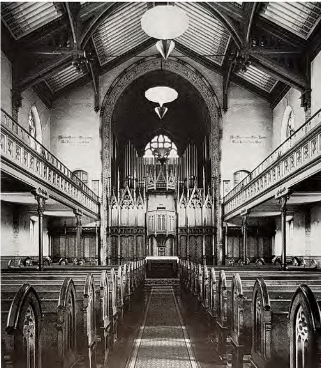
Abb. 7, 8: Zürich-Unterstrass, ref. Kirche (Paul Reber, 1883–84), Grundriss und Blick zur Kanzelwand. An die Stelle eines Chors tritt ein kleiner Annexraum mit grossem Stirnwandfenster und Treppenaufgang zur axialen Kanzel. – SBZ 4 (1884), 99–100 | Kga Zürich-Unterstrass.
