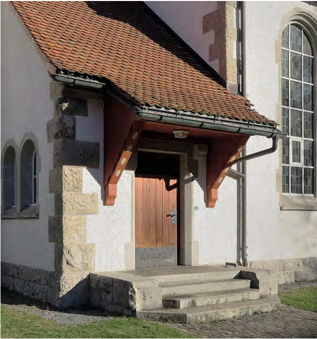
Abb. 193: Degersheim, ref. Kirche (Curjel & Moser, 1906–07). Die handwerkliche Bearbeitung wird in antiindustrieller Weise demonstriert: Der Bereich vereint die Leistungen von Maurern, Steinmetzen, Zimmermeistern, Schreibern, Glasmalern, Schmieden und Malern, wobei grundsätzlich versucht wird, die «werkgerechte» Arbeit zu verdeutlichen. – Autor, 2020.
