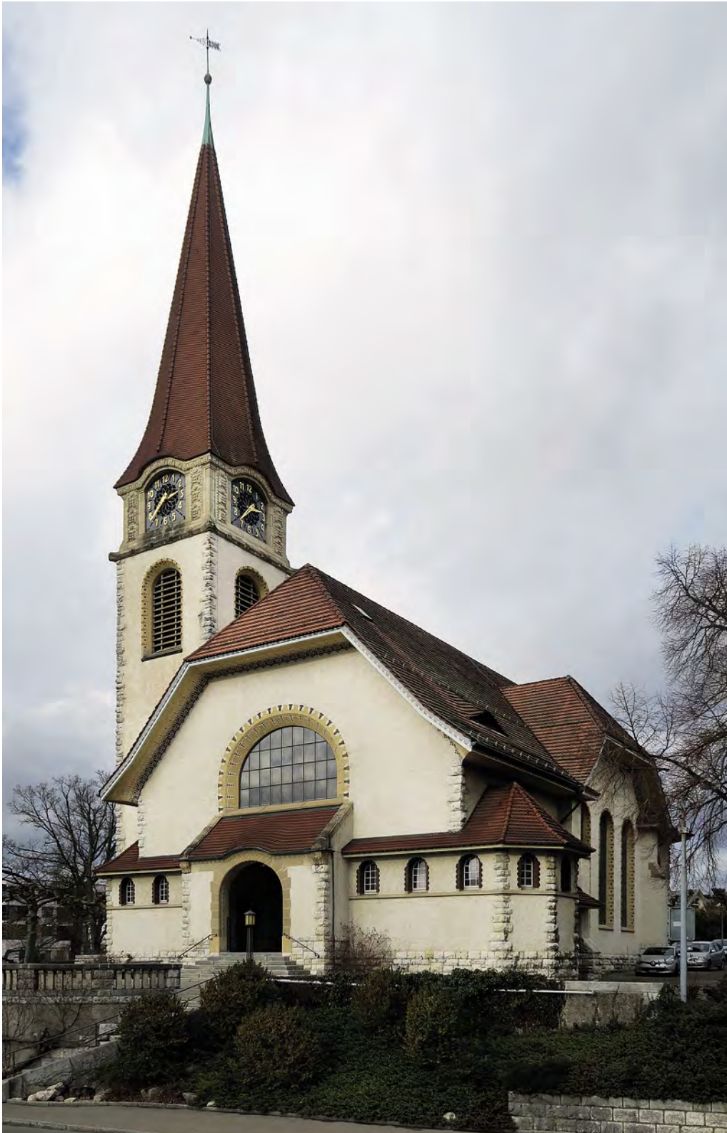
Abb. 138: Wallisellen, ref. Kirche (Bischoff & Weideli, 1907–08) mit auffälligen Wellentraufen an Eingangsvorhalle und Turm, ebenso mit dem damals modischen Kronendach und Fledermausgauben. – Autor, 2020.
