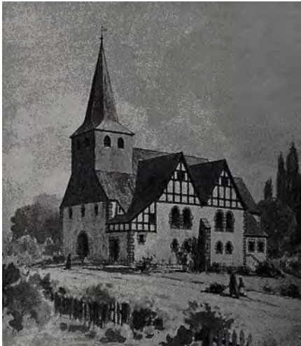
Abb. 426: Altengronau (Hessen), ev. Kirche mit neuem Schiff von 1904. – Hossfeld 1905, 179.
