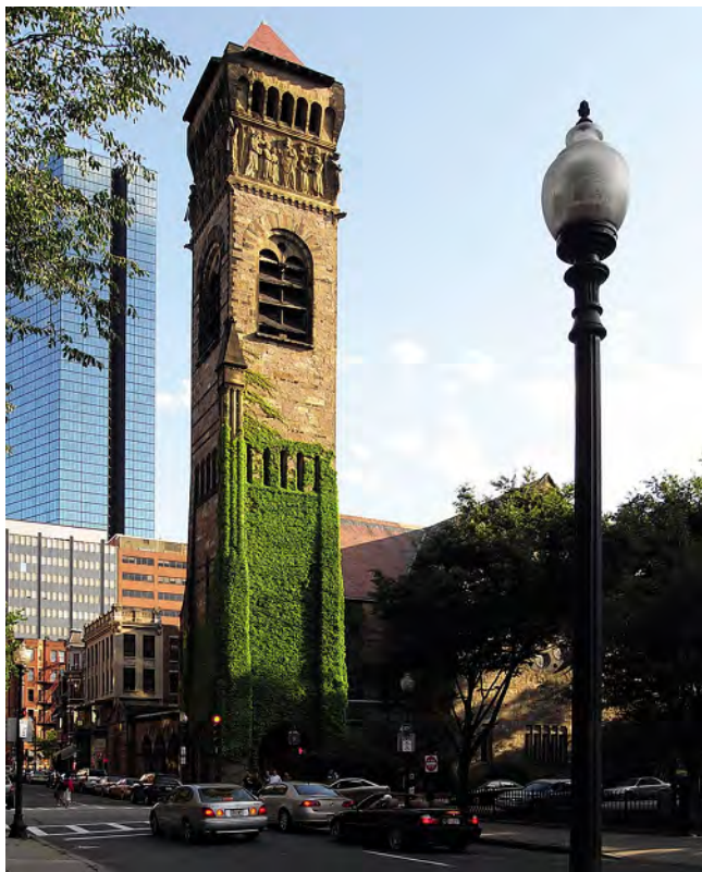
Abb. 302: Boston, Brattle Square Church (Henry H. Richardson, 1872). Der Flankenturm wirkt trotz dem Verbund mit dem Kirchenbau nahezu freistehend und kommt dadurch auch im engmaschigen Strassenraster zur Geltung. Er wurde bereits in der nordamerikanischen Architektur der folgenden Jahrzehnte häufig nachgeahmt. – Autor, 2007.
