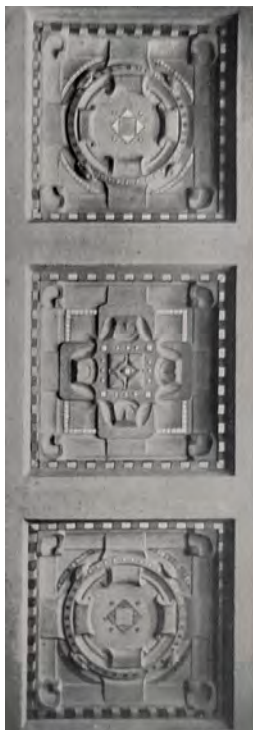
Abb. 162, 163: Links: Ernst Hottenroth, Deckenornamente in Hans Erlweins Sitzungszimmer der städtischen Sparkasse an der Dresdener Ausstellung 1906, Eisenbeton mit Glasmosaik.- Rechts: Wallisellen, ref. Kirche, Uhrengeschoss mit Ornamenten des Bildhauers Paul Abry, eng verwandt mit Hottenroths Ornamenten der Dresdener Ausstellung. – MBF 5 (1906), 243. | Autor, 2020.
