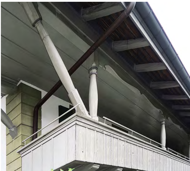
Abb. 191: Bern-Bümpliz, «Gfellerstöckli» von 1792 an der Wangenstrasse 7, einstiges Wohnhaus des Gfellergruts. Bäuerlich geprägtes Beispiel des in der Berner Umgebung typischen spätbarocken Bauernbarocks mit spindelförmigen, teilweise gefasteten Bügen und Pfosten sowie karniesförmig fassonierten Brettlaubenbögen. – Autor, 2019.
