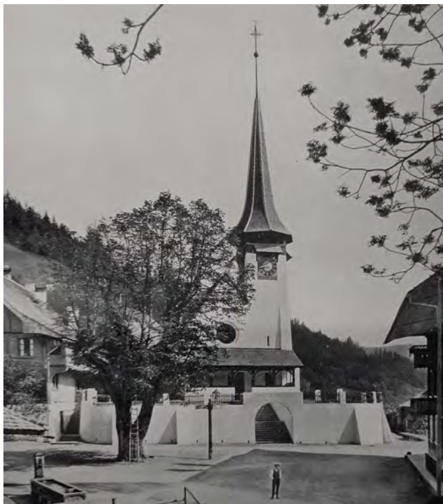
Abb. 317: Röthenbach, ref. Kirche (Karl Indermühle, 1904–05), Fotografie nach Vollendung. Zu beachten vor allem die (heute weitgehend entfernte) Stützmauerumfriedung mit Postamenten, Torbogen, Treppen und Vorhalle. – SBZ 46 (1905), T. II.
