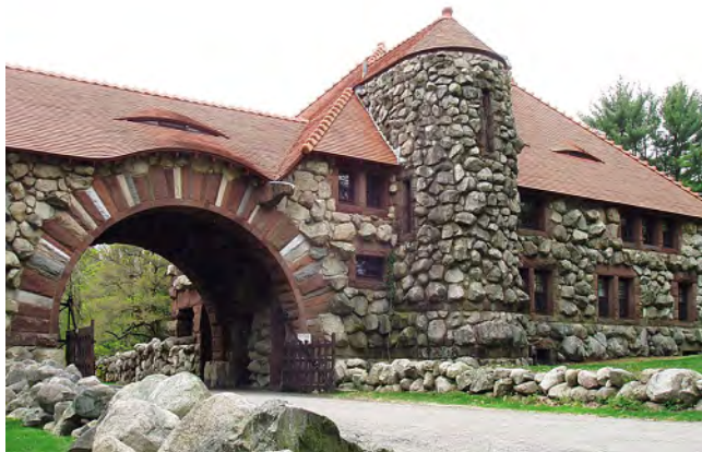
Abb. 137: North Easton, Ames Gate Lodge (Henry H. Richardson, 1883), als frühes Beispiel des Wiederaufgreifens der Wellentraufe und der Fledermausgauben. – Wikimedia Commons.
