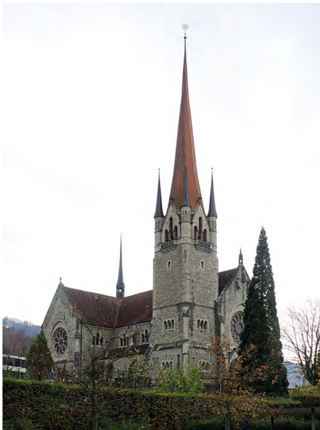
Abb. 72: Zug, St. Michael (Curjel & Moser, 1899–1902). Im Gegensatz zum Wettbewerbsentwurf mit Lisenengliederung und Variationen in der Steinsichtigkeit wurde der ausgeführte Bau, symptomatisch für die Monumentalisierung, fast gänzlich in Bossenquader gehüllt. – Autor, 2019.
