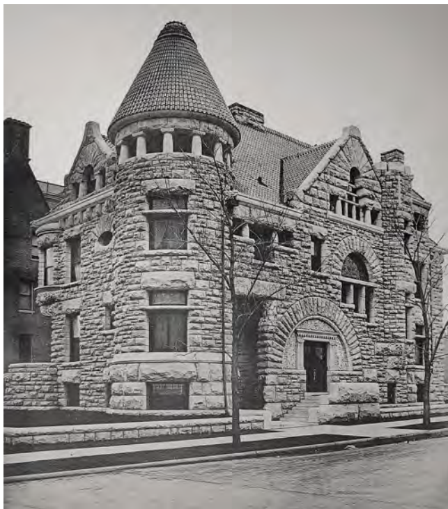
Abb. 360: Chicago, Wohnhaus C. W. Potter, Lakeshore drive 130 (F. R. Schock, 1890–91). – Hinckeldeyn 1897, T. 21.
