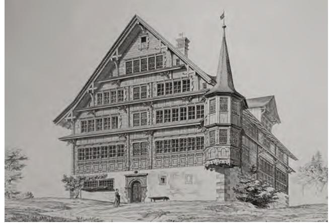
Abb. 444: Regionaltypisches Haus in Hochsteig bei Wattwil mit steilem Satteldach und Flugsparrendreiecken, wie sie auch für die Kirche Degersheim entworfen wurden. – Gladbach 1868, Taf. F.I.1.
