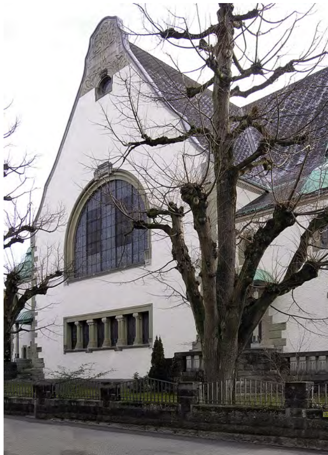
Abb. 102: Bern, Pauluskirche (Curjel & Moser, 1902–05). Querhausfassade mit Halbkreisfenster und Reihenfenster, ebenfalls mit alternierenden Säulenbündeln. – Autor, 2016.
