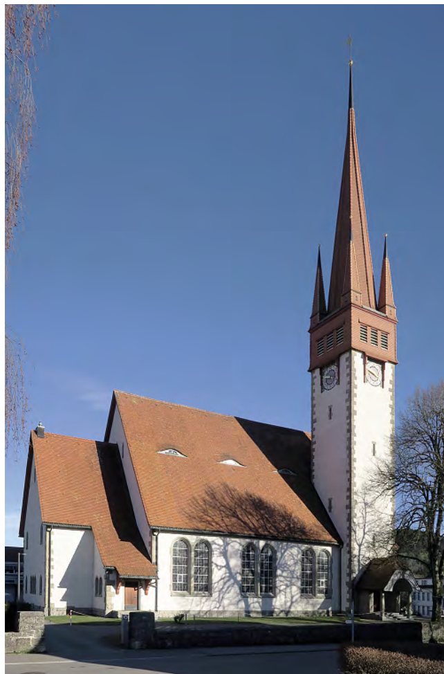
Abb. 134: Degersheim, ref. Kirche (Curjel & Moser, 1906–07). Die hohen, grossflächigen und gaubenbesetzten Steildächer mit funktionalen Traufenversätzen und die Quereingänge erinnern stark an die reformerische deutsche Landhausarchitektur. Sakral wirken fast einzig die gekuppelten Rundbogenfenster, die analog zum Wohnhausbau gruppiert sind. – Autor, 2020.
