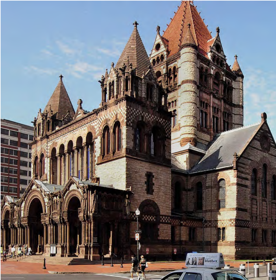
Abb. 65: Boston, Trinity Church (Henry H. Richardson, 1875–76 mit Ergänzungen 1895). Am Turm und dem Querhaus ist der an die Kolossalordnung erinnernde Entwurf sichtbar, mehrere horizontale Abschnitte zu übergreifen und auf durchgehende Gesimse zu verzichten. – Autor, 2007.
