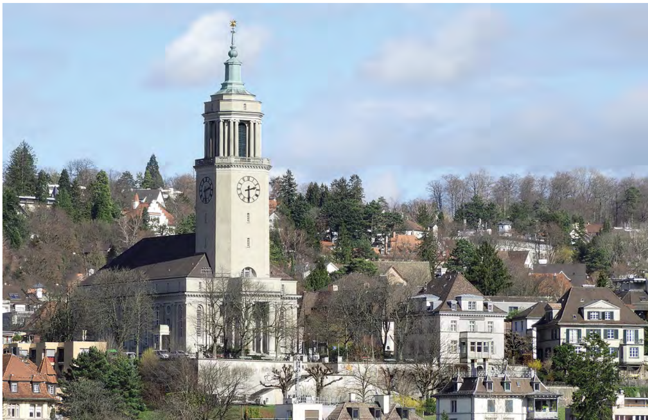
Abb. 267: Zürich-Fluntern, ref. Kirche (Karl Moser, 1918–20). Rechts der Kirche zwei zeitgleich erbaute Villen. – Autor, 2020.
