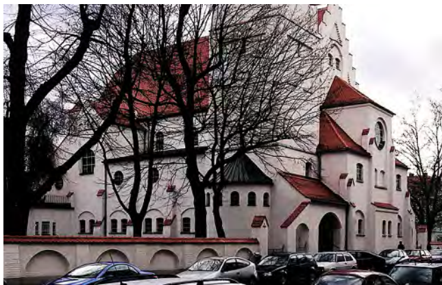
Abb. 176: München, Erlöserkirche. Umfriedung und malerische Gliederung mit Ziegeldächlein. – Autor, 2008.
