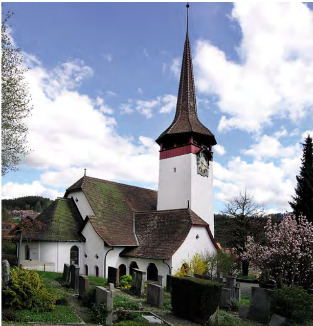
Abb. 180: Niederscherli, ref. Kirche (Karl Indermühle, 1912). Trotz des erst nachträglich hinzugetretenen Chorbaus (links im Bild) bestehen in der Massengruppierung offenkundige Verwandtschaften zu Fischers Stuttgarter Entwurf. – Autor, 2016.
