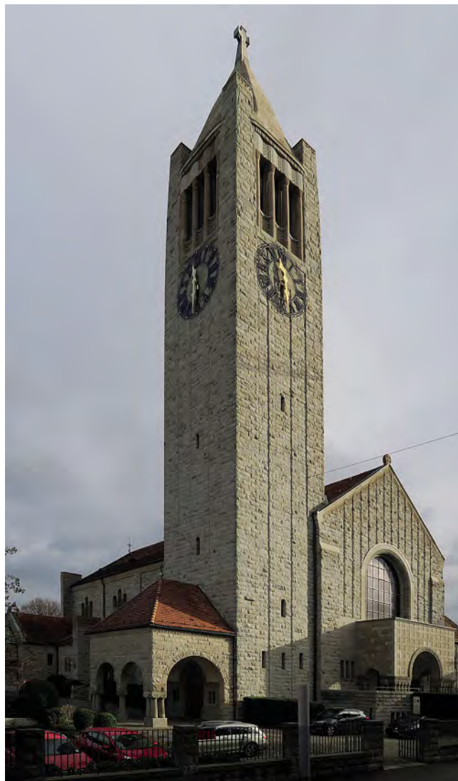
Abb. 79: Zürich, St. Antonius (Curjel & Moser, 1907–08). Mit Ausnahme vereinzelter Werksteine für Bauschmuck ist der gesamte Aussenbau in Bossenquader gehüllt, und nebst der schweren Massigkeit kommt auch eine malerische und dynamische Baumassen-gruppierung zum Ausdruck. – Autor, 2019.
