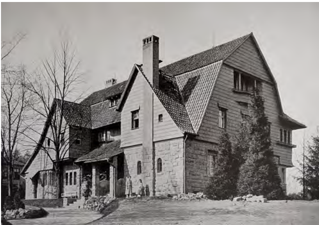
Abb. 129: Berlin-Wannsee, Landhaus Springer (Alfred Messel, 1901–02). Sowohl in der gebrochenen Dachgestaltung (sog. amerikanisches Gambrel-Dach), der Verschindelung als auch im asymmetrisch in die Giebelfront hineingestalteten Schornstein sind Parallelen zum bei Graef/Hinckeldeyn abgebildeten Wohnhaus Jamieson erkennbar. Die Gambrel-Form wurde im Heimatstil weitem zu einem bevorzugten Giebelmotiv. – Muthesius 1905a, 19.
