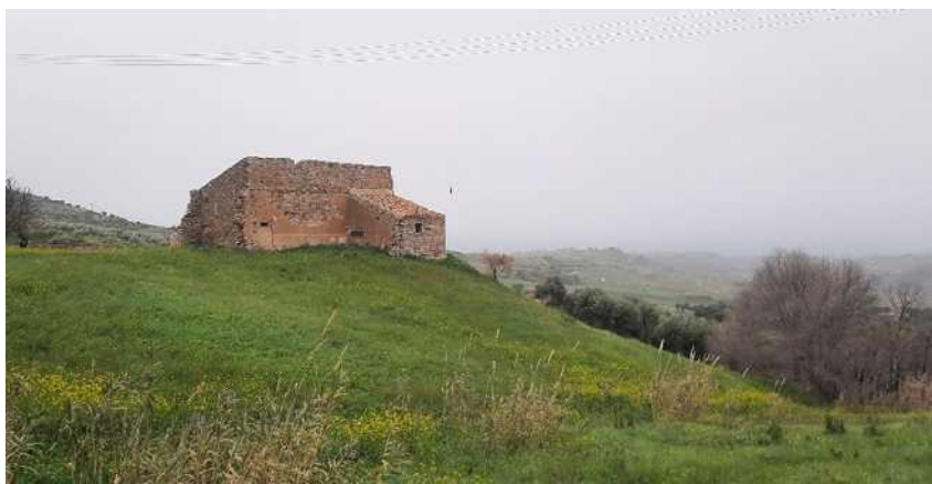
Figura 4. Burgitabis. Veduta da Sud-Est (foto dell'autore).
