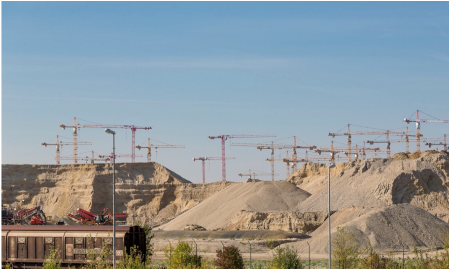
ABBILDUNG 3 Aushubverwertung auf der Baustelle in Wien Aspern, Seestadt: 2014 (Wien 3420 aspern Development AG / Ludwig Schedl, CC-BY SA)
