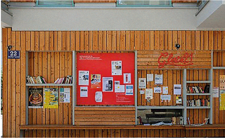
ABBILDUNG 3 Nachbarschaftswand an der Fassade des Wohnprojekts Gleis 21 im Sonnwendviertel Ost. Architektur: einzueins Architektur. (Foto: Herzi Pinki, CC BY-SA)
