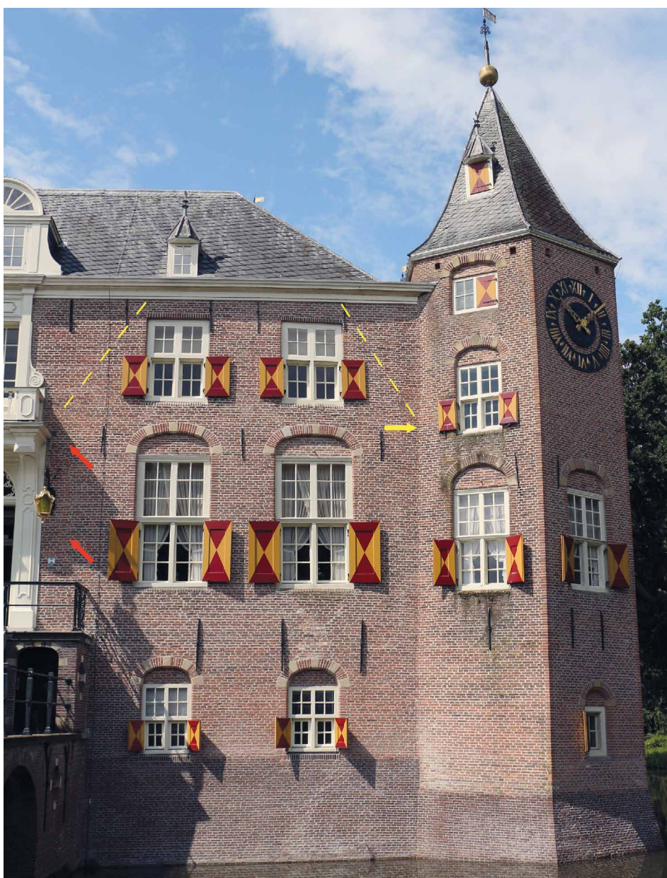
Afb. 34. Rechterdeel van de oostgevel. Onder de gele pijl is de aansluiting weliswaar niet oorspronkelijk, maar wel vrij regelmatig. Bij de latere aanbouw van de toren werd het metselwerk in verband aangesloten. Boven de gele pijl sloot het metselwerk van de gevel aanvankelijk niet aan op de toren omdat de gevel van de noordvleugel nog een opzet met topgevel had (gele stippellijn). Aan de linkerzijde is ter hoogte van de rode pijlen een verticale bouwnaad herkenbaar. Ook aan deze zijde tekent zich de eerdere topgevel nog af in een slordige schuine bouwnaad (gele stippellijn). Foto auteur.
