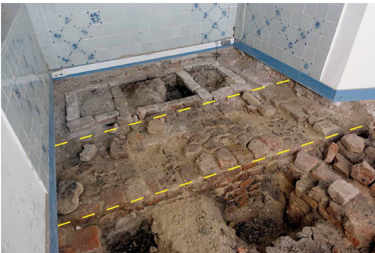
Afb. 19. Bij ontmanteling van de keukenvloer (S.9) kwam de fundering van een eerdere zuidgevel in het zicht (afb. 17-1). Op de achtergrond de huidige zuidgevel. Tussen beide muren structuren, behorend bij de in deze zone aangelegde stookplaats. Foto auteur.
