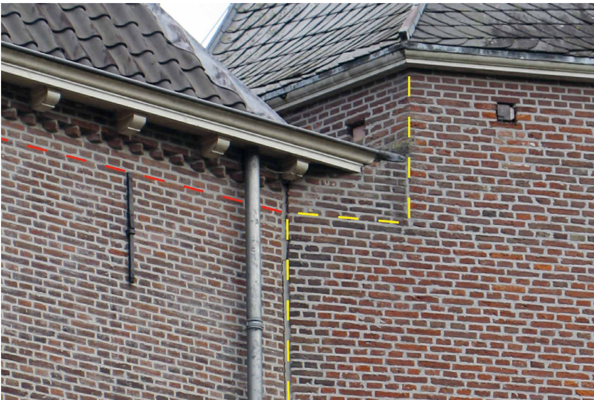
Afb. 22. Aansluiting van de zuidwestelijke hoektoren (rechts) op de westgevel. Het bovenste deel van de toren heeft een regelmatige zeshoekige vorm met rode geslepen stenen op de buitenhoek. Tot ongeveer 20 lagen onder de daklijst liep de torengevel verder naar links door volgens de gestippelde contour, mogelijk om aan te sluiten op een op dat moment al aanwezig ouder bouwdeel, waarvan de rode lijn de bovenzijde markeert. Na 1673 werd de huidige westgevel gebouwd en de torengevel nog iets opgehoogd. Foto auteur.
