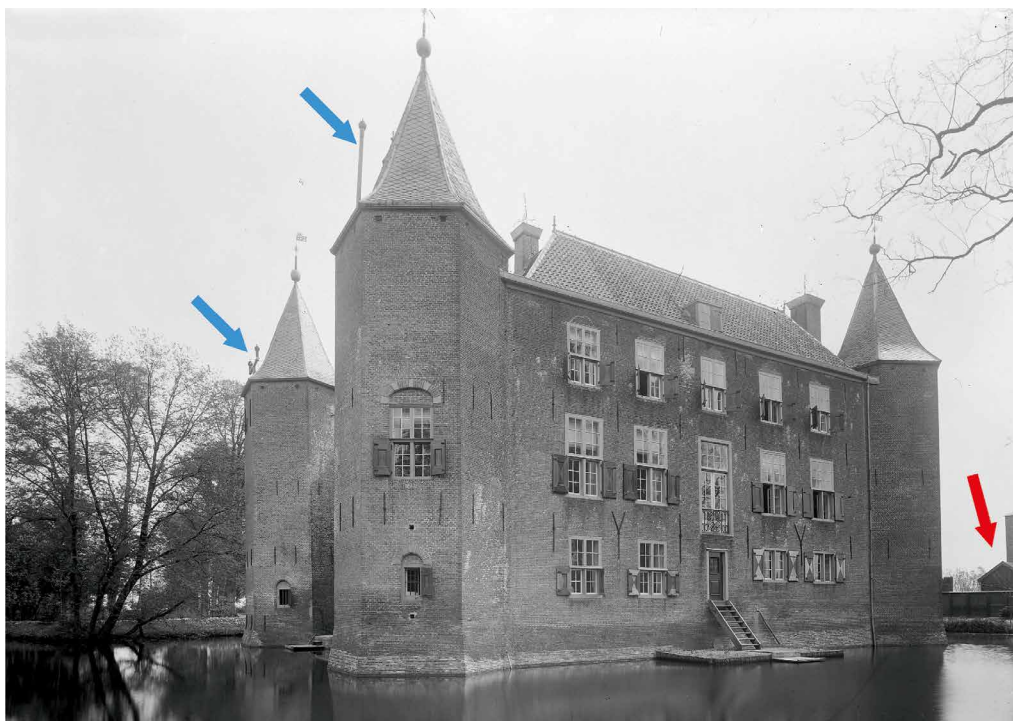
Afb. 78. Ook van de noordwesthoek van het kasteel werd omstreeks 1900 een foto gemaakt. De kleine souterrainvensters in de torens hadden nog tralies. Rechts van het kasteel is de acetyleenfabriek zichtbaar (rode pijl). Op de noordelijke torens waren de achttiende-eeuwse schoorstenen vervangen door opmerkelijke hoge rookgasafvoeren (blauwe pijlen). RCE, nr. BT-1876.
