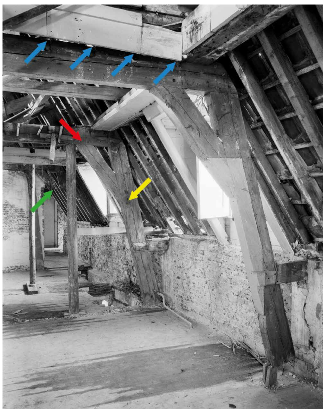
Afb. 39. Zicht in westelijke richting op de spanten bij de noordgevel (1.11/1.13) in 1961. Het geheel maakt een verwaarloosde indruk. Bij de gele pijl is nog de aftekening van een gespijkerde windschoor herkenbaar. Bij de rode en gele pijl toognagels van de gepende verbindingen. Bij de groene pijl is nog een volgend (afgezaagd) spant herkenbaar. Bij de blauwe pijlen zijn kepen van kinderbinten in de dekbalk aanwezig. RCE, nr. 59.799 (G. Th. Delemare).
