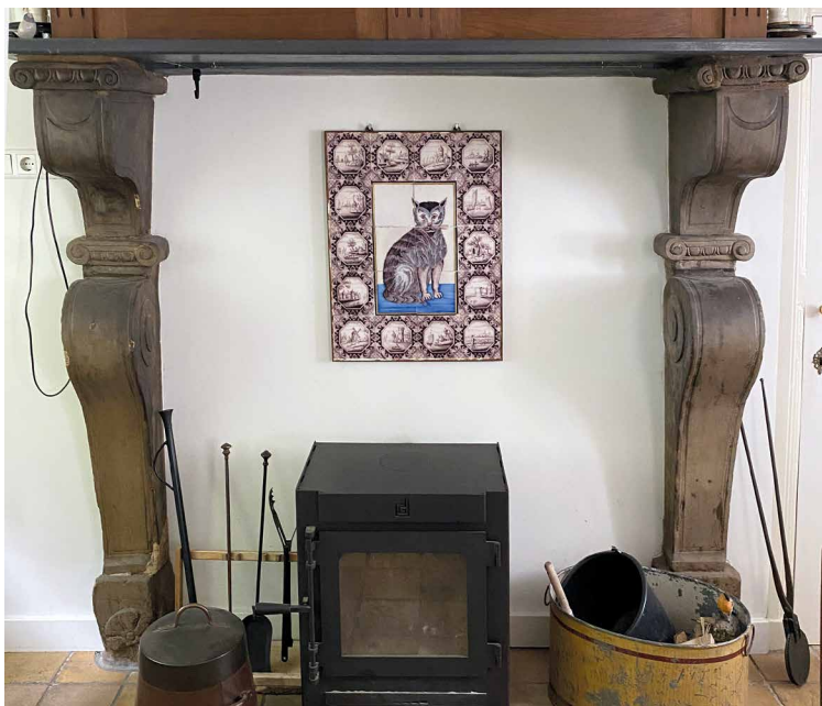
Afb. 16. Schouw met Maniëristische/Renaissance-kenmerken: dubbele rolornamenten afgedekt met voluten waaronder een eierlijst in grijsrode schilferende zandsteen. Intern verplaatst naar bouwphase I.
