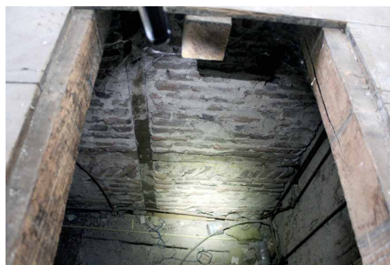
Afb. 34. Onder de vloer van de kamer 1.9 (zie afbeelding 35 voor de nummering) is te zien dat er aanzienlijk veel loze ruimte is tussen deze vloer en het onderliggende plafond van de dienkamer (ruimte 0.16). Foto auteur 2020.
