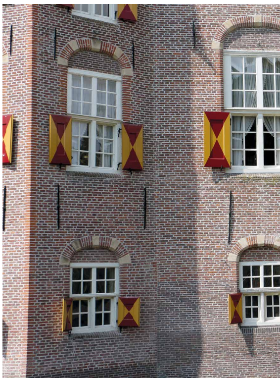
Afb. 57. Aansluiting van de oostgevel (rechts) op de zuidoostelijke hoektoren. Hoewel beide delen in verband aansluiten, wijst de onregelmatigheid erop dat beide delen niet tegelijk tot stand kwamen. Rechts van de aansluiting is het metselwerk bovendien iets regelmatig en net iets lichter van kleur. Foto auteur.
