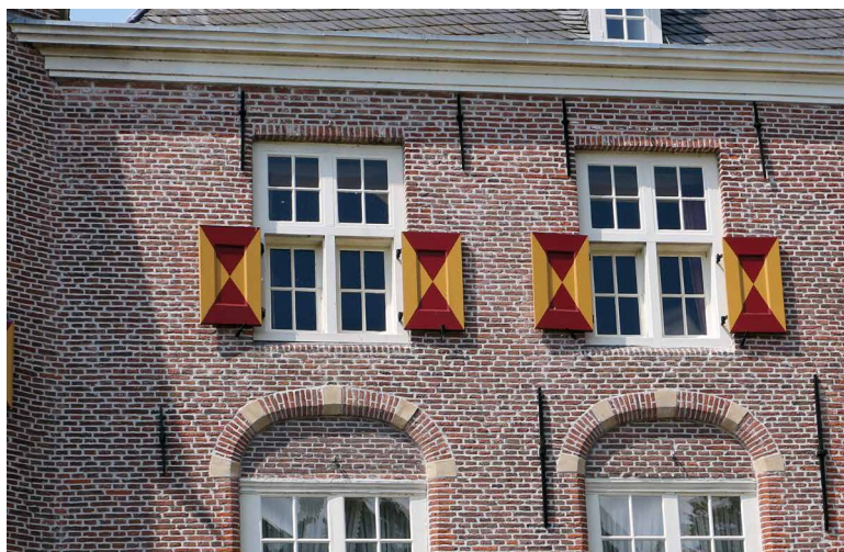
Afb. 45. Linker bovenhoek van de oostgevel. Aan de gewijzigde dagkanten zonder profilering is herkenbaar dat de vensters van de verdieping werden verbreed. Foto auteur.
