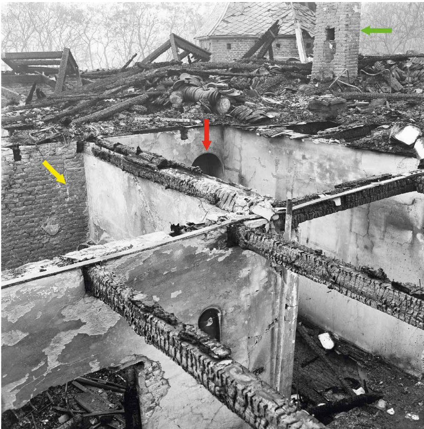
Afb. 88. Zicht over de gang (1.2) richting de zuidwestelijke toren (locatie 3 op afb. 85). Links ruimte 1.5, waar bij de restauratie het trappenhuis werd ingevoegd. Geheel links de noordgevel van de poorttoren. Daar is metselwerk met een inconsequente afwisseling tussen koppen- en strekkenlagen aanwezig. Rechts is een niet oorspronkelijke opening dichtgemetseld (gele pijl). De ruimte ten westen van het trappenhuis (1.8) ontstond bij de restauratie. Binnen deze ruimte is in de noordmuur van de poorttoren een boogopening aanwezig (rode pijl). De schoorsteen op de achtergrond werd na de brand niet herbouwd (groene pijl). RCE, nr. 135.775 (G.J. Dukker).
