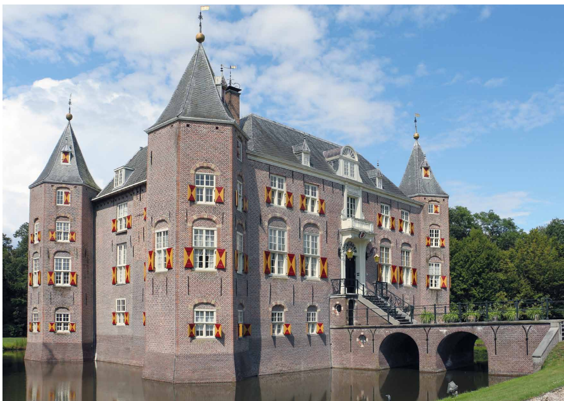
Afb. 2. Overzicht van de zuidgevel en de oostgevel met daarop aansluitende toegangsbrug. Foto auteur.
