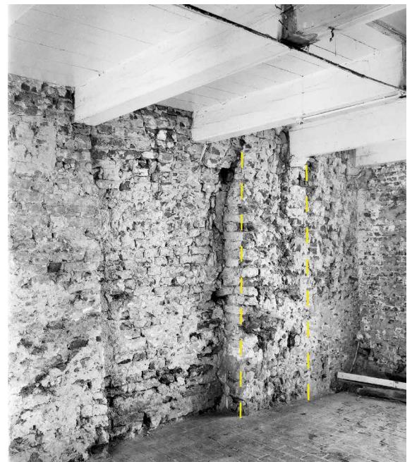
Afb. 20. Zicht in ruimte S.7 op de westzijde van de poorttoren op het niveau van het souterrain in 1961. Tussen de stippellijnen de eerdere aansluiting van de zuidgevel (afb. 14-5). RCE, nr. 59.797 (G.TH. Delemare).
