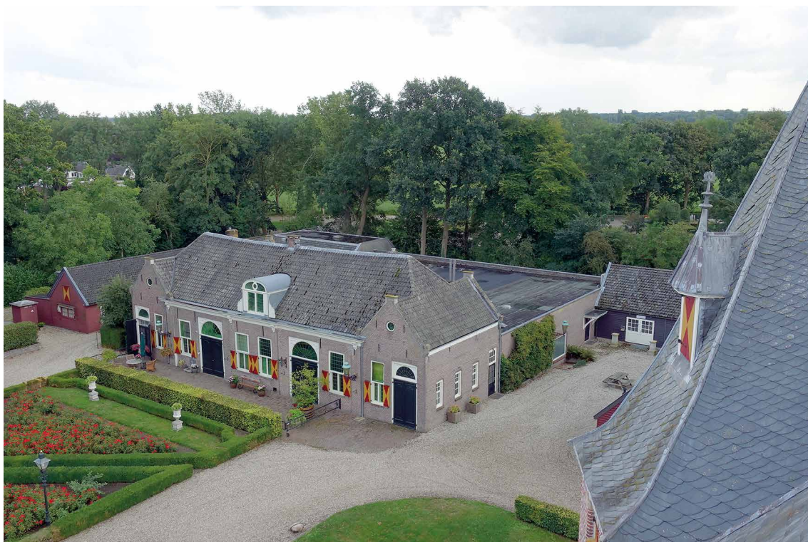
Afb. 5. Het fors naar achteren uitgebreide koetshuis, gezien vanaf het dak van het kasteel. Foto auteur.
