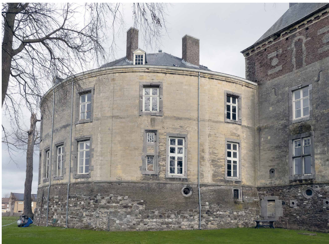
Afb. 4. De zuid- en westzijde van de ringmuur in 2021 voor het verwijderen van de aanhelingen en het opnieuw voegen in 2023. Het basement bestaat uit kolenzandsteen van vóór 1318, de mergel opbouw van ca 1560. Foto: Jan van Dalen fotografie.
