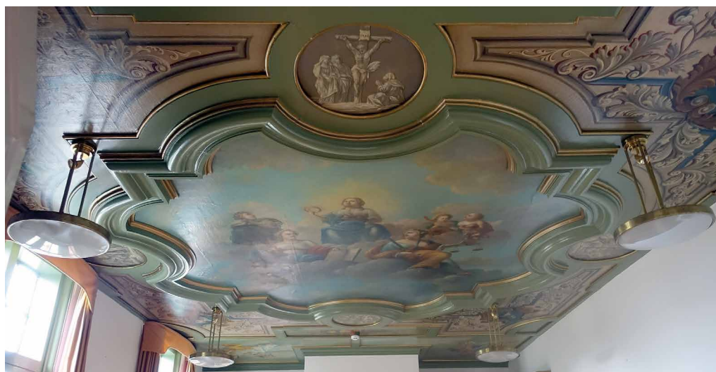
Afb. 13. Dit opmerkelijke achttiende-eeuwse plafond werd na de brand boven de linker voorkamer (1.3) op de verdieping aangebracht. Foto auteur.
