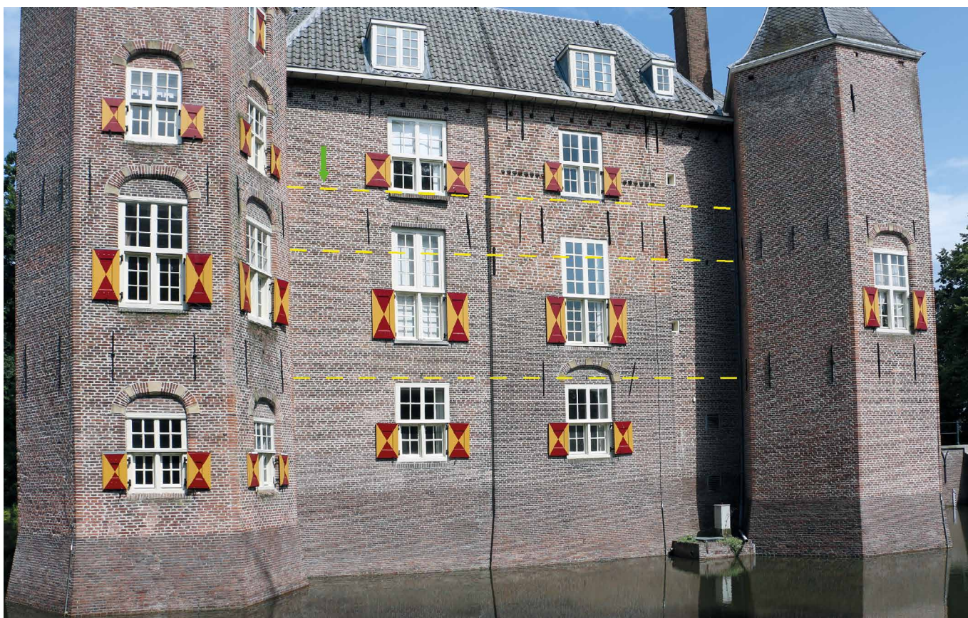
Afb. 55. Overzicht zuidgevel, met ter hoogte van de stippellijnen de sporen van de balkgaten. Bij de groene pijl de nog herkenbare dakaansluiting van de galerij. Foto auteur.
