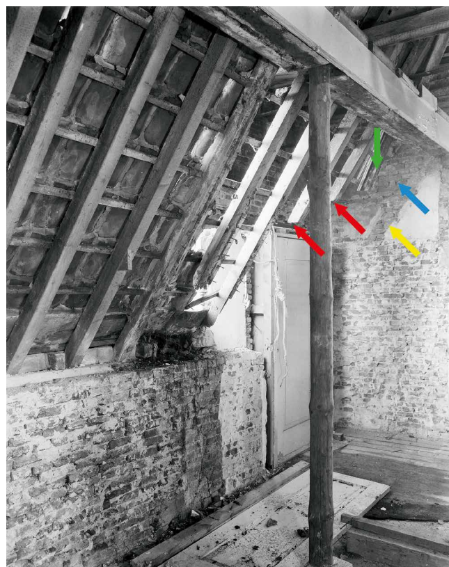
Afb. 40. Noordoosthoek van de verdieping (1.11). De sporen van het noordelijke dakvlak lopen ook ter hoogte van de hoektoren door omdat de toren wat later werd aangebouwd. Enkele sporen werden ingekort t.b.v. de latere doorgang (rode pijlen). Ook op de oostgevel tekent zich nog een spoor (gele pijl) en mogelijk zelfs de aansmeerlaag boven de pannendeckung af (blauwe pijl). Onder de groene pijl lijkt een verticale naad met daarnaast klezoren zichtbaar. Hierin kan de trap van een trapgevel herkend worden. Een gat in de vloer was 'hersteld' met een oude paneel deur. RCE, nr. 59.798 (G. Th. Delemare).
