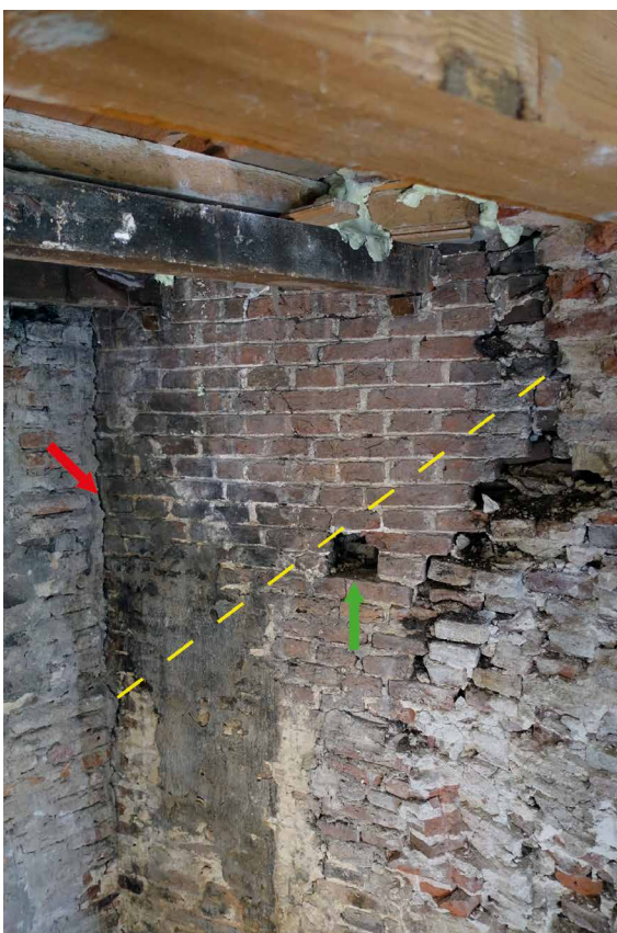
Afb. 46. Het bovenste deel van het binnen de zuidgevel gelegen gevelvlak van de zuidwestelijke toren is in schoon metselwerk uitgevoerd. Dit deel lag bij een eerste fase van de uitbreiding (afb. 48-3) boven het dak van de galerij, maar kwam later binnen de verplaatste zuidgevel te liggen. Links, bij de rode pijl, de koude aansluiting van de verplaatste zuidgevel op de torengevel. De lijn markeert de overgang tussen schoonwerk en vuilwerk en daarmee de eerdere daklijn. Bij de groene pijl is een balkgat van een fliering van het galerijdak zichtbaar. Rechtsonder restanten van de aansluiting van de eerder verder naar achteren gelegen zuidgevel. Foto auteur.
