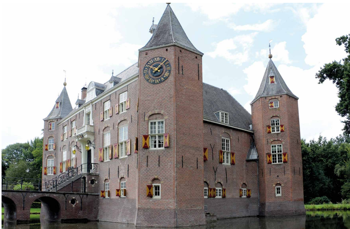
Afb. 4. De oostgevel en lagere noordgevel. Foto auteur.
