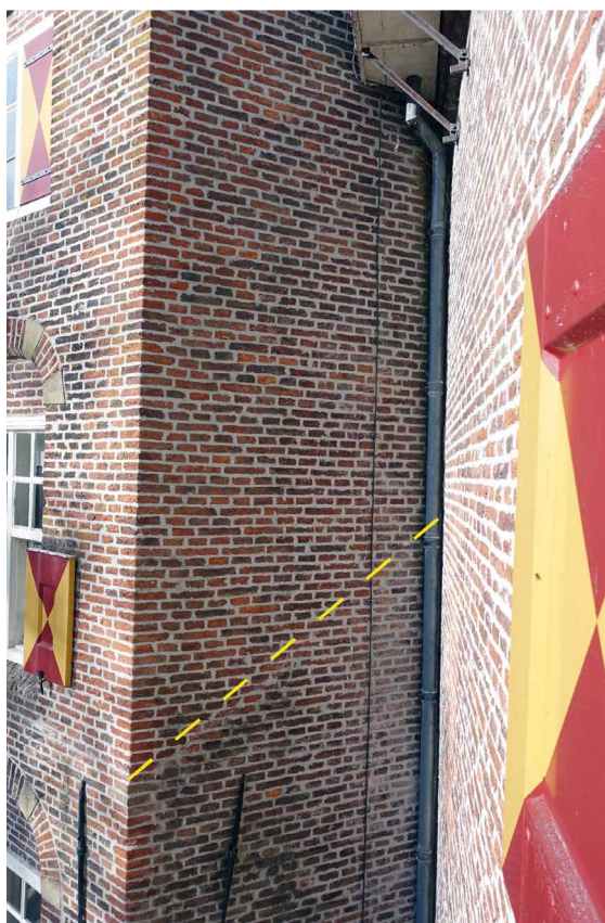
Afb. 47 Buitenaanzicht van het noordoostelijke gevelvlak van de zuidwestelijke toren. De daklijn van de galerij tekent zich hier duidelijk af (zie ook afb. 48-4 en 5). Foto auteur.
