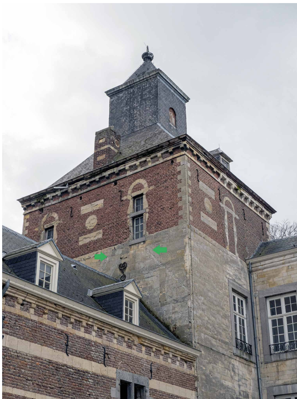
Afb. 28. De noordoostgevel van de zuidelijke hoektoren met bij de groene pijlen de daklijnen van het ooit hogere dak van de stalvleugel. Foto: Jan van Dalen fotografie.
