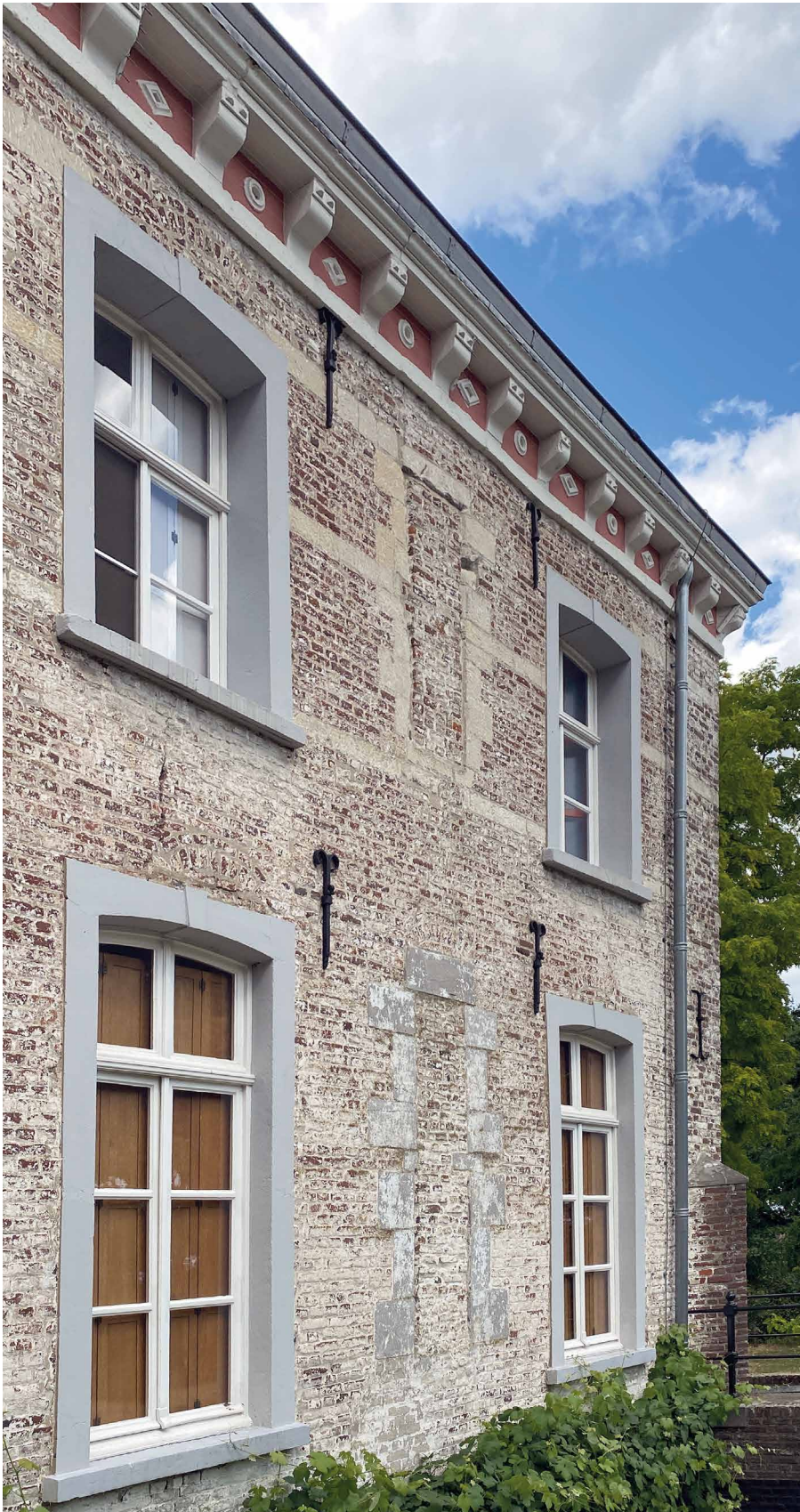
Afb. 10. Zuidgevel, op begane grond dichtgezette kloosterkozijnen in Naamse steen, op de verdieping in mergel (met enkele speklagen).
