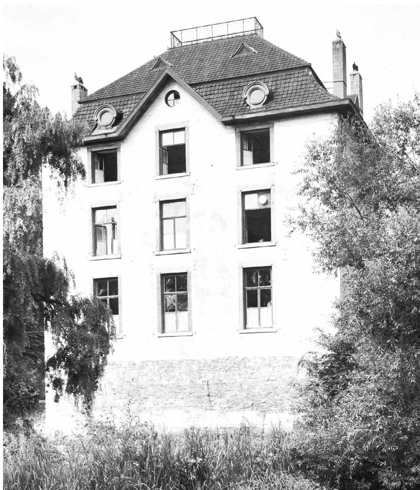
Afb. 16. Foto van de hoofdburcht van De Burgh vanuit het noordoosten in 1953. Op de foto zijn twee rookkanalen in de noordgevel te zien, maar deze kragen niet uit zoals op de tekening van Van Gulpen. Coll. RCE, inv.nr. 044586.
