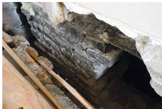
Afb. 32. Ter hoogte van de verdiepingvloer vanuit de middengang (1.2) geconstateerd zichtwerk van de zuidelijke bouwmuur van de noordvleugel (afb. 33-3). Foto auteur.
