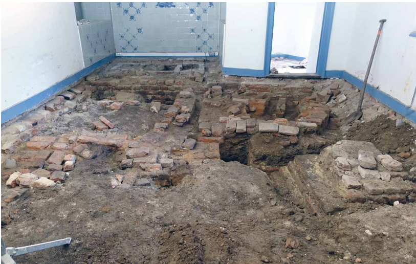
Afb. 18. Overzicht van de in juni 2024 onder ruimte S.9 aangetroffen funderingen, gezien in zuidelijke richting. Rechts de toegang tot de zuidwestelijke toren (S.10). Foto auteur.
