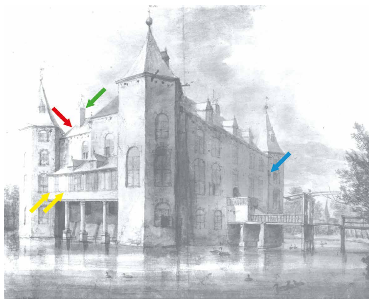
Afb. 44. Tekening van kasteel Nederhorst uit het zuidoosten in 1647 door Roelant Roghman (1627–1692). De poorttoren was waarschijnlijk al verlaagd. Bij de rode pijl de aansluiting van de zuidgevel op de zuidwestelijke toren. Het perspectief lijkt hier niet geheel juist te zijn weergegeven. De groene pijl wijst naar de hoog op het dakvlak geplaatste schoorsteen. Deze werd vermoedelijk verslept vanaf de zuidgevel. De galerij wordt bij de gele pijlen met twee gesloten vlakken getekend. Bij de blauwe pijl is een vergaarbak van de goot aan de noordgevel aanwezig. De lijstgevel loopt hier als schijngewel langs het noordelijke dakvlak. Particuliere collectie.
