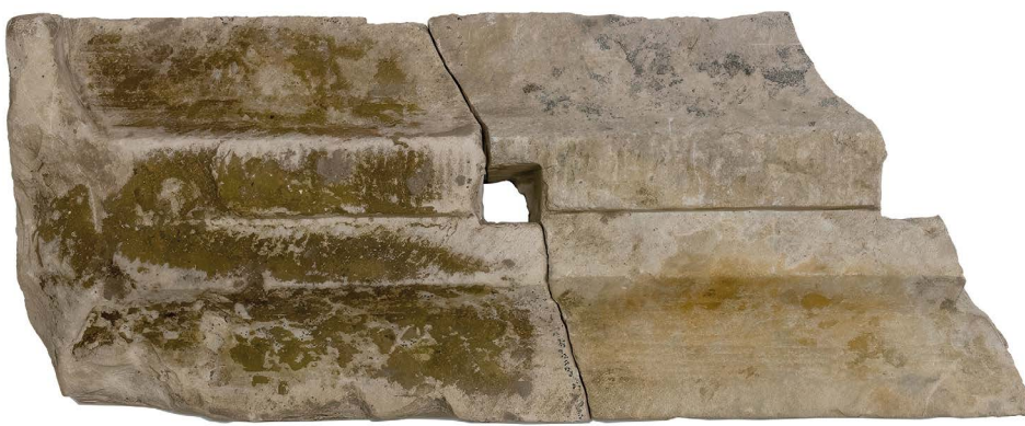
Afb. 20. Twee aan elkaar passende fragmenten van Bentheimer zandsteen, afkomstig van de horizontaal liggende tussendorpel van een raamkozijn van gebouw 2. Deze tussendorpel scheidde een bovendeel met glas-in-loodramen van een onderdeel met verticale diefijzers. In de dorpel zijn vierkante uitparingen voor de diefijzers te zien. Er was sprake van een waterhol, hetgeen duidt op een horizontale positie van dit stuk. Foto door BAAC.
