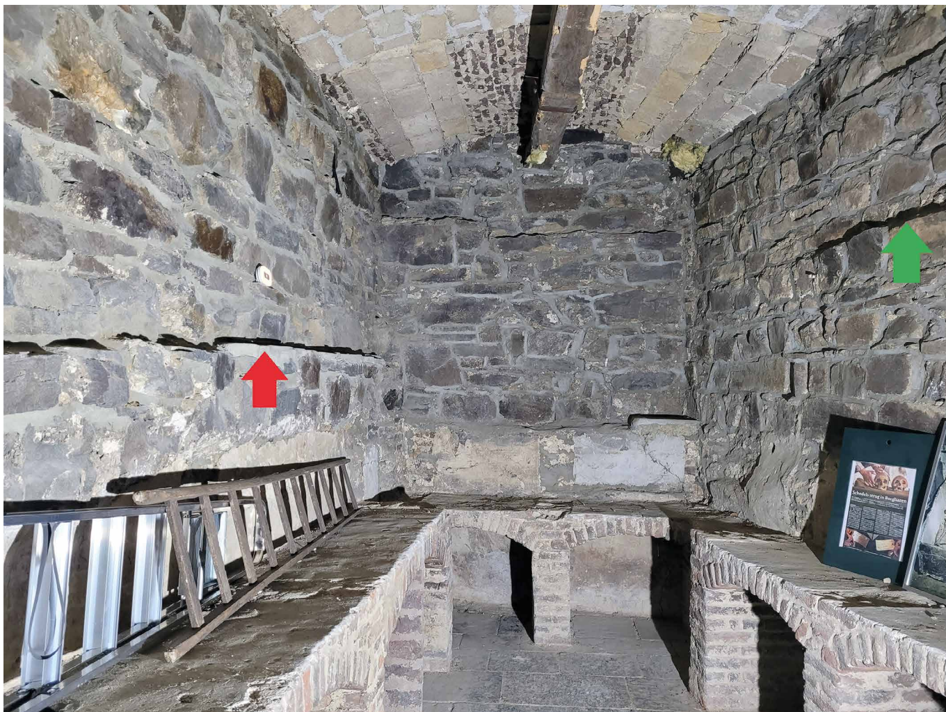
Afb. 9. Ruimte -1.4 (gezien naar het zuiden) met links de buitenzijde van de woontoren met snijlaag (rode pijl) en rechts de ringmuur met eveneens een snijlaag (groene pijl). Zie voor de ruimtenummers afb. 3. Foto auteur 2024.
