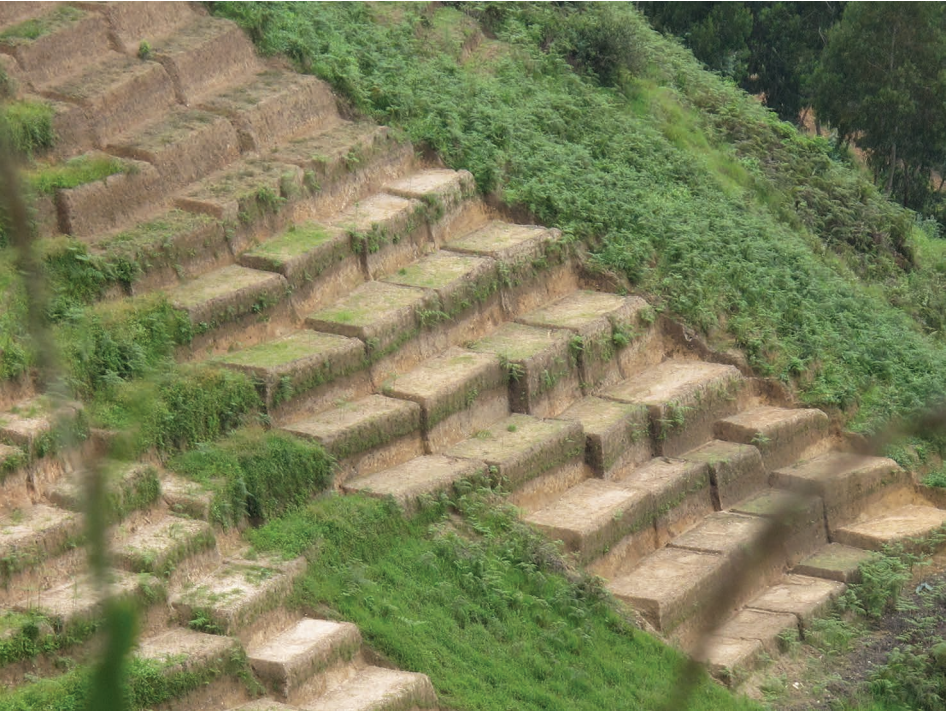
Photo 6.4. Le mythe techniciste de la terrasse radicale, région des monts Uluguru, Tanzanie, (Cochet, 2016). Érosion accrue et abandon, comme le démontre ce versant aménagé en contrebas de la paroisse de Tchenzema.
