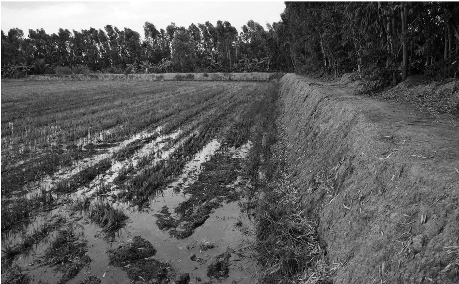
Figure 4.24. Digues dans la commune de Thiện Trí (Champeaux, 2016).
