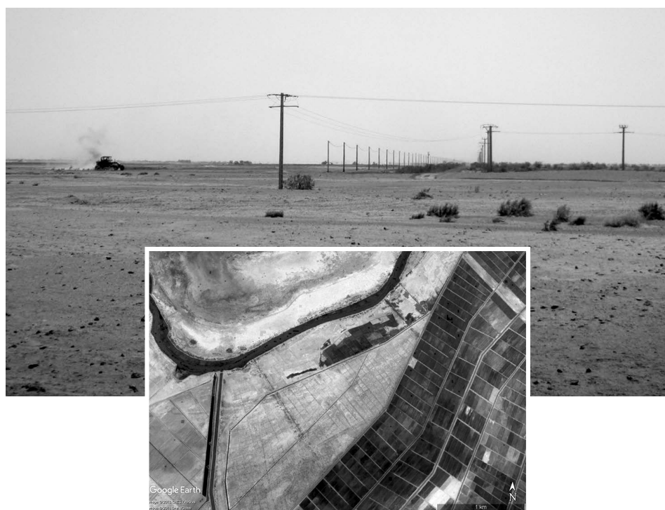
Figure 5.15. Travaux en cours en 2016 au sein du futur périmètre 3PRD dans le haut delta en haut et vue satellite du périmètre 3PRD en 2018 en bas (Garambois, 2016 ; Google Earth, 2018).
