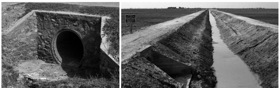
Figure 4.10. Canaux de périmètre irrigué collectif (Ducourtieux, 2014).
