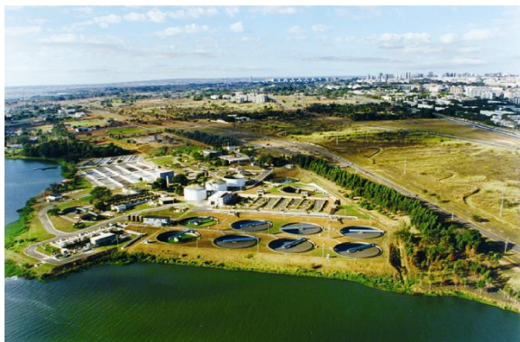
شكل ٤-٩ واحدة من محطتي معالجة مياه الصرف الصحي في برازيليا بالبرازيل (صورة R. Brummer)
