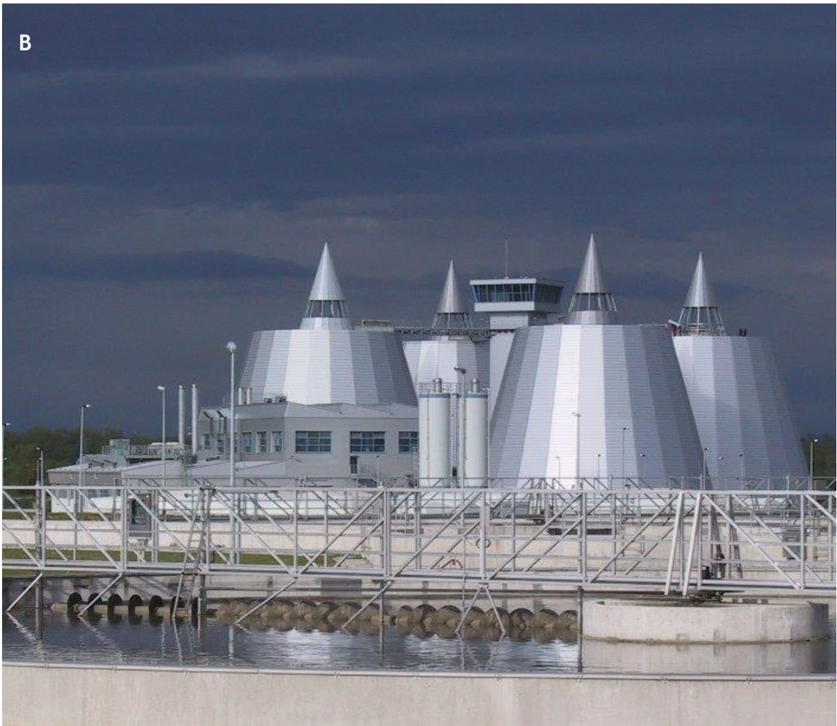
محطة معالجة مياه صرف صحي في زغرب (كرواتيا) مصممة لإزالة COD. وتم توفير إمكانيات التطوير والتوسع المستقبلي (أ). يحدث هضم الحمأة لاهوائيًا في أربعة مفاعلات مصممة بشكل مستقبلي (صورة: Zagrebačke Otpadne Vode d.o.o.)
