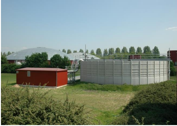
شكل رقم ٦-١٢ تطبيق كامل النطاق لتقنية BABE®: محطة معالجة مياه الصرف الصحي في هولندا (من الأمام: مفاعل الإضافة الحيوية؛ صورة: DHV B.V.)
