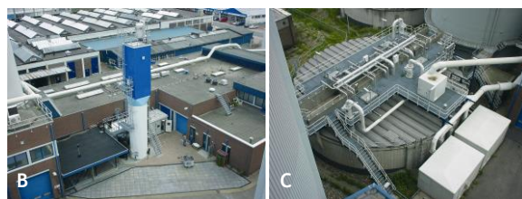
شكل رقم ٦-٩ (أ) منظر جوي لمنشآت معالجة الحمأة في محطة Dokhaven لمعالجة مياه الصرف الصحي و(ب) منظر لمفاعل الأناموكس (ج) مفاعل SHARON® من قمة هاضم الحمأة (صورة: Water Board Hollandse Delta)
