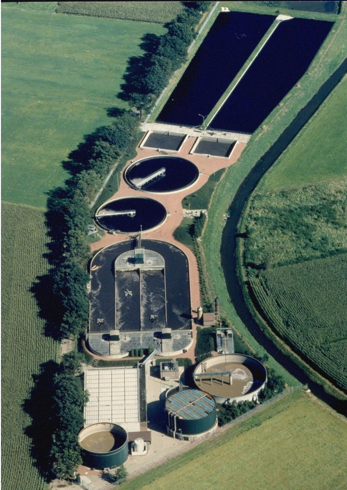
تطبيق مفاعل غطاء حمأة لاهوائي على نطاق كامل : محطة معالجة صرف صناعي من مصنع للبييرة في بافاريا ، ليسوث ، هولندا. ومفاعل غطاء الحمأة اللاهوائي موضوع في مقدمة العرض (photo: J.B. van Lier by courtesy of Bavaria N.V.).
