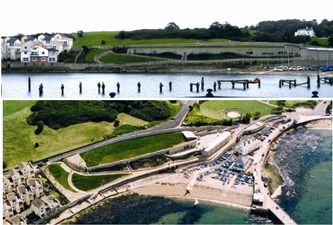
شكل ١٣-٢١ منظر عام لأعمال محطة مجاري "سواناج" من البحر ومن الجو.
