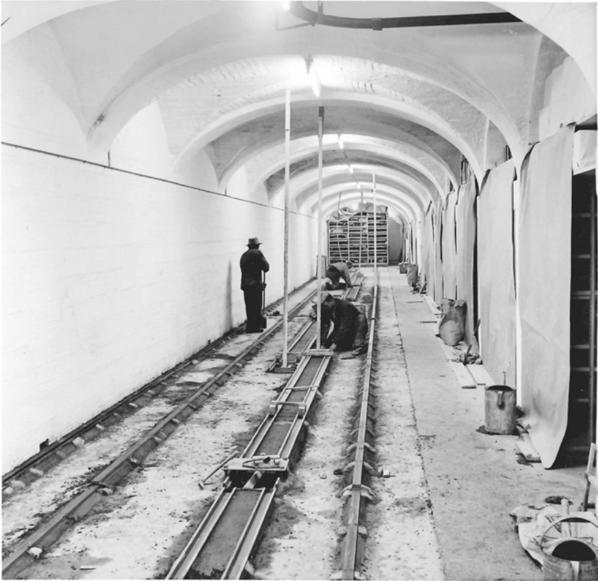
Abb. 2: Einbetonieren der Schienen für die erste Rollregalanlage in Bern, 1952 im Gewölbekeller der Stadt- und Universitätsbibliothek an der Münsterstrasse (© Burgerbibliothek Bern)
