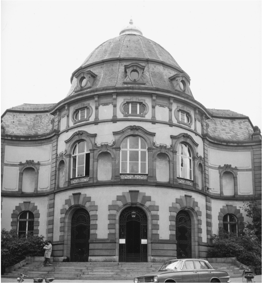
Abb. 2: Eingang zum Hauptgebäude der UB vor dem Abriss (© UB Basel)
