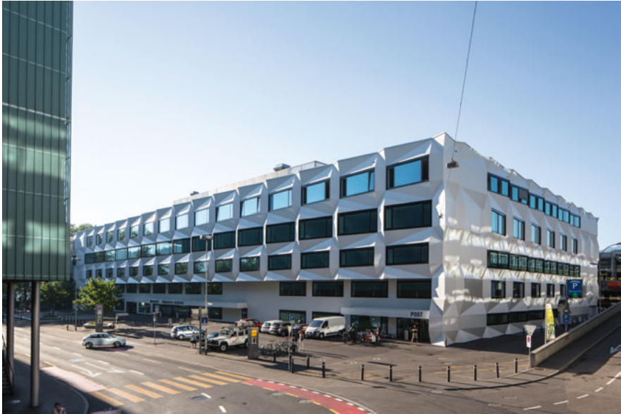
Abb. 4: Gebäude der Universität Luzern und der PH Luzern; die Bibliothek ist im 1. Geschoss, über der Post (© Ulrich Niederer, ZHB Luzern)
