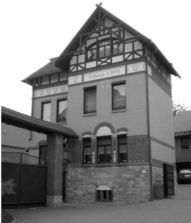
Wohnhaus von Gustav Bach – Fassade und Hofansicht (2007)
