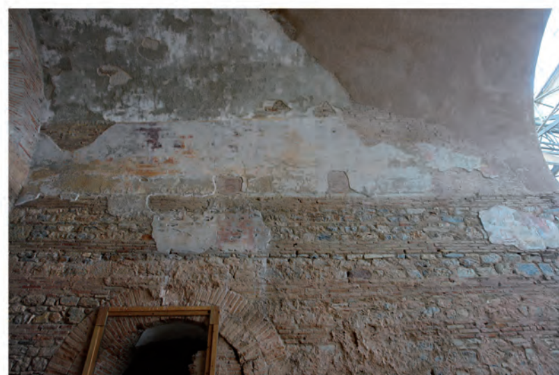
Abb. 45: Apsidensaal 8, W-Seite des Gewölbes, gesamt
