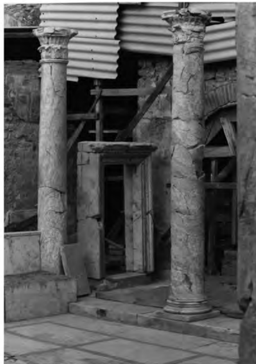
Abb. 11: Peristylhof 31aW, Marmortürrahmen A 38 nach der Konservierung
