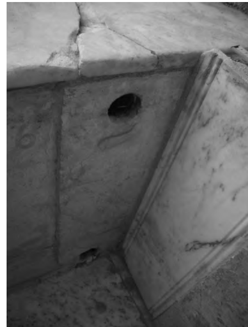
Abb. 30: Peristylhof 31a, Brunnen WB-A3, Wasserabfluss am O-Ende des Beckens
