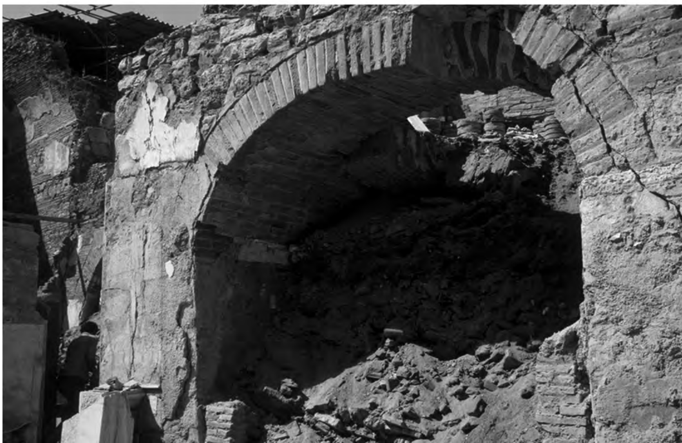
Abb. 39: Raum 36c mit eingestürztem Gewölbe und Hypokaustum in 36c.1
