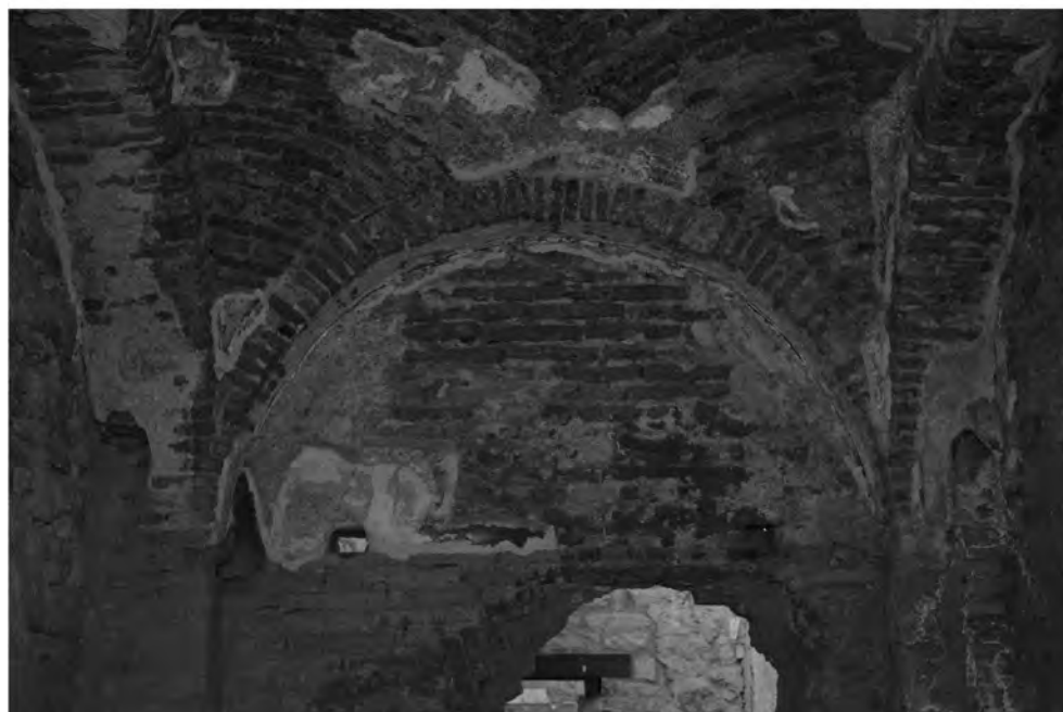
Abb. 3: Tonrohre als Rauchabzug im Bad 31aO/M2
