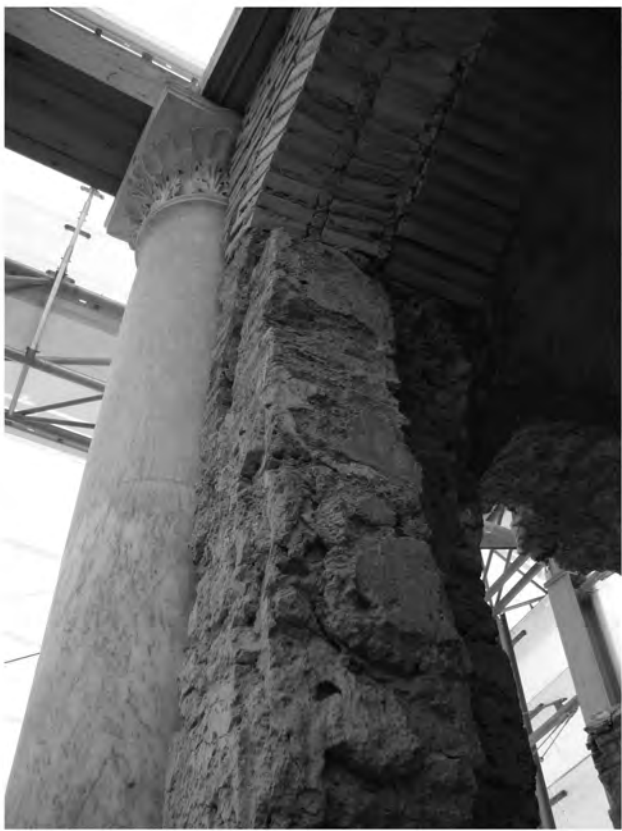
Abb. 71: Fenster im Peristylhof 31aO zum Raum 31aO/M1, Abdruck des Holzrahmens an der N-Seite
