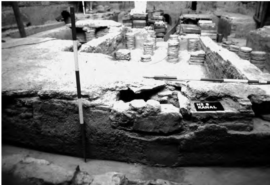
Abb. 37: Apsidensaal 8, Bodenwasserbecken WB-A5, sekundär abgemauerter Wasserablauf
