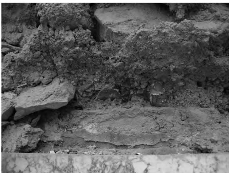
Abb. 4: Reste von Fensterrahmen und Fensterglas in 31aO
