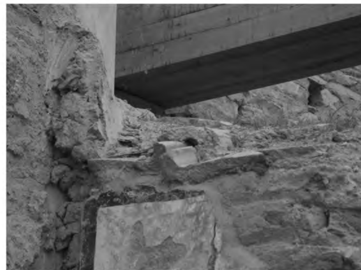
Abb. 45: Peristylhof 31a, Apsidenbecken WB-B4, Reste der Ziegeldeckung
