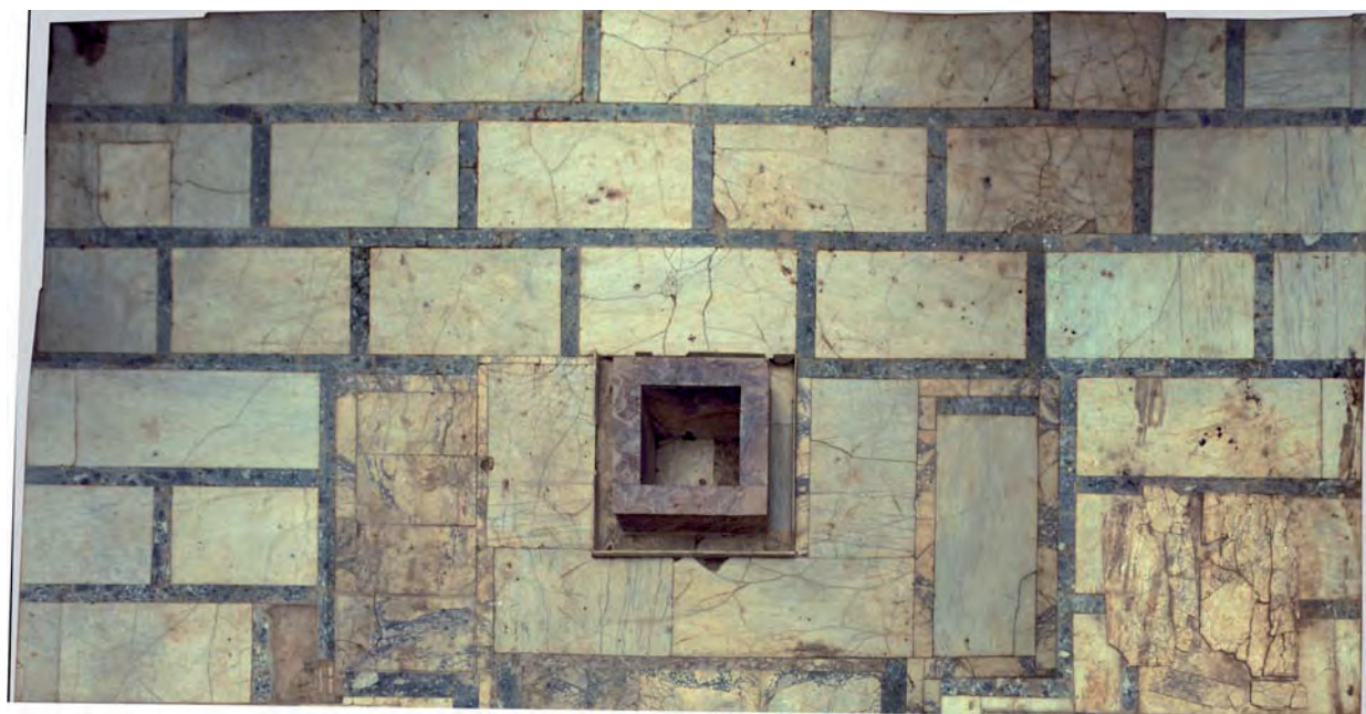
Abb. 2: Marmorsaal 31, Bodenbelag im N-Teil des Raumes
