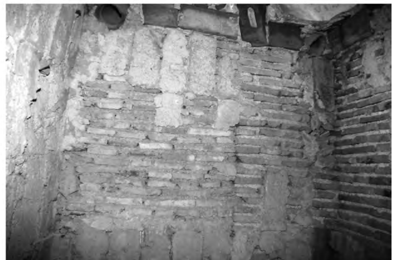
Abb. 31: Raum 8c, Decke mit Rohrleitungen
