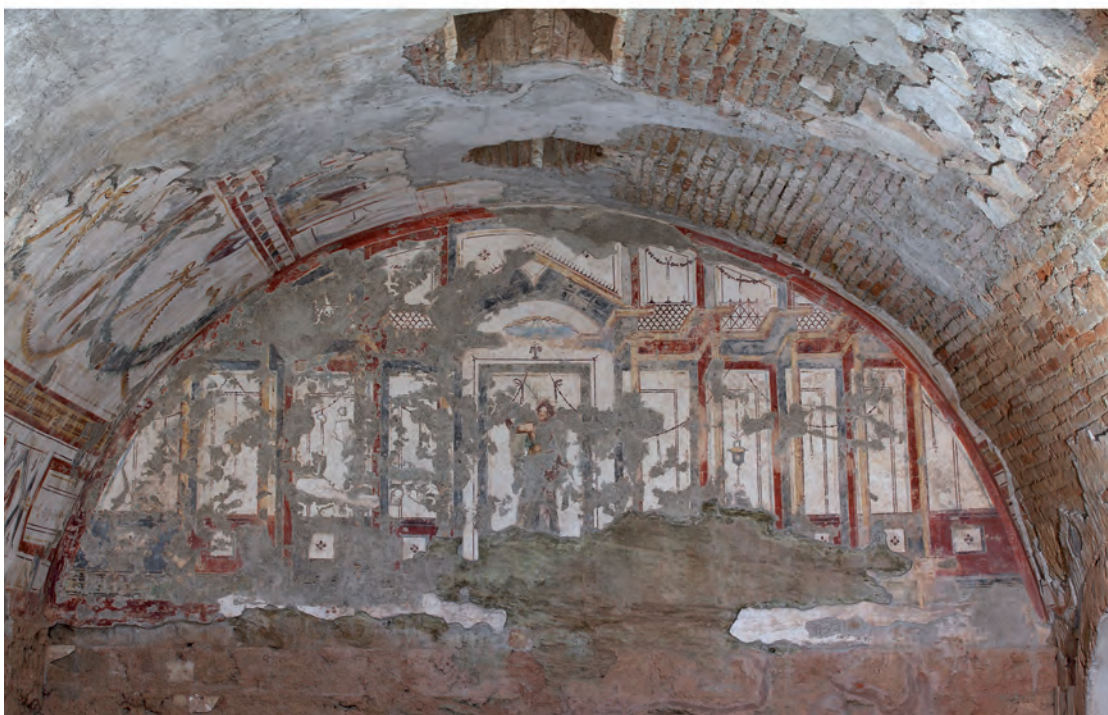
Abb. 24: Raum 36a, W-Wand, Bogenfeld mit Architekturmalerei
