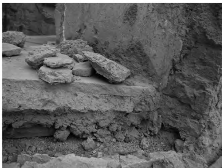
Abb. 46: Peristylhof 31a, Apsidenbecken WB-B4, Spuren der Fensterrahmung
