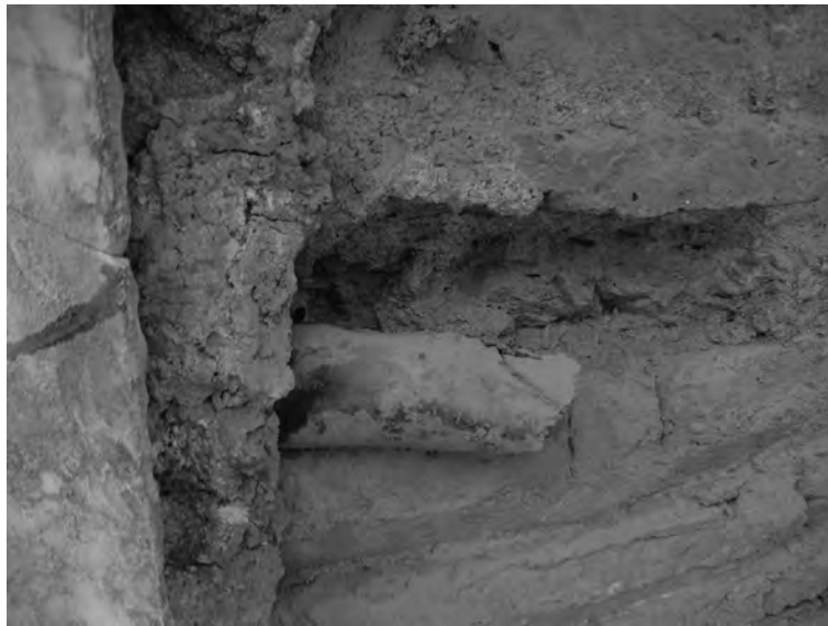
Abb. 29: Peristylhof 31a, Brunnen WB-A3, Wasserzuleitung an der Außenseite des Apsidenbeckens WB-B4
