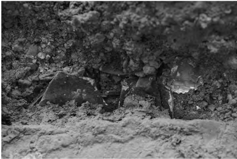
Abb. 5: Peristylhof 31a, O-Kolonnade mit Resten von Fensterglas in der zugemauerten Öffnung von 31aO/M2
