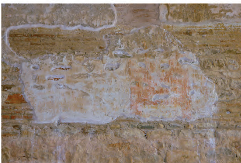
Abb. 44: Apsidensaal 8, Scheitel des Gewölbes
