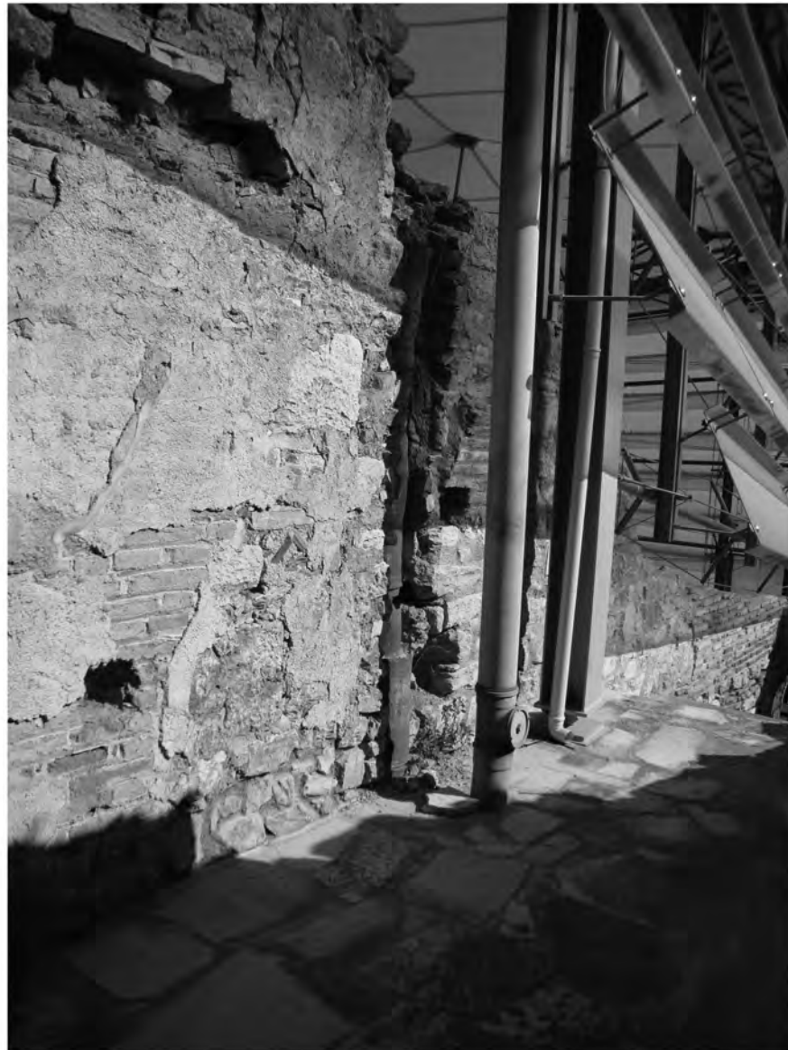
Abb. 1: O-Fassade der WE 6 in der STG 1 mit Tonrohr (Dachentwässerung)
