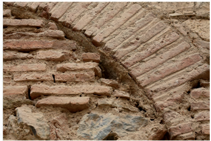
Abb. 2b: Mörtelbettung des Laibungsmosaiks
