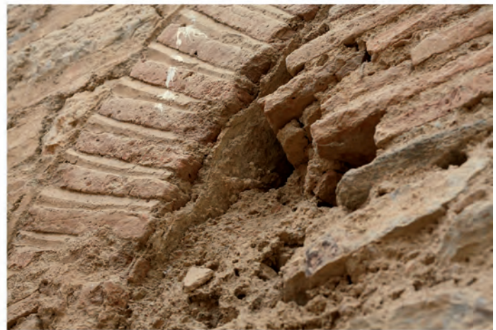
Abb. 2c: Mörtelbettung des Laibungsmosaiks
