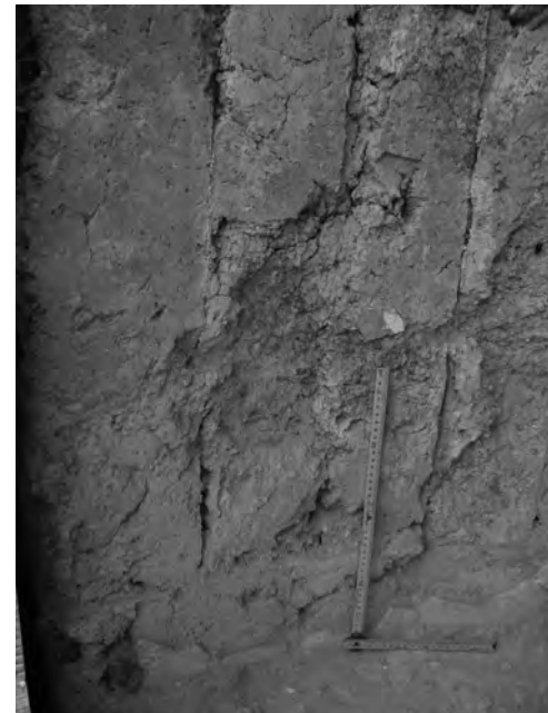
Abb. 23: Marmorsaal 31, Apsisbrunnen WB-A2, Abdrücke der Marmorverkleidung
