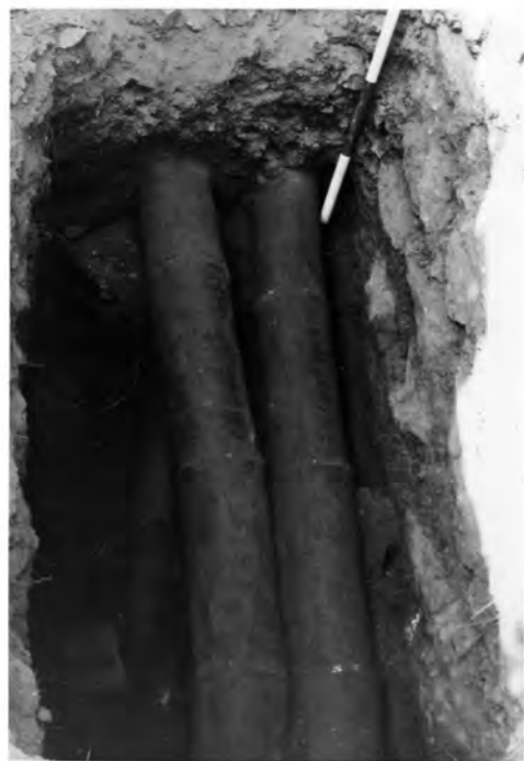
Abb. 36: STG 1, Fundamentgrabung F 12/6 mit freigelegten Wasserleitungen
