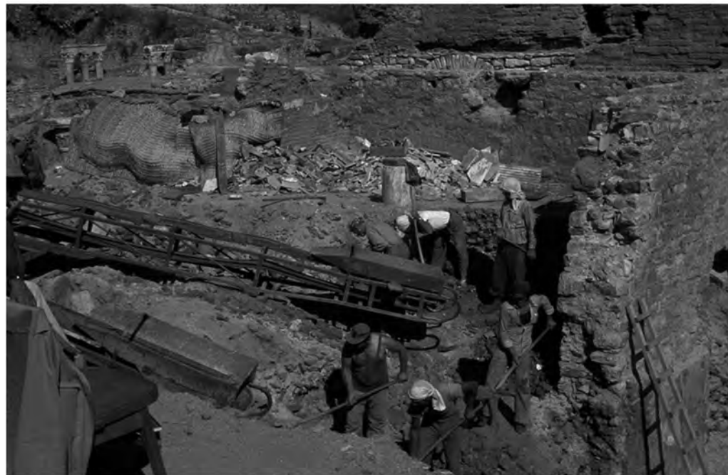
Abb. 11: Peristylhof 31a, Freilegung im SO-Bereich
