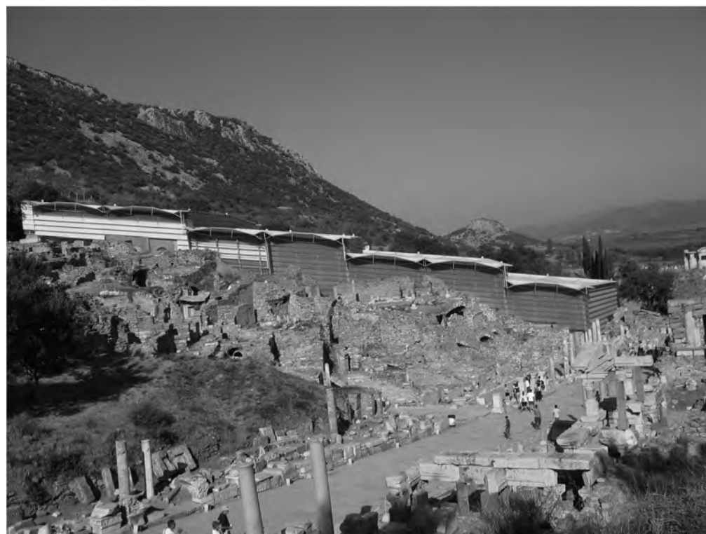
Abb. 48: Schutzbau im Jahr 2000, O-Ansicht von der Kuretenstraße
