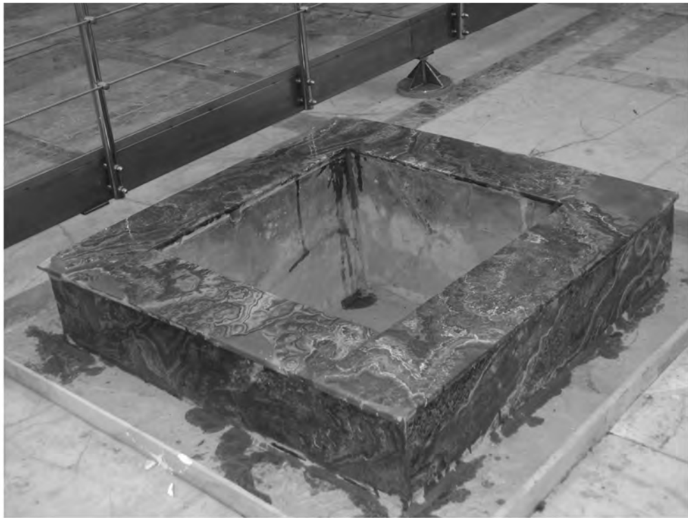
Abb. 22: Marmorsaal 31, Bodenwasserbecken WB-A4 im N-Teil
