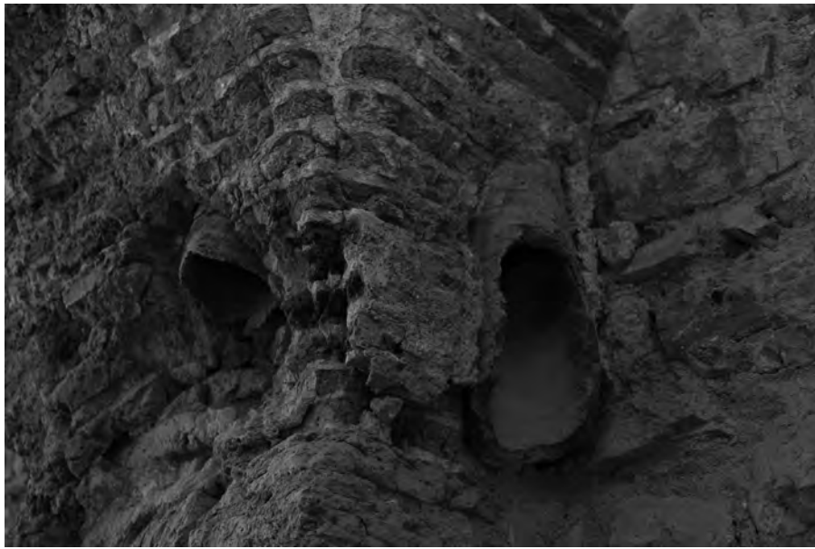
Abb. 4: Tonrohre als Rauchabzug im Bad 31aO
