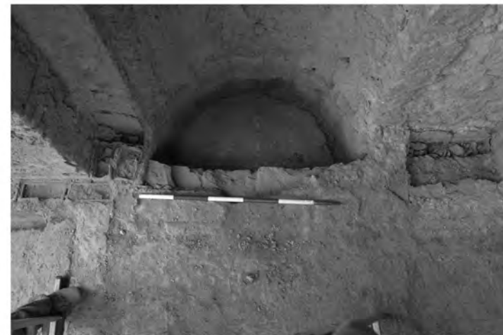
Abb. 43: Raum 31aO/M1, Badebecken WB-B2 in der O-Mauer
