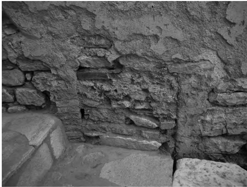
Abb. 1: STG 1, vermaueres Praefurnium zum Raum 31aO/M2
