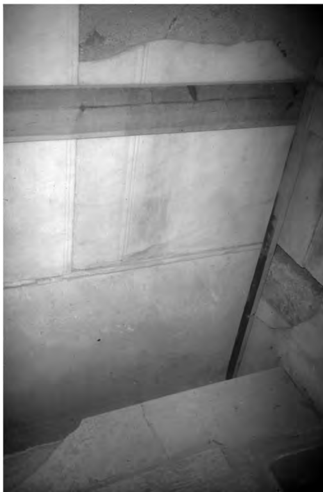
Abb. 17: Latrine 36bL, W-Mauer mit Kanal
