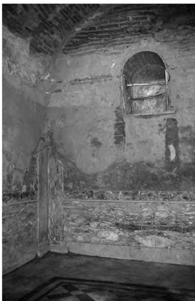
Abb. 30: Raum 36c mit Nische in der W-Mauer
