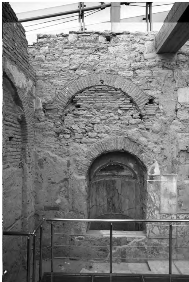
Abb. 44: Raum 31aSO/M3, Badebecken WB-B3 in der O-Mauer
