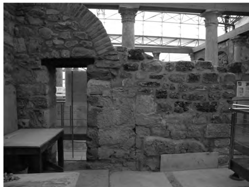
Abb. 5: Marmorsaal 31, N-Mauer nach der Restaurierung
