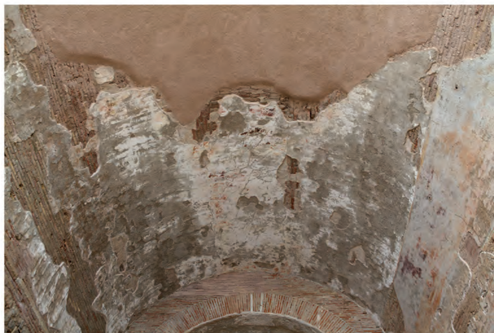
Abb. 43: Apsidensaal 8, westliches Gewölbe
