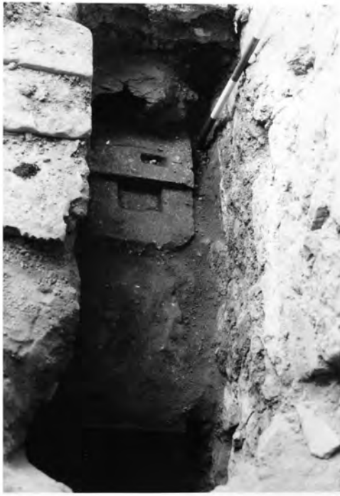
Abb. 34: Peristylhof 31a W-Umgang, Fundamentgrabung F 7/6, N-S-Kanal mit Einmündung
