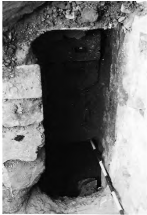
Abb. 35: Peristylhof 31a W-Umgang, Fundamentgrabung F 7/6 N-S-Kanal mit Einmündung, Detail
