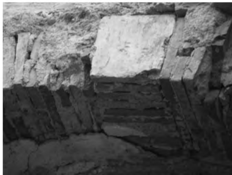
Abb. 12: Raum 36c, Gewölbedecke im System „pitched brick barrel vaulting“
