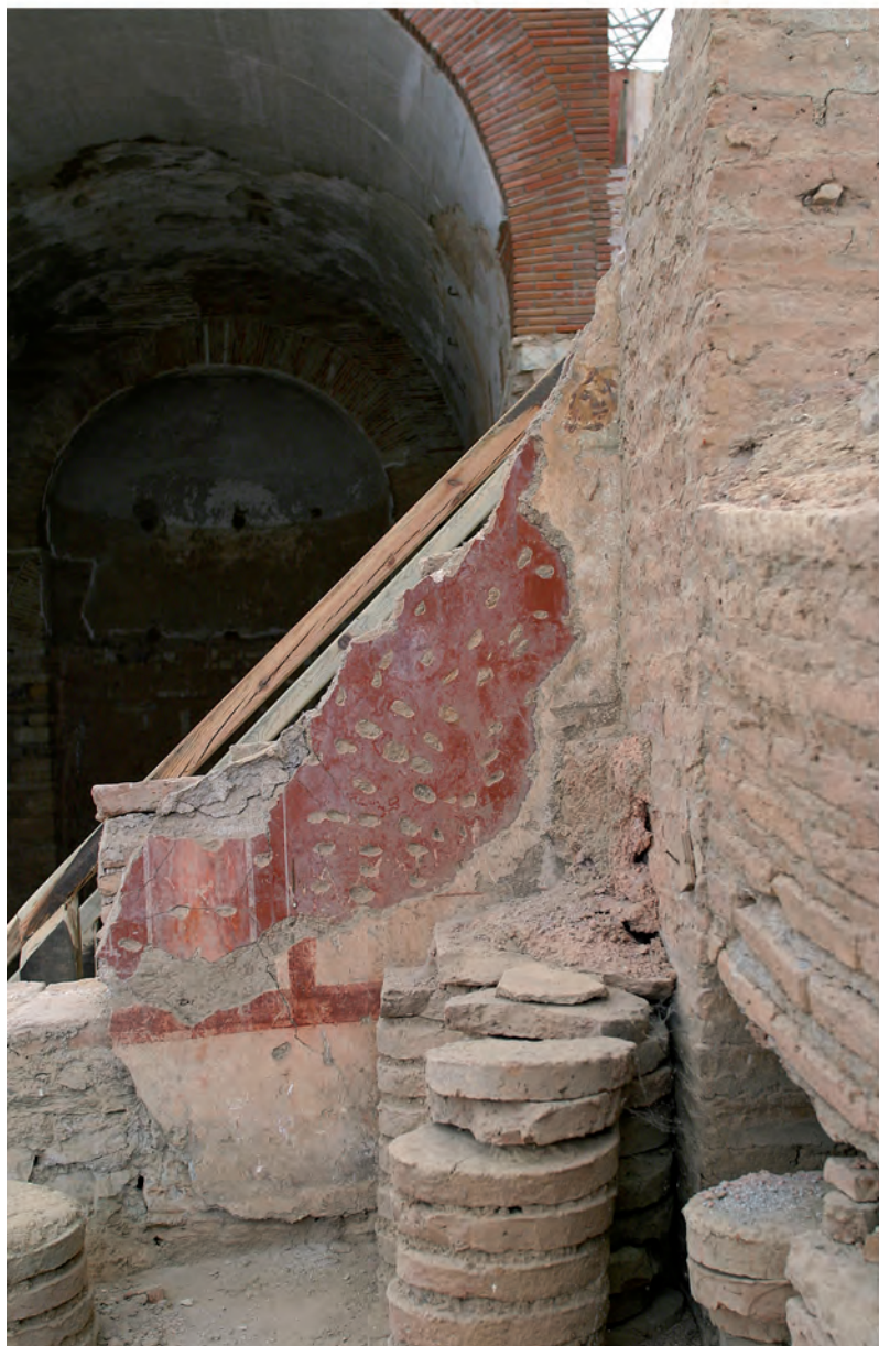
Abb. 49: Raum 36c.1, westliche S-Wand
