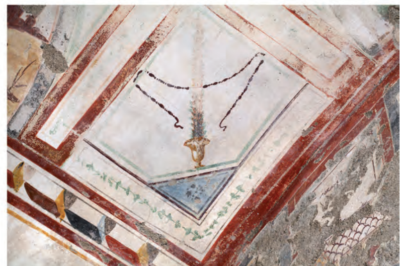
Abb. 37: Raum 36a, Dekorfeld im Gewölbe
