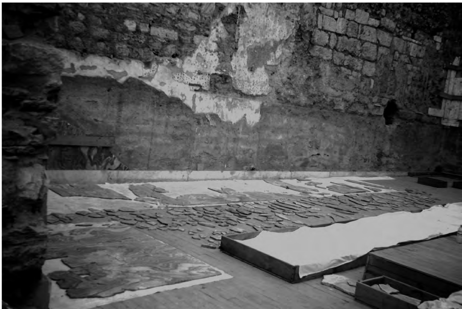
Abb. 19: Marmorsaal 31, O-Wand mit Baufuge
