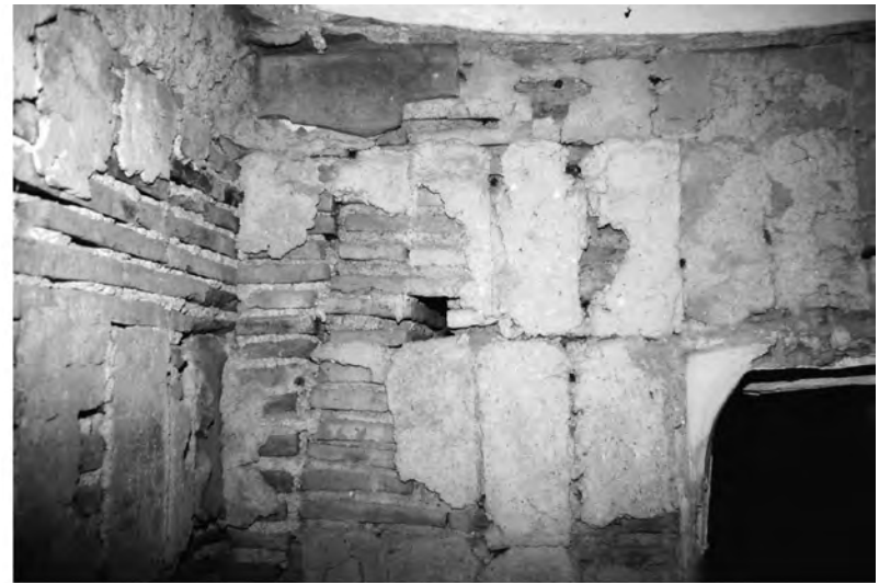
Abb. 28: Raum 8c, W-Wand mit Zugangsluke
