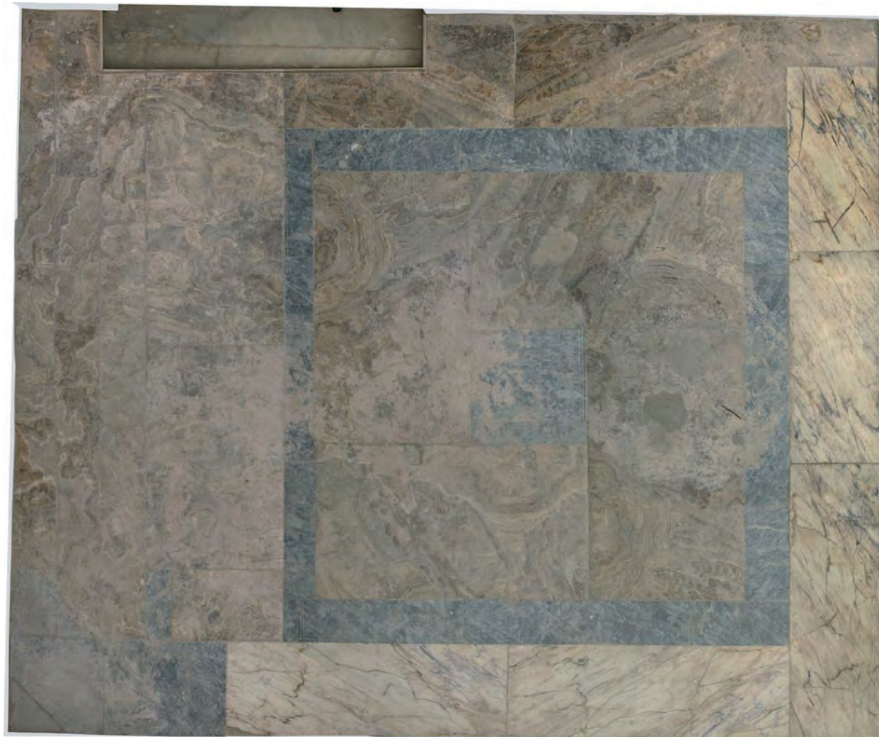
Abb. 31: Gewölberaum 36a, Boden
