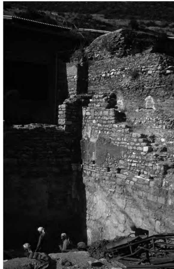
Abb. 8: Freilegung der SW-Ecke des Marmorsaals 31
