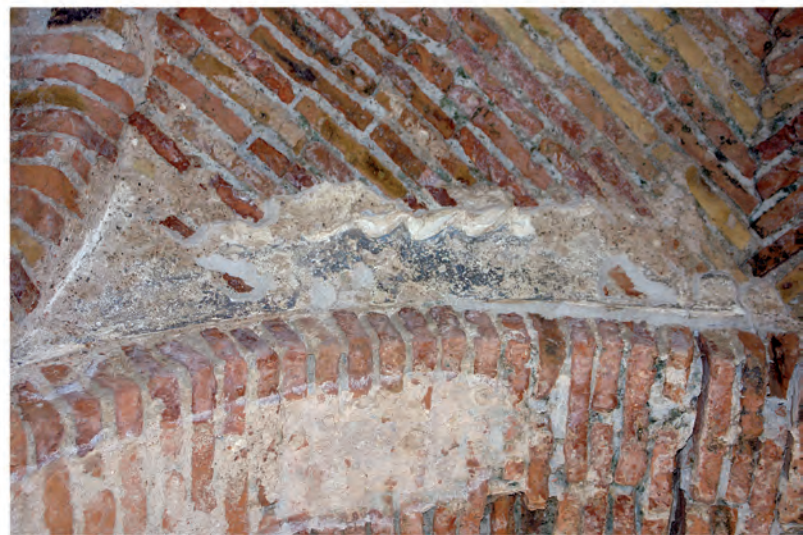
Abb. 11: Raum 31aO.M2, Detail von Abb. 10
