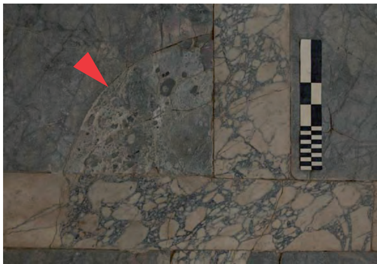
Abb. 37: OG-Raum 32, Bodendetail Ausflickung (Viertelkreis)
