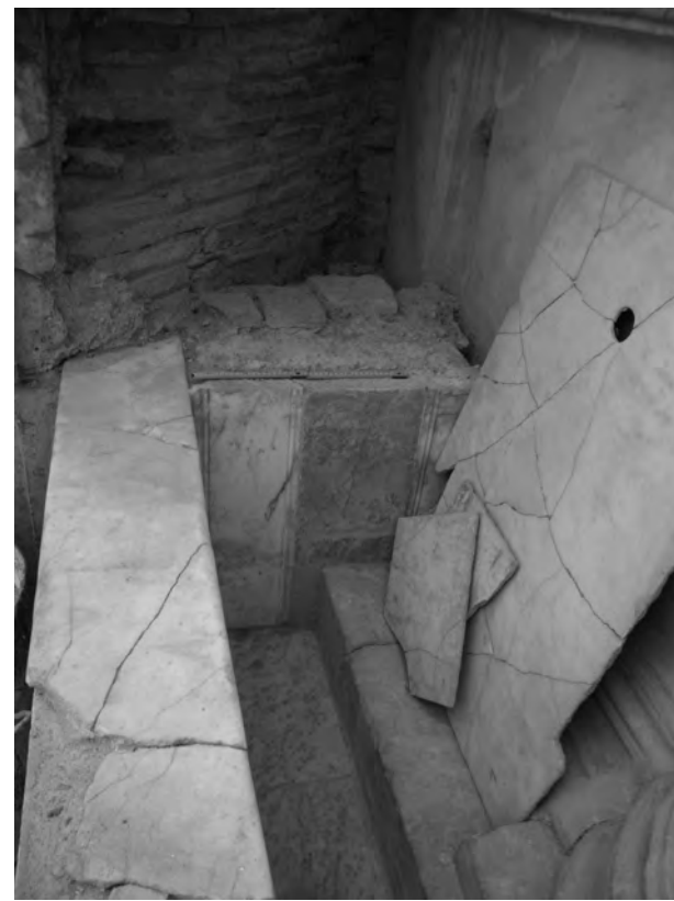
Abb. 28: Peristylhof 31a, Brunnen WB-A3, Umbauten am O-Ende
