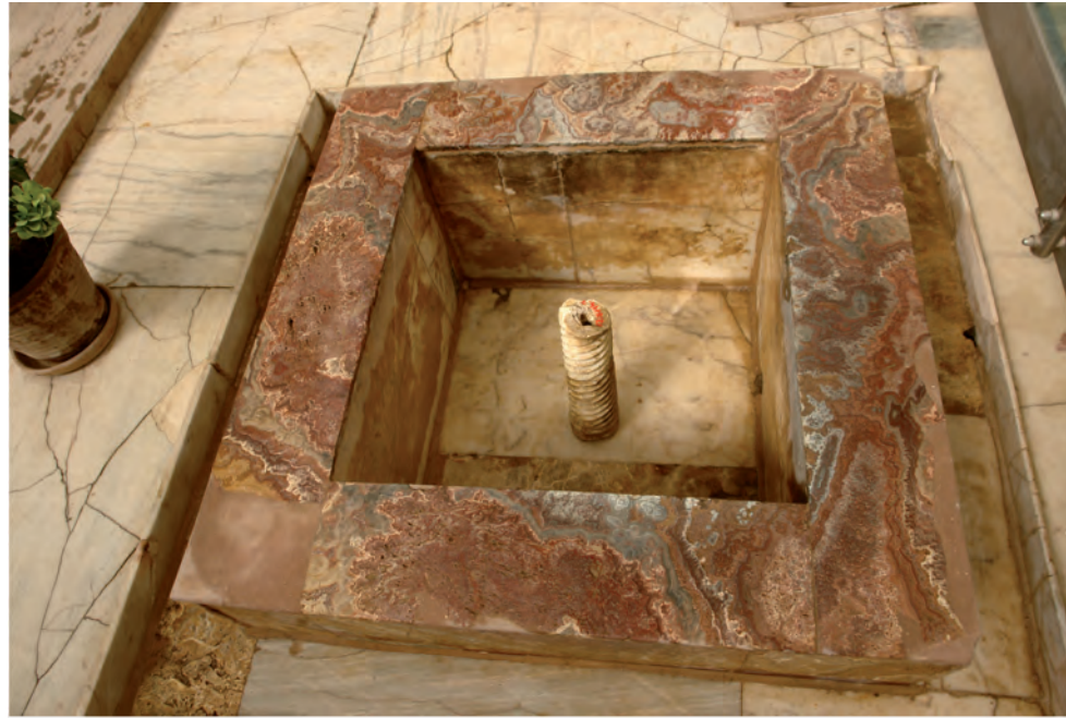
Abb. 6: Marmorsaal 31, Bodenwasserbecken WB-A4 mit Beckenständer
