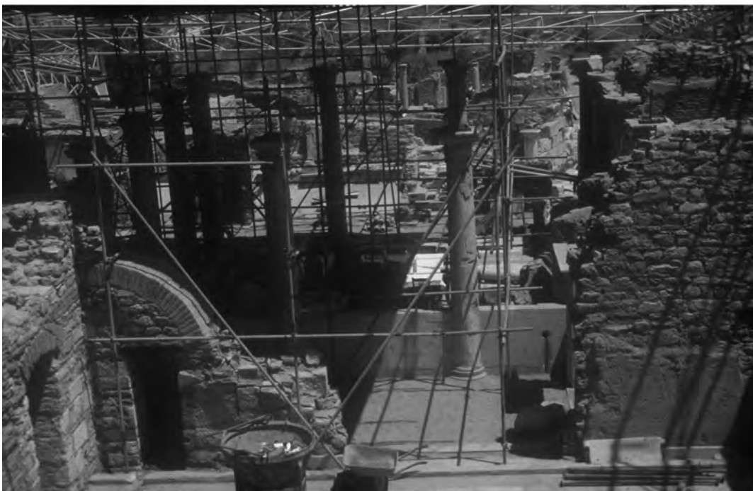
Abb. 46: Montage der Stahlkonstruktion des Schutzbaus im Jahr 2000
