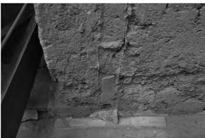
Abb. 18: Tür T 7, Rest des Türrahmens aus Marmor
