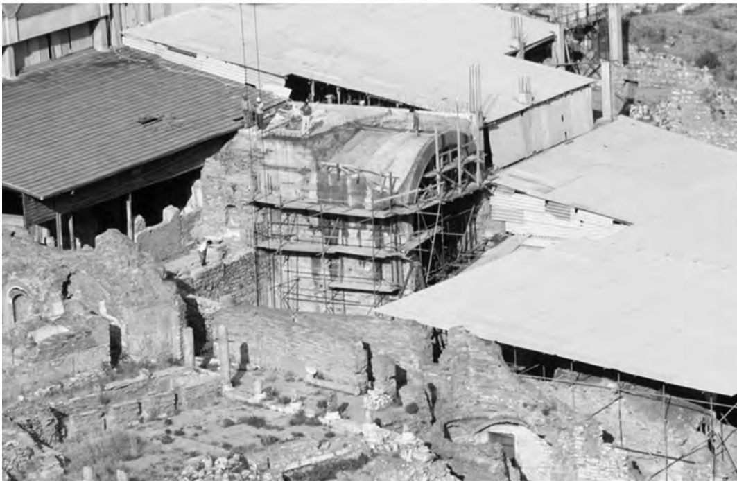
Abb. 45: Ergänzung der Betontonne über dem Apsidensaal 8
