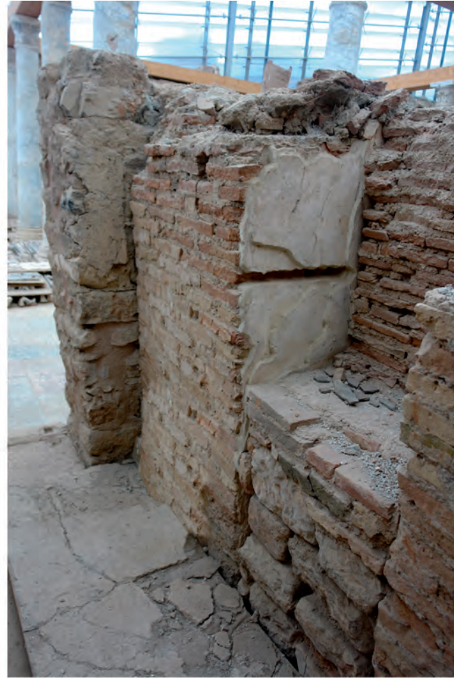
Abb. 19: Raum 36e, S-Wand, zugesetzter Durchgang nach Raum 36d, drei weiße Malschichten in späterer Nische
