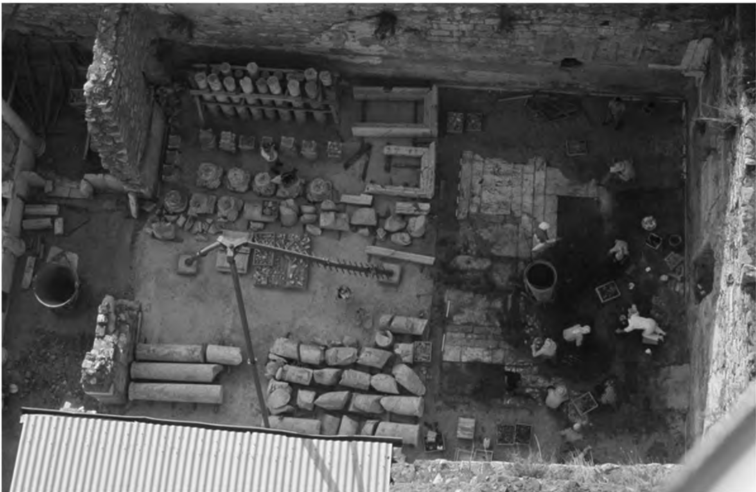
Abb. 34: Marmorsaal 31, Freilegung des Bodens im S-Bereich und Bergung der Balken mit Reliefverzierung durch Karl Herold
