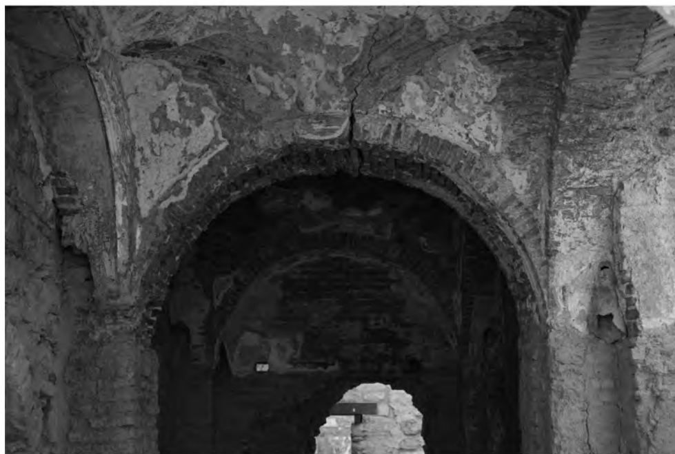
Abb. 2: Tonrohre als Rauchabzug im Bad 31aO/M1 und 31aO/M2
