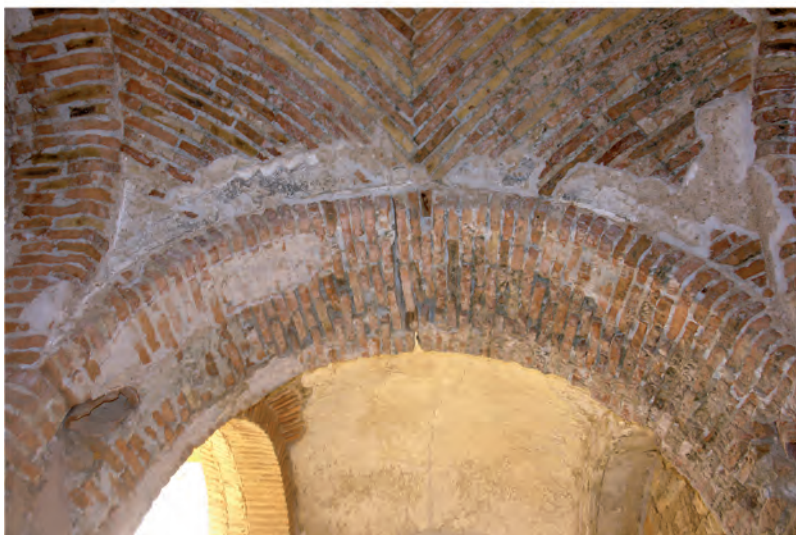
Abb. 10: Raum 31aO.M2, Rest der Stuckverzierung der Decke
