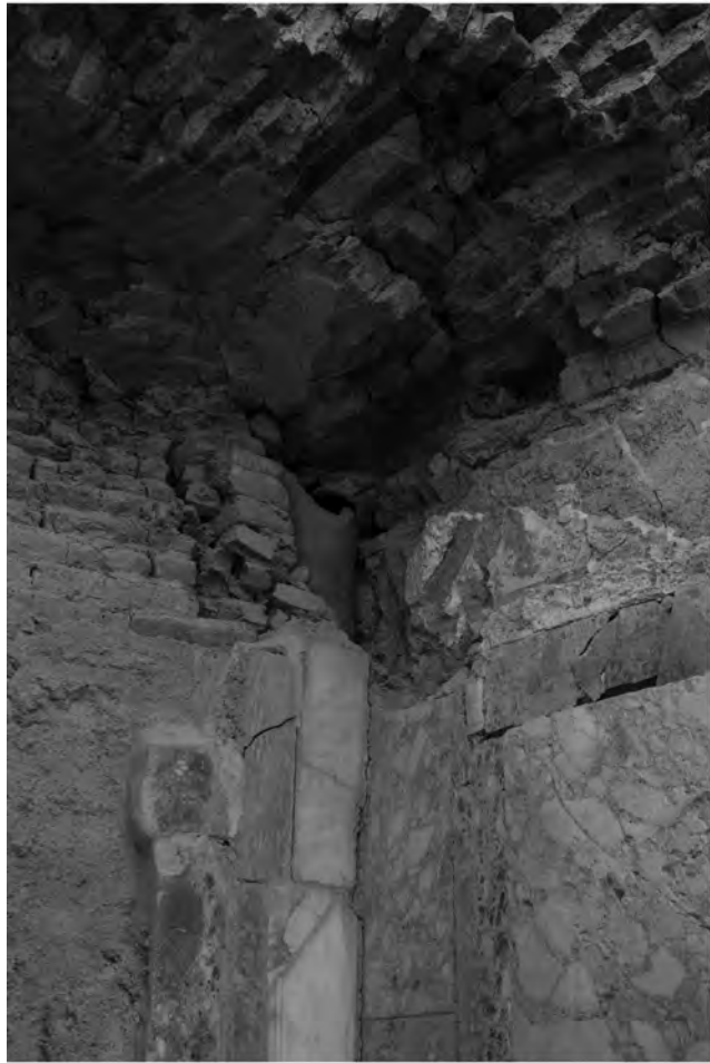
Abb. 41: Raum 36c, Fallrohr in NW-Ecke
