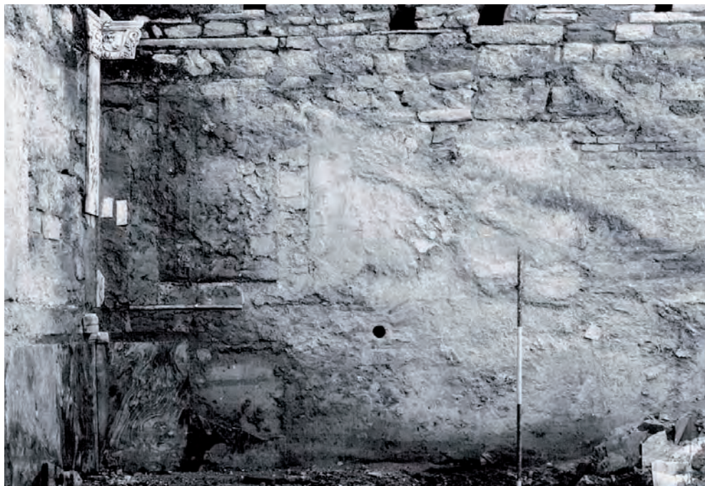
Abb. 9: Marmorsaal 31, SW-Ecke während der Freilegung
