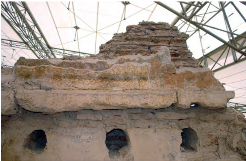
Abb. 51: Raum 36d.1, W-Wand, Mauer auf Stylobat mit Rest von zwei Malschichten
