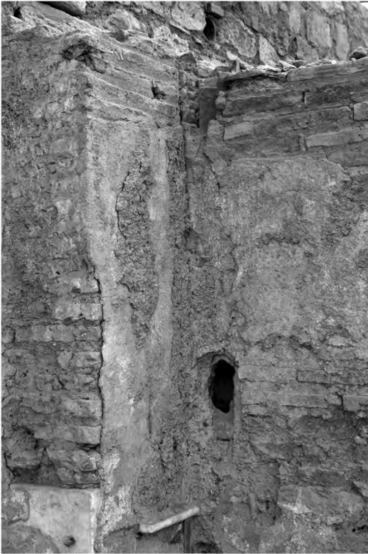
Abb. 1: OG-Raum 32, Tonrohr in der W-Mauer
