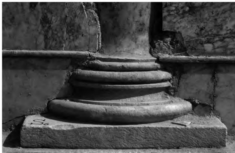
Abb. 9: Peristylhof 31a, Basis und Säule in der Fensterwand der O-Kolonnade
