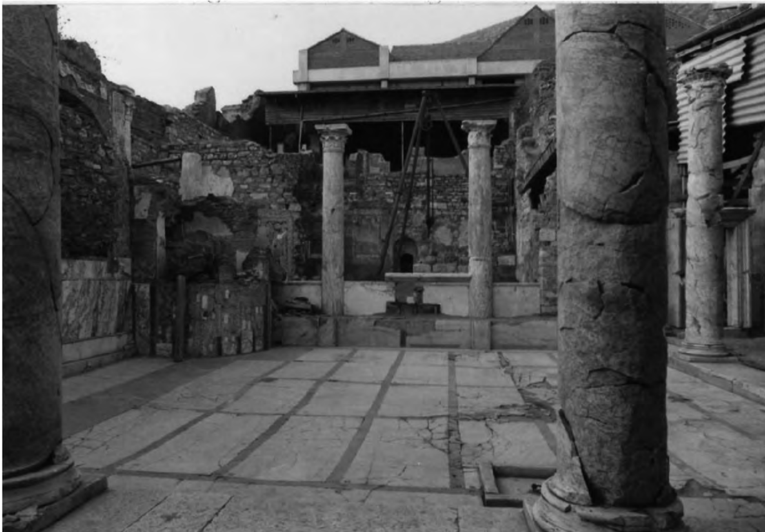
Abb. 8: Peristylhof 31a 1987 mit provisorisch aufgestellten Säulen und vor Abnahme des Bodens
