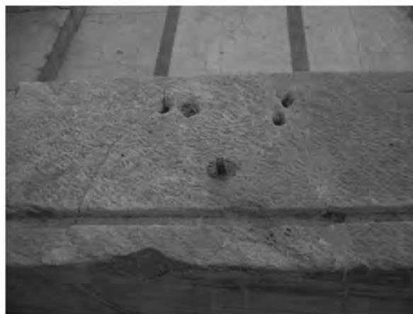
Abb. 12: Oberes Auflager des Schrankenplatten-Gesimses in 31aS mit Metallhaken für Skulpturensockel
