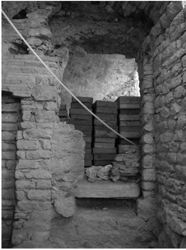
Abb. 55: Quergang Q.W, Blick nach W mit Schwelle nach T.IV
