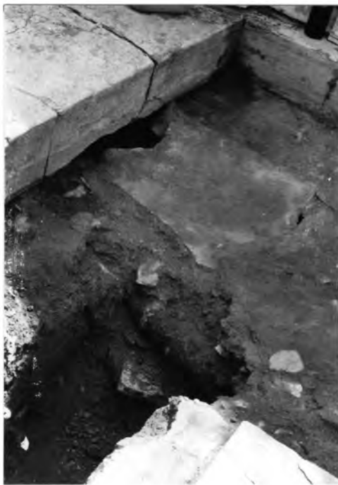
Abb. 19: Peristyl 31a Innenhof, Einmündung N-Kanal in O-Kanal, Plattenabdeckung
