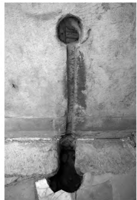
Abb. 37: Peristylhof 31a S-Umgang, Kanaleinlauf unterhalb Ausarbeitung für Wasserleitung
