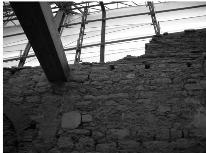
Abb. 2: Peristylhof 31a O-Mauer, Ziegel des Formats a oberhalb Balkenlage
