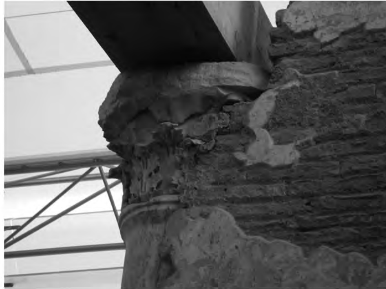
Abb. 7: Baderäume 31aO/M1 und 31aO/M2, Ziegelmauerwerk Typ 7
