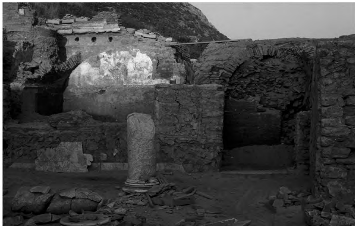
Abb. 14: Raum 36d, Balkenlöcher in der W-Mauer
