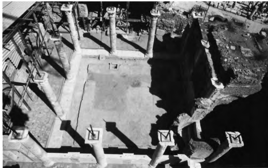
Abb. 9: Peristylhof 31a nach Fundamentierungsarbeiten
