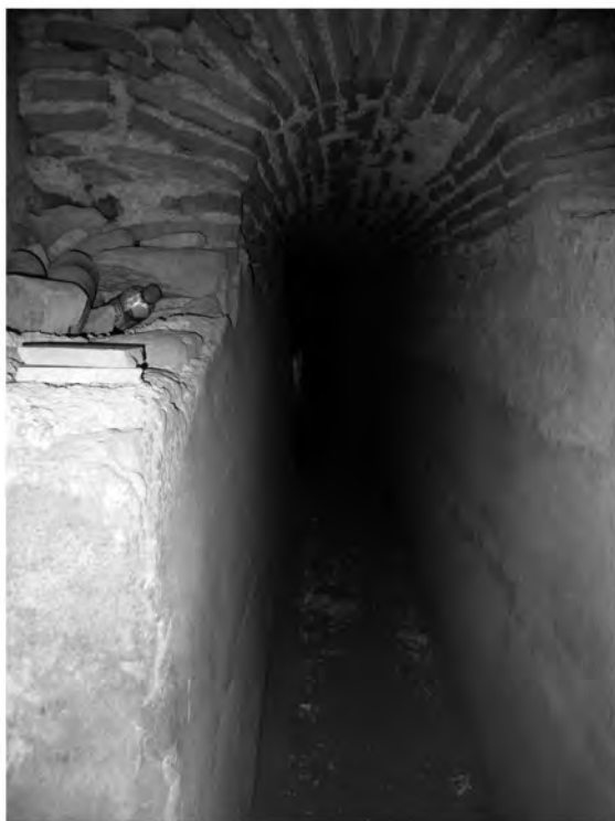
Abb. 16: Wasserkanal südlich Marmorsaal 31 (Aristion-Leitung)
