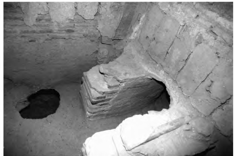
Abb. 29: Raum 8c, O-Wand mit Praefurnium und Bodenloch zum Praefurnium des Apsidensaals 8
