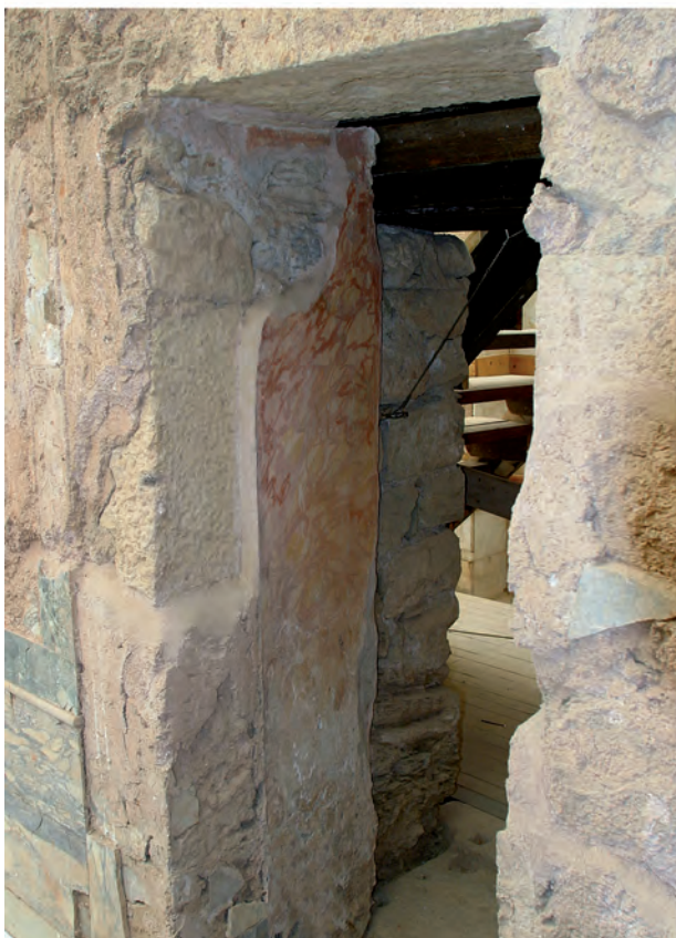
Abb. 16: Durchgang Raum 36b-36c, östliche Türwand, Breccienmalerei
