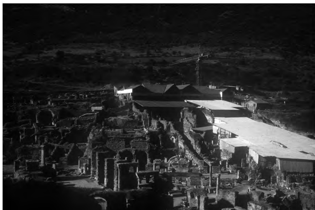
Abb. 43: H 2, Schutzbau 1985 über den WE 1 und WE 2 und den provisorischen Dächern über den WE 3 bis 7
