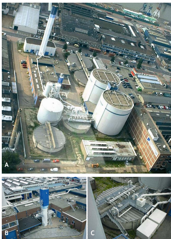
Figure 6.9 Vista aérea de las instalaciones de la PTAR Dokhaven (A) tratamiento de lodos y proceso Anammox, (B) proceso SHARON® (C) reactores vistos desde la parte algo del digester de lodos (foto: Water Board Hollandse Delta)
