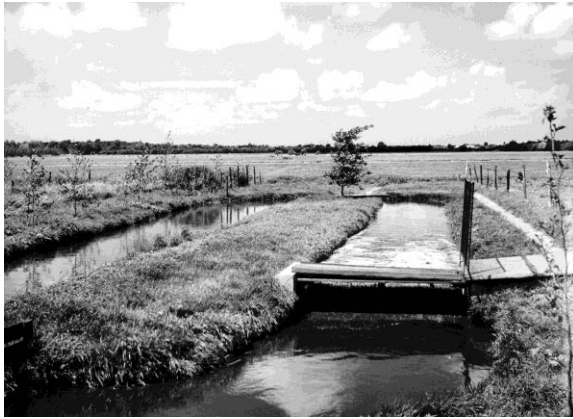
Figura 1.2 Primera aplicación del sistema de fosas de Pasveer a nivel de planta piloto (1954 Voorschoten, Holanda). La capacidad de la planta fue de 400 P.E. y 40 m 3 /h en época de secas (foto: van Lohuizen, 2006)
