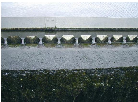
Figura 12.11 Algas en vertedores (foto: D. Brdjanovic)
