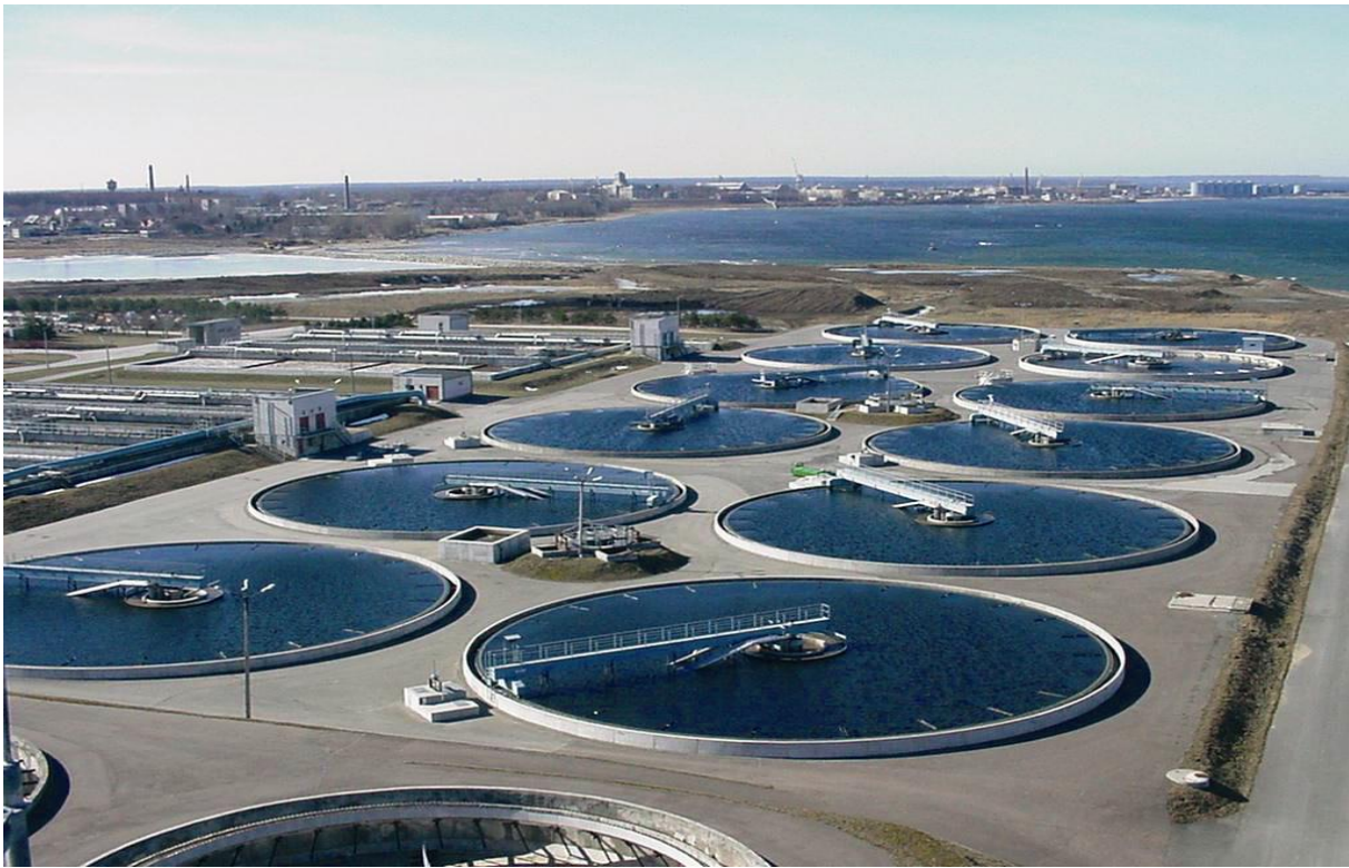
Figura 12.1 Los clarificadores secundarios son una de las estructuras más visibles de la Tierra desde el espacio (foto: D. Brdjanovic)
