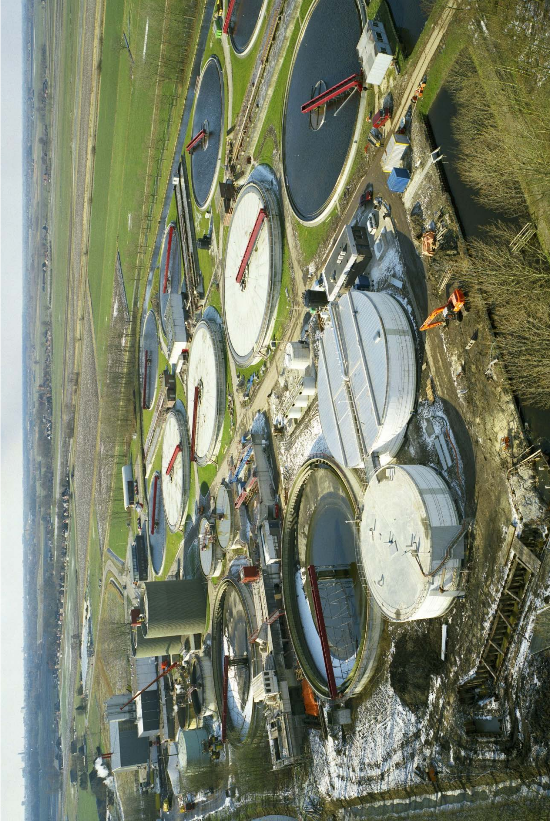
Premio obtenido (Premio IWA al Proyecto de Innovación, Europa 2008) en la PTAR Garmerswolde en los Países Bajos empleando el proceso SHARON® (dos reactores blancos en el frente; foto: Grontmij Nederland N.V.)
