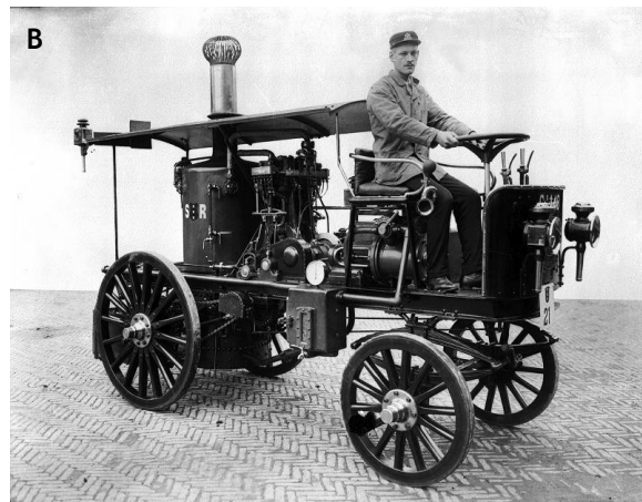
Figura 1.1 Sistema Liernur para la recolección de las aguas del inodoro (A), y el vehículo utilizado para coleccionar y transportar los residuos (B) (fotos: van Lohuizen, 2006).
