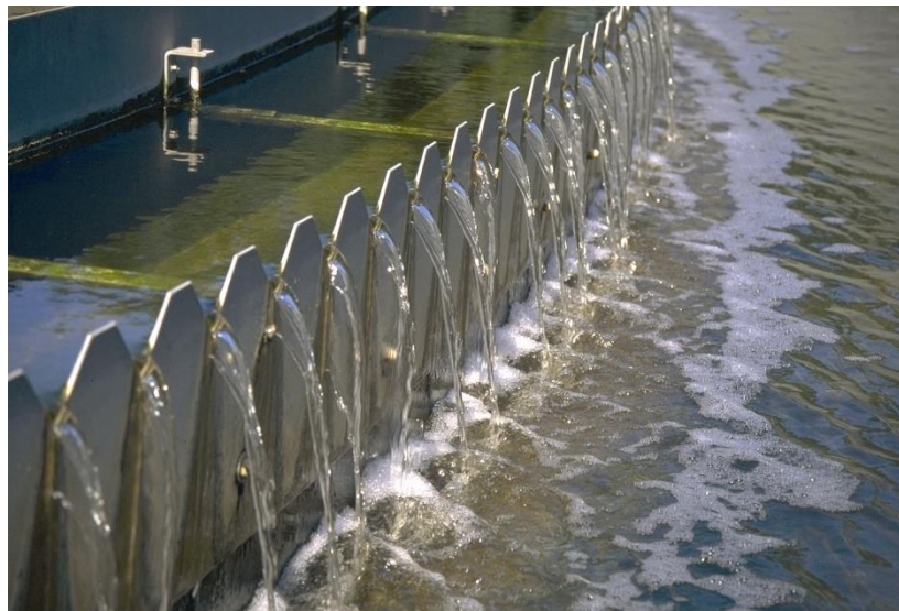
Ejemplo de un sedimentador secundario operado y mantenido apropiadamente, el cual produce un efluente de buena calidad (Foto D.H. Eikelboom)
