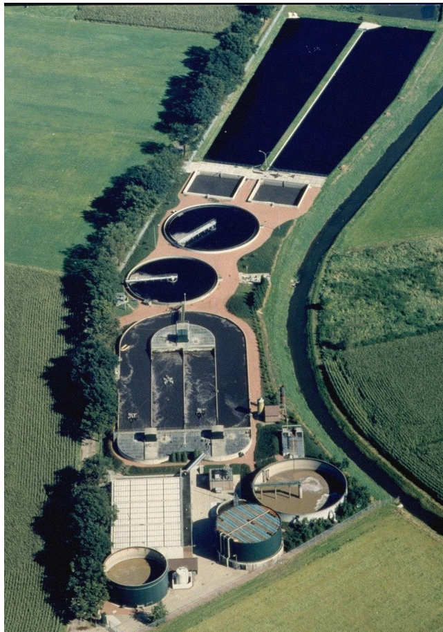
Aplicación a gran escala de la tecnología UASB: planta de tratamiento de aguas residuales de la industria cervecera de Bavaria en Lieshout, Holanda. El reactor UASB se encuentra en frente del Carrusel (Imágen: J.B. van Lierpor cortesía de Bavaria N.V.)
