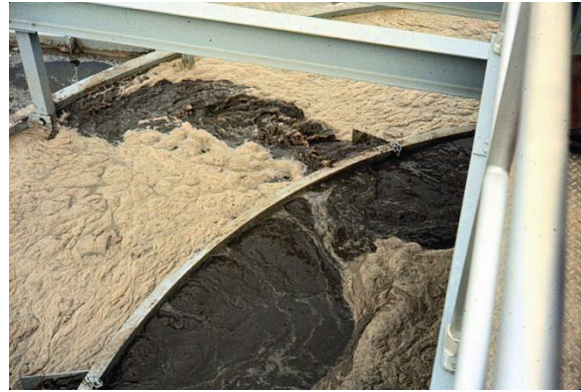
Figura 12.8 Nata en un clarificador (foto: Black y Veatch)
