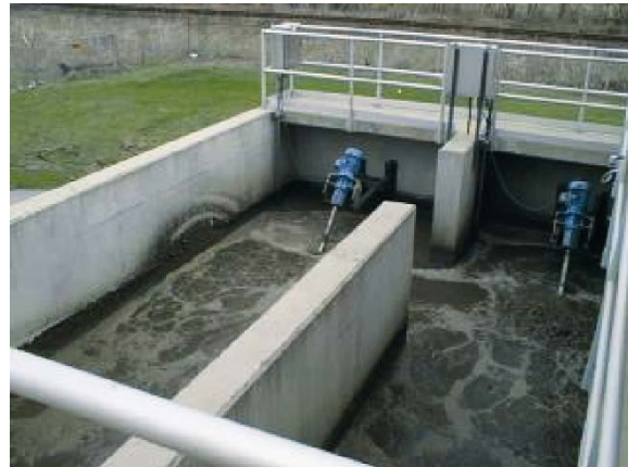
Figura 11.7 Selector Aerobio (foto: M.C.M. van Loosdrecht)
