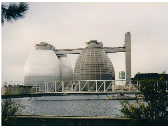
Figura 3.7 Los digestores producen sobrenadantes que pueden generar problemas en las plantas de tratamiento de aguas residuales debido a las altas cargas de nitrógeno y otras sustancias (foto: M. Henze)
