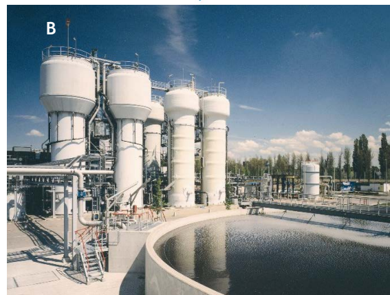
Figura 18.7 (A) Esquema e (B) imagen de un reactor airlift (las dos torres a la derecha), con un sedimentador integrado en la parte superior del reactor: industria de fermentación DSM en Delft, Holanda (Imagen: J. Blom)
