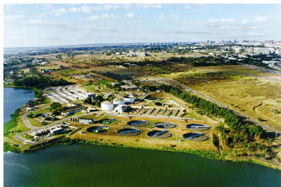
Figura 4.9 Una de las dos plantas de tratamiento de aguas residuales de Brasilia, Brasil (foto: R. Brummer)
