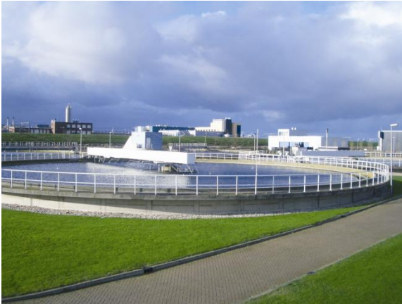
Figura 12.2 Clarificador circular (foto: D. Brdjanovic)
