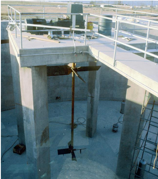
Figura 9.3 Aireador superficial de baja velocidad durante su instalación (izquierda) y en operación (derecha). La forma de las aspas del mezclador ubicado al fondo del tanque asegura que los sólidos no sedimenten. Las columnas del sistema estructural sobre el cual se apoya el aireador actúan también como mamparas para evitar la creación de vórtices (fotos: M.K. Stenstrom)
