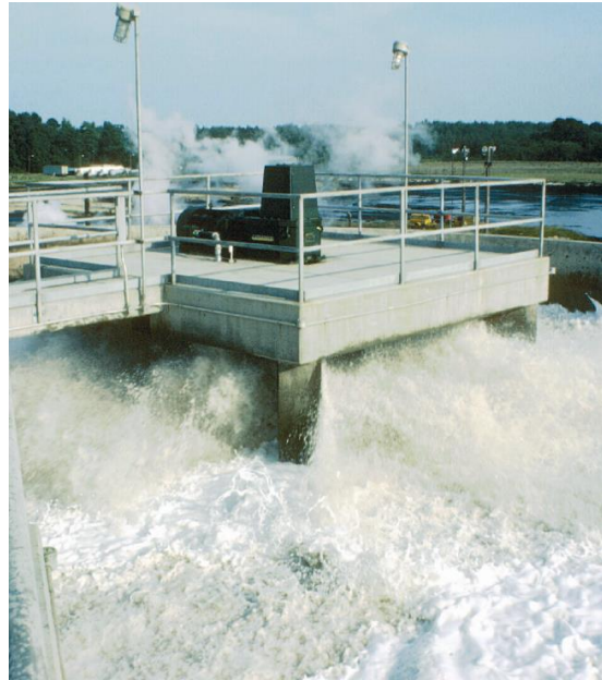
Figura 9.3 Aireador superficial de baja velocidad durante su instalación (izquierda) y en operación (derecha). La forma de las aspas del mezclador ubicado al fondo del tanque asegura que los sólidos no sedimenten. Las columnas del sistema estructural sobre el cual se apoya el aireador actúan también como mamparas para evitar la creación de vórtices (fotos: M.K. Stenstrom)
