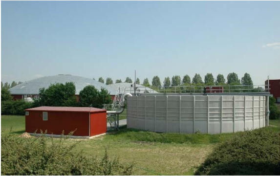
Figura 6.12 Aplicación a escala completa de la tecnología BABE®: PTAR Hertogenbosch en los Países Bajos (vista frontal: reactor de bio-aumentación; foto: DHV B.V.)
