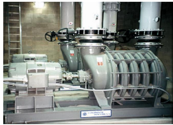
Figura 9.12 Sopladores centrífugos de una etapa (izquierda) y de múltiples etapas (derecha) (fotos: M.K. Stenstrom)
