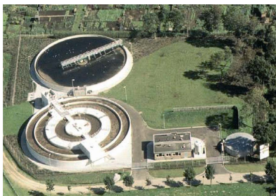
Figura 11.1 Planta para la eliminación biológica de nutrientes instalada en Holanda (proceso BCFS®). Se muestra la importancia de la separación del lodo en el diseño del proceso. El diseño del sedimentador fue hecho de acuerdo a un IVL de 120 ml/g (foto: van Loosdrecht et al. , 1998)
