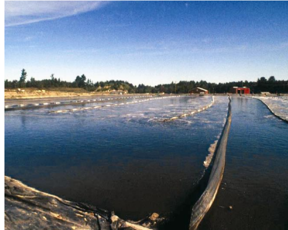
Figura 9.11 Aplicación de difusores de burbuja fina a una laguna aireada. Los tubos de suministro de aire (ubicados sobre el bastidor de difusores) distribuyen el aire a lo largo de la laguna, y las mangueras verticales transportan el aire de los tubos de suministro a los bastidores de los difusores (ubicados cerca del fondo de la laguna) (fotos: M.K. Stenstrom)
