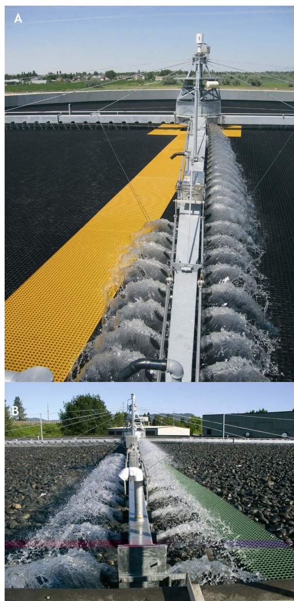
Figura 18.2 Filtros percoladores utilizando (A) plástico o (B) rocas como medio de soporte (Imágenes: WesTech Engineering Inc.)
