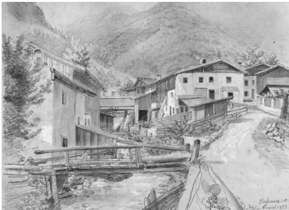
Abb. 4: Der Schlickerbach fließt mitten durch den Ort. Die Überschwemmungsgefahr war ohne geeignete Verbauungsmaßnahmen permanent. Bleistiftzeichnung aus dem Jahr 1853, TLMF-Bib., W 11069.
