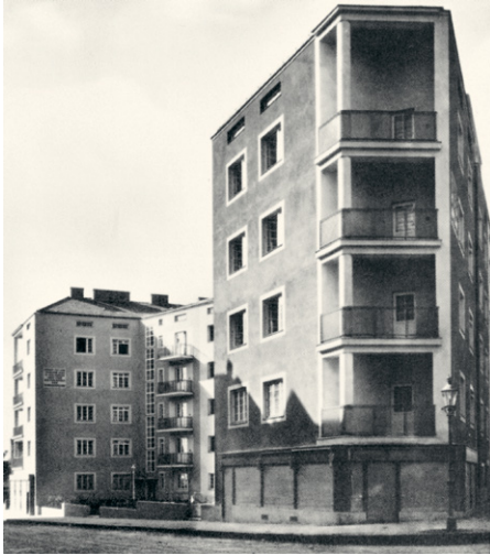
56. Josef Frank, Wohnhausanlage Wien 14, Sebastian Kelchgasse 1–3, erbaut um 1928/ Moderne Bauformen
