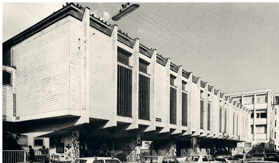
83. Ernst Lichtblau, Schule, Wien 16, Grundsteingasse 48, erbaut 1962/63/Sarnitz (Spiluttini)
