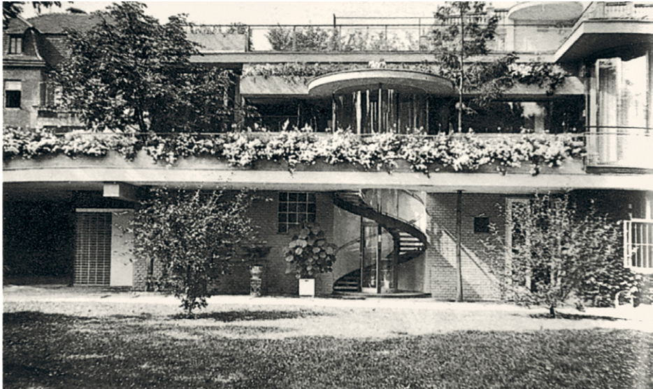
104. Friedl Dicker u. Franz Singer, Gästehaus Hériot, Wien 2, Rustenschacherallee, erbaut 1932/34 (nicht erhalten)/Dicker Kat.
