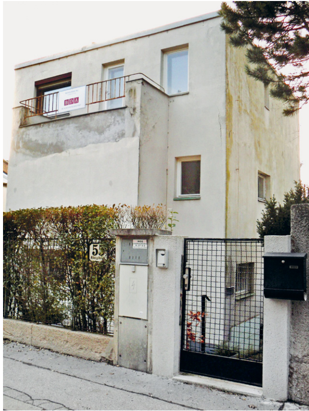
79. Heinrich Kulka, Haus Weizmann, Wien 13, Küniglberggasse 55, erbaut um 1930/Prokop
