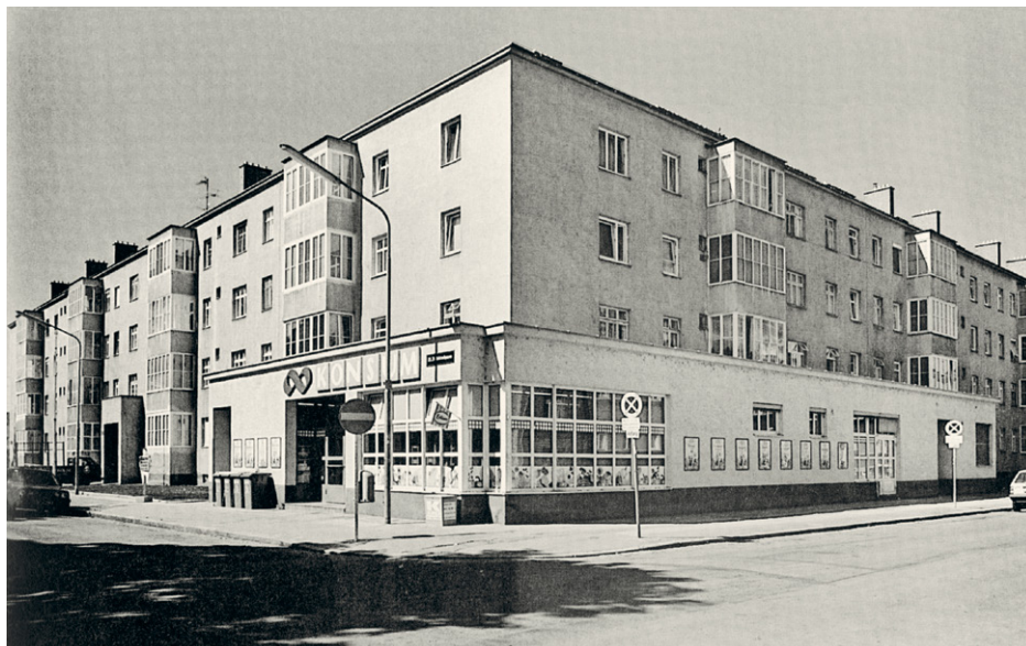
82. Ernst Lichtblau, Paul Speiser-Hof, Wien 21, Franklinstraße 20 (Bauteil II), erbaut 1929/Sarnitz (Spiluttini)
