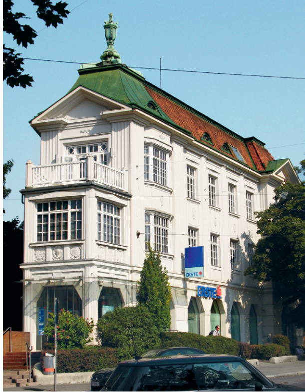
41. Julius Wohlmuth, Geschäftshaus, Wien 19, Grinzinger Allee 1, erbaut 1913/Prokop
