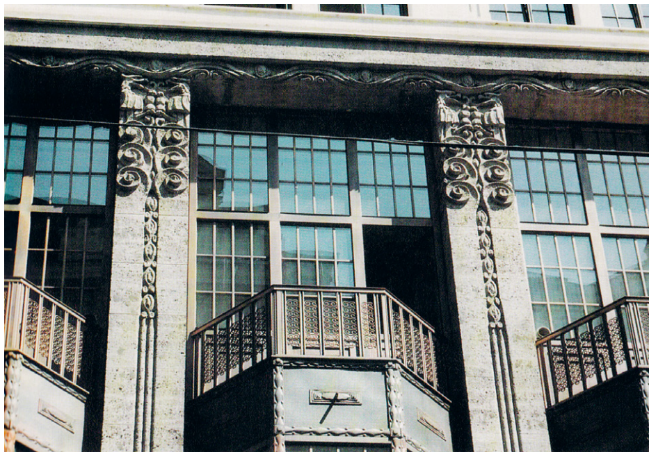
26. Arthur Baron, Druckereigebäude Steyrmühl, Wien 1 Fleischmarkt 3, erbaut 1913/Prokop
