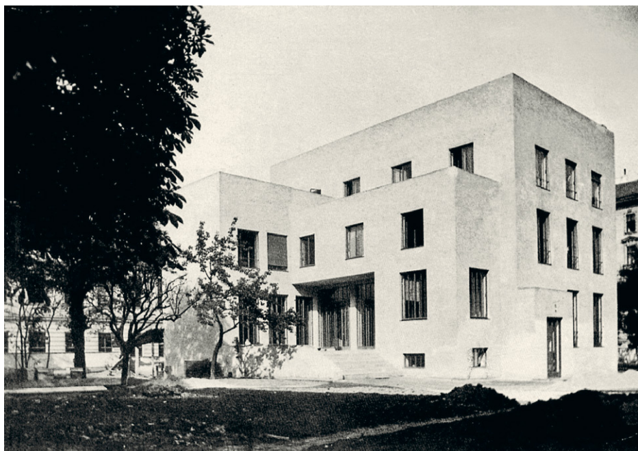
67. Paul Engelmann u. Ludwig Wittgenstein, Haus Wittgenstein (Palais Stonborough), Wien 3, Kundmannngasse 19, erbaut um 1928/Wijdeveld
