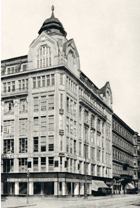
44. Ignaz Reiser, Kai-Palast, Wien 1, Franz Josefs-Kai 57, erbaut 1912 (nicht erhalten)/Wf. Bauindustriezeitung
