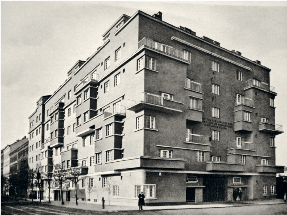
77. Josef Berger u. Martin Ziegler, Wohnhausanlage d. Gemeinde Wien, Wien 3, Schlachthausgasse 2–6, erbaut 1926/Mod. Bauformen
