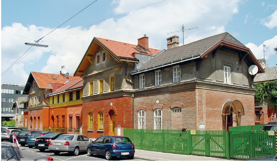
4. Josef Unger, Arbeiterwohnhäuser, Wien 10, Kiesevettergasse 3-15, erbaut um 1886/Prokop
