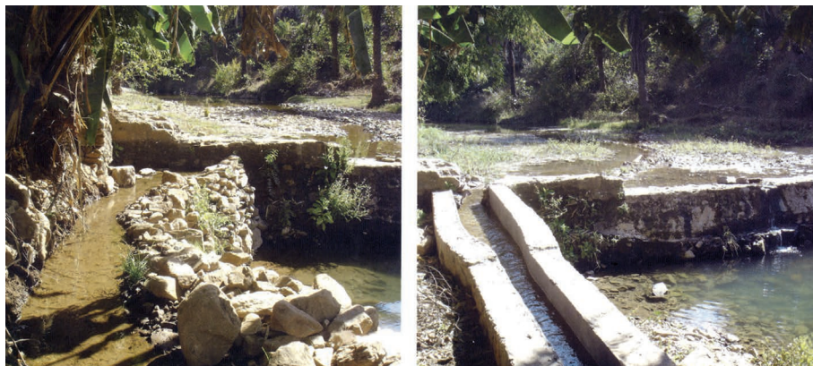
Figure 33. Rénovation du harren Bhutiya de Amda, avant et après
