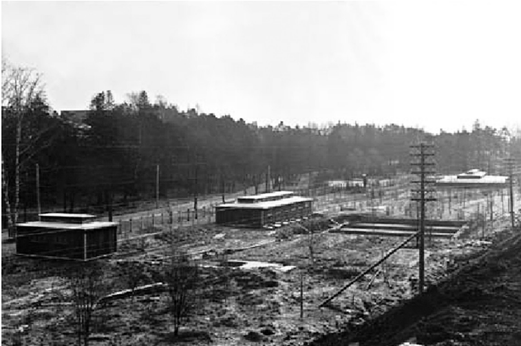
Vuonna 1910 valmistui Helsingin ensimmäinen jätevedenpuhdistamo Alppilaan. Alkuperäinen puhdistamo vaurioitui ja tilalle rakennettiin uusi (kuvassa) vuonna 1924. Foto Roos 1930. HKM.
