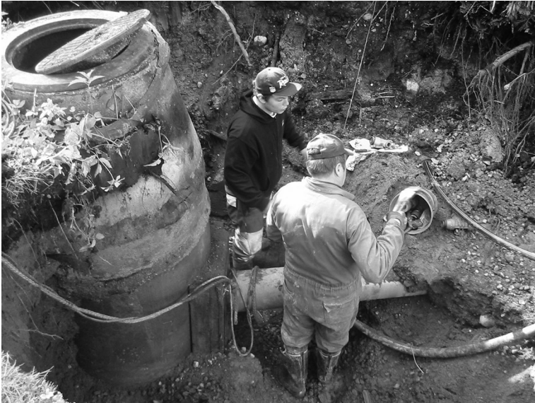
Miehiä viemäryömaalla (HSY)
