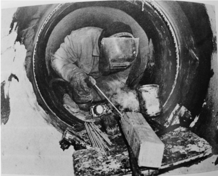
NS 800:n suuruisen teräsjohton päittäishitsaus käynnissä pääjohtotyömaalla. (Helsingin kaupungin vesilaitos TK 1970)
