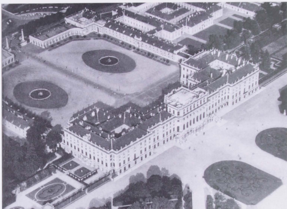
Abb. 143: Schloß Schönbrunn, Hauptbau Garten- und Westfassade, Kavaliertakt und Teil des Meidlinger Vierecks; Flugaufnahme.
