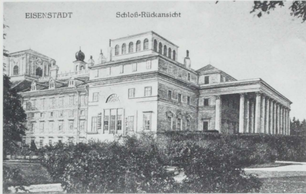
Abb. 98: Ostfassade des Schlosses mit deutlich sichtbaren Anschlußsteinen für den geplanten Seitenflügel
