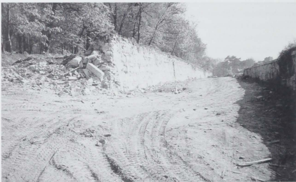
Abb. 22: Zerstörte Gewächshäuser, nach 1970
