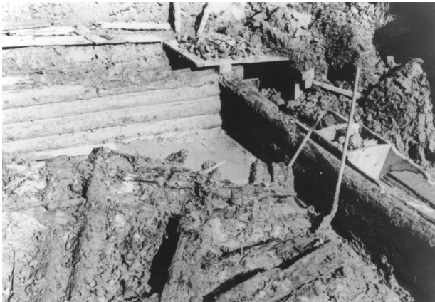
Abb. 24: Blockwandbau 1939, N-Ecke von innen, Museum Hallstatt F 03712.
