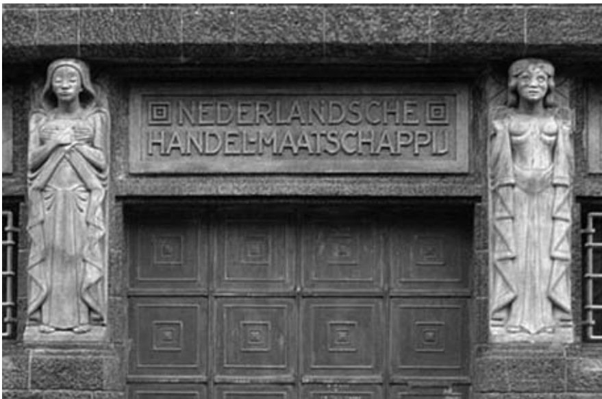
4.7. Main entrance to the Nederlandsche Handel-Maatschappij building, Vijzelstraat, Amsterdam (1920-5).
