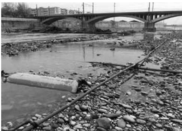
Figura 13. Il degrado dei margini fluviali prima dell’intervento.
