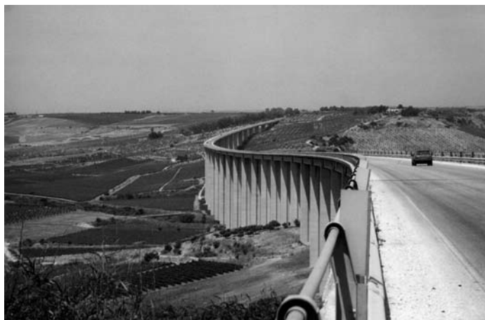
Figura 4. Viadotto strada statale n. 115 tra Castel Vetrano e Menfi (Sicilia).
