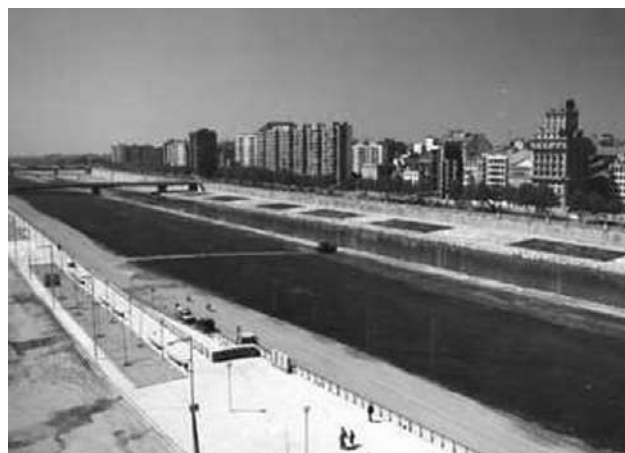
Figura 14. Il disegno geometrico di prato e roccia definisce il margine destro del canale in un’immagine ripresa durante i lavori di realizzazione del parco fluviale.
