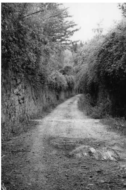
Figura 5. Segni del degrado dovuto all'abbandono di tratti della viabilità collinare storica in val d'Eme: il viuzzo dei Catinaï.
