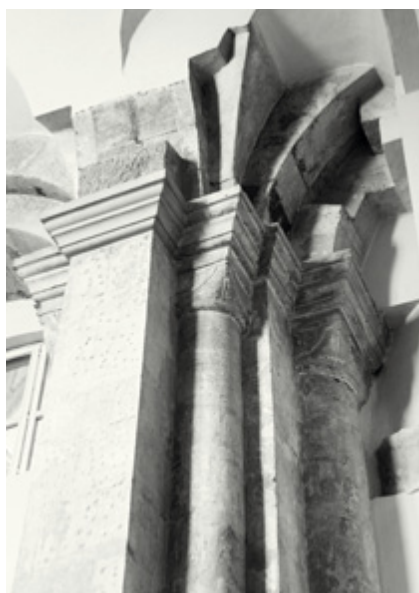
Abb. 5: Freigelegte romanische Bauglieder vom südlichen Seitenschiff der Wiener Schottenkirche
