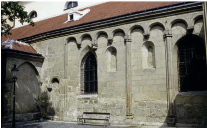
Abb. 9: Südliche Seitenschiffwand der Pfarrkirche Tulln
