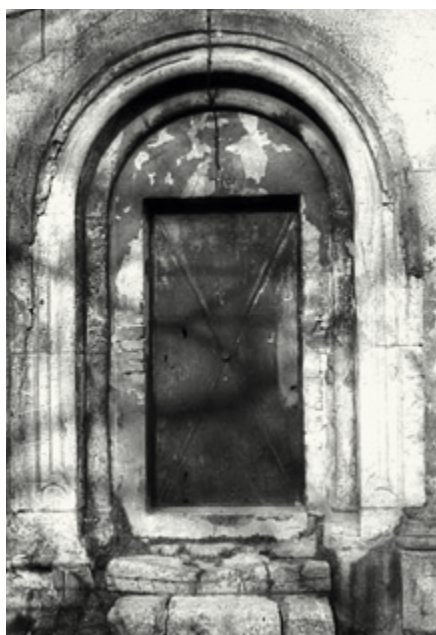
Abb. 106 a und b: Karner in Hainburg. Gesamtansicht und Portal
