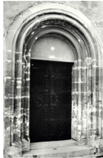
Abb. 102: Südportal der Pfarrkirche in Bad Deutsch Altenburg
