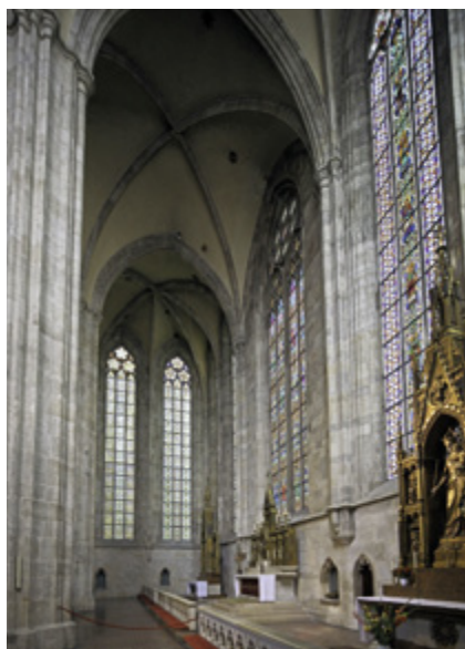
Abb. 200 a und b: Innenansichten des Chors der Zisterzienserstiftskirche Heiligenkreuz
