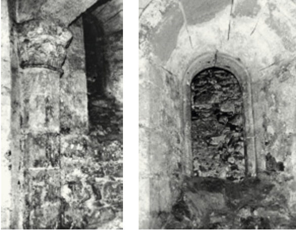
Abb. 130 a und b: Krypta der Stiftskirche St. Florian. Wandvorlage und Rundbogenfenster
