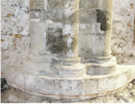
Abb. 77: Freigelegte Basis einer Wandvorlage im Nordschiff des Doms in St. Pölten
