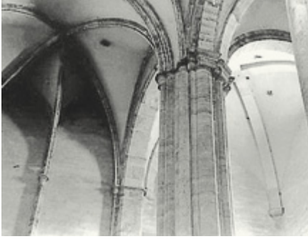
Abb. 25: Stiftskirche Heiligenkreuz. Anschluss der Gewölbe des Hallenchors an das Querschiff
