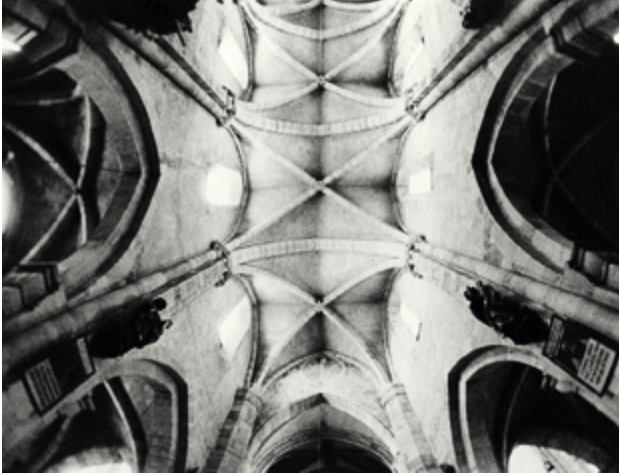
Abb. 136: Gewölbe im Mittelschiff der Liebfrauenkirche in Wiener Neustadt
