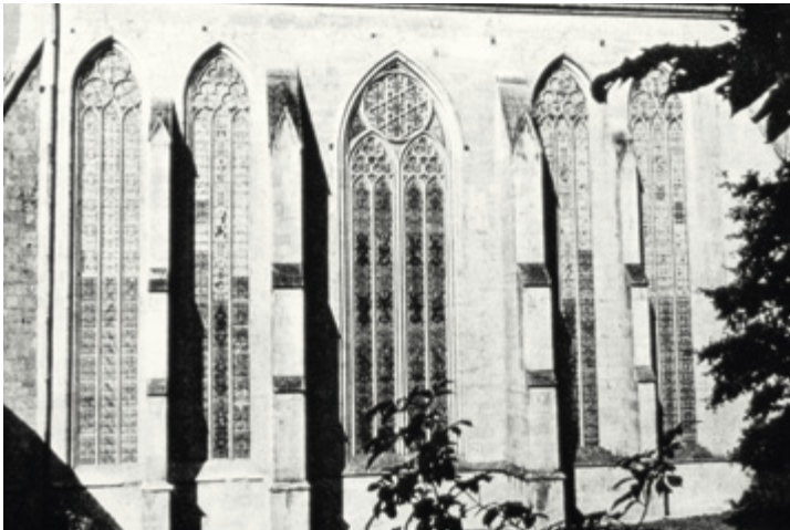
Abb. 201: Ostfassade des Chors der Zisterzienserstiftskirche Heiligenkreuz
