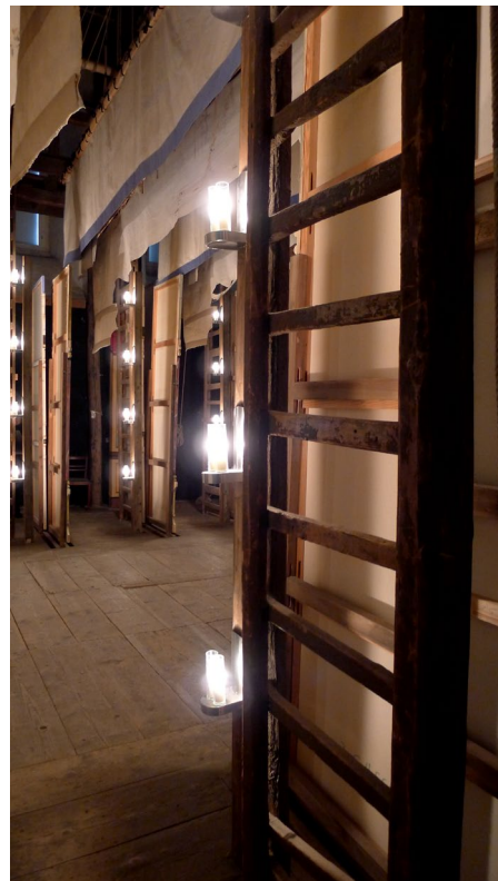
Abbildung 7. Hinter einem Kulissenflügel sind die historischen Leitern erkennbar, an denen die eisernen Halterungen mit den Kerzen hingen.
