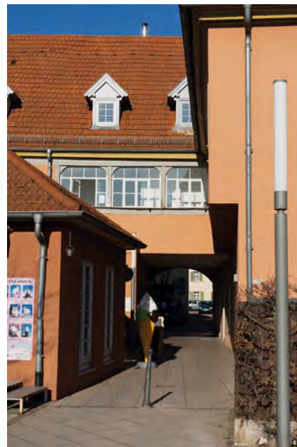
Abb. 3. Das gut erhaltene Gebäude zeigt im Obergeschoss auch heute noch die für den Barock typisch profilierten Fenstergewände; auf der Rückseite des Hauses ist zudem eine alte Galerie in veränderter Form erhalten geblieben.
