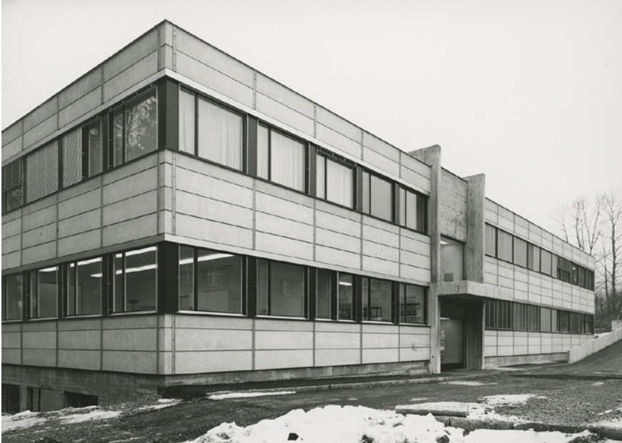
Abb. 7 Der Neubau des Strahlenbiologischen Instituts der Universität Zürich von 1970.
