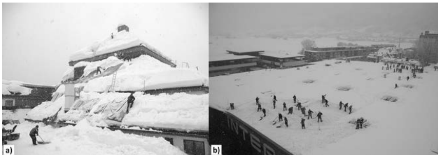
Abbildung 05: Schneeräumung am Nassfeld (Kärnten) im Februar 2009 (a) und auf dem Dach eines Einkaufszentrums in Schwaz im Jänner 2012 (b).
