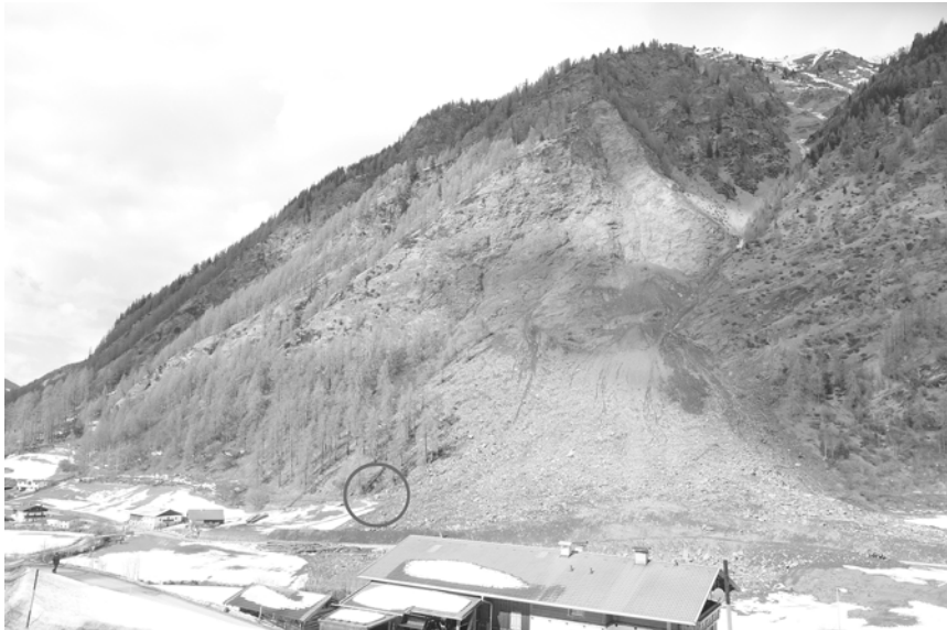
Abbildung 08: Felssturz bzw. Felslawine Vals: Abbruchvolumen ca. 117.000 m 3 , Überlastfall für die Schutzmaßnahmen im Randbereich (dunkler Kreis).
