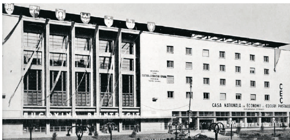
Abb. 55: Palatul cultural conceput că o operă arhitectonică românească monumentală (Der Kulturpalast ist als monumentales Werk rumänischer Architektur konzipiert). Photographie des Kulturpalastes v. 1.XI.1942, nach Wiedereingliederung der Bukowina, worauf die Inschrift über dem Eingangsportal (Bucočina Reintregit) deutlich verweist. 31
