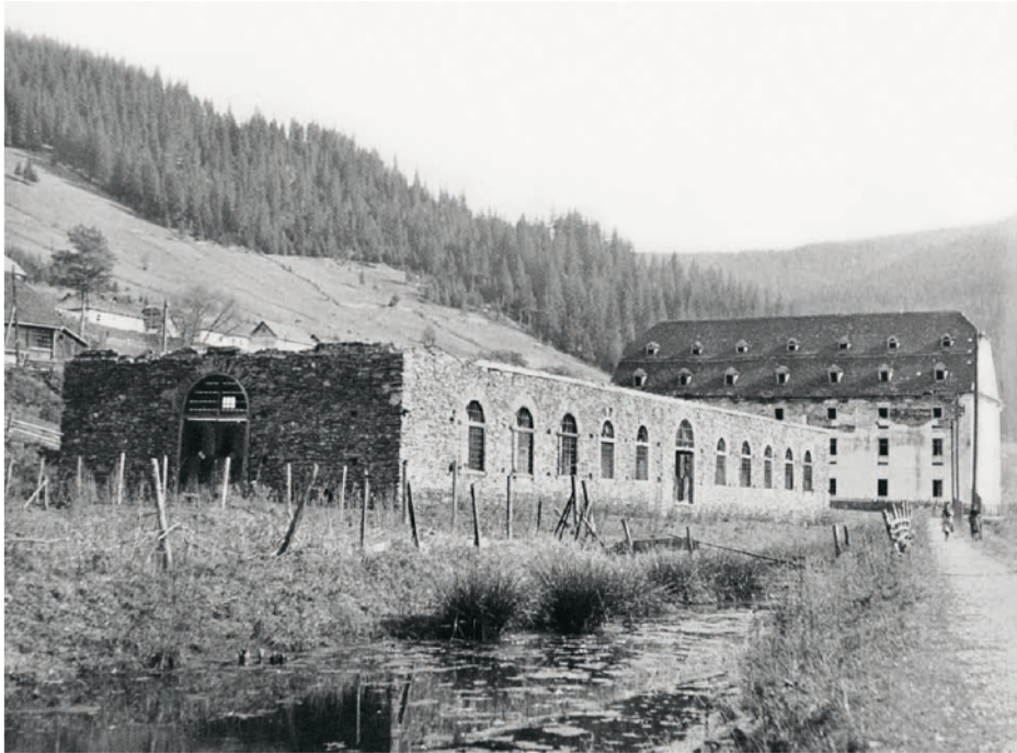
Abb. 67: Die Ruine der ehemaligen Manzsch'schen Gießereihalle in Jakobený, wie sie in der Zwischenkriegszeit noch Bestand hatte, wurde mit dem staatlichen Industrialisierungsprogramm des sozialistischen Rumäniens wahrscheinlich während der 1960er Jahre endgültig abgetragen. 80
