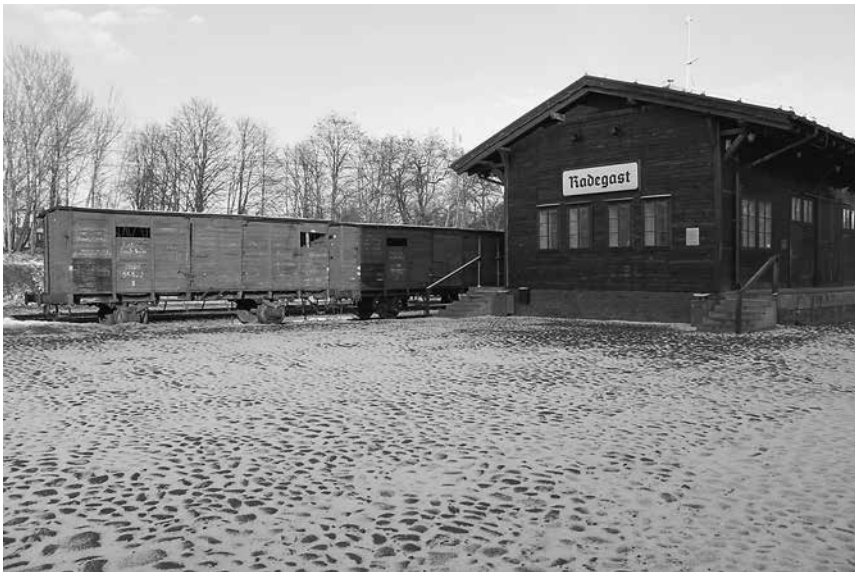
Abb. 28: Station Radegast, das erhaltene Stationsgebäude.
