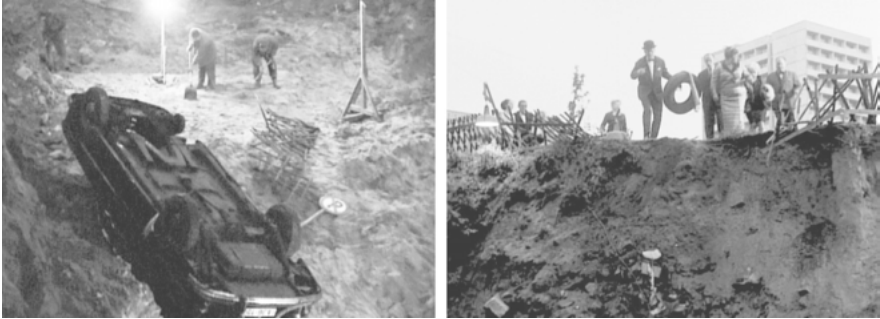
Abb. 2.3: Der Mercedes in der Baugrube.
