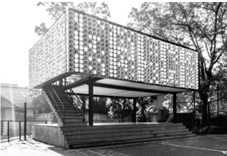
27 Microlibrary Taman Bima (Pilotprojekt), SHAU Architects, Bandung/Indonesien, 2016
