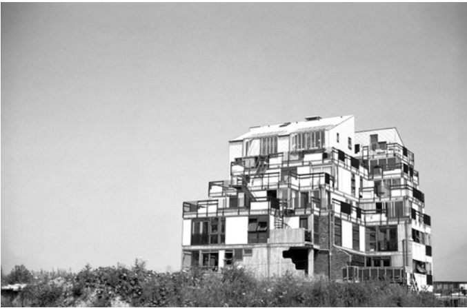
22 Gebäudekomplex der Universität Leuven/Belgien, medizinische Fakultät (Studentenwohnheim, Restaurants, Geschäfte, Schule, Kindergarten und weitere Sozialeinrichtungen), Lucien Kroll, 1970–76
