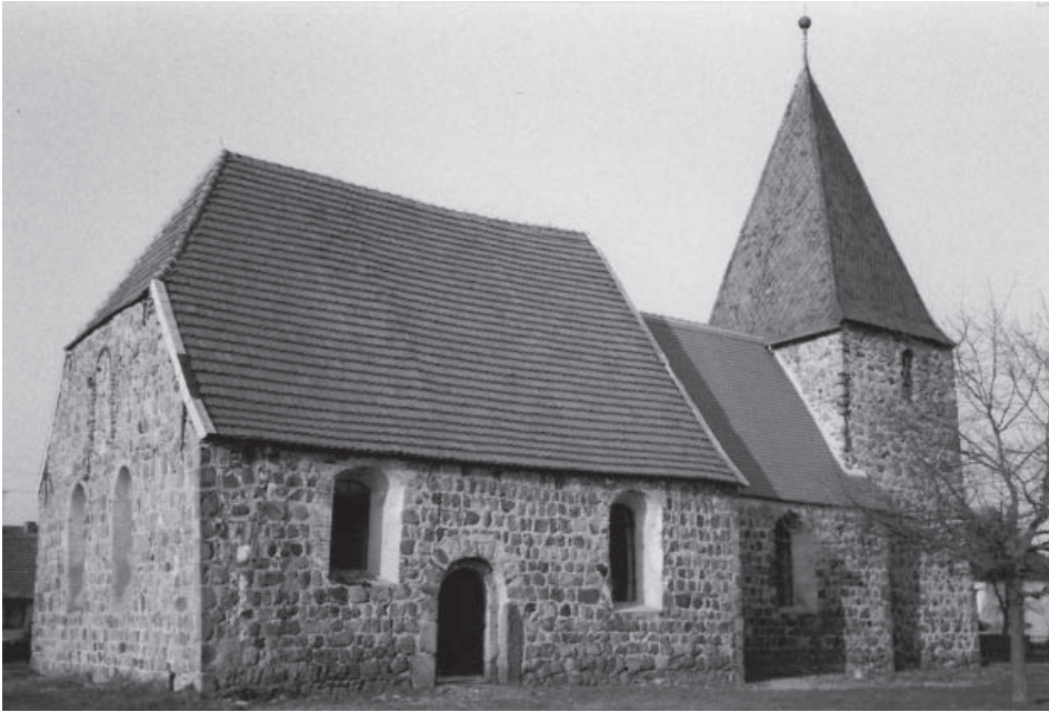
13 Ursprünglich zweiteilige Feldsteinkirche in Wallstave mit nachträglich angefügtem Ostturm
