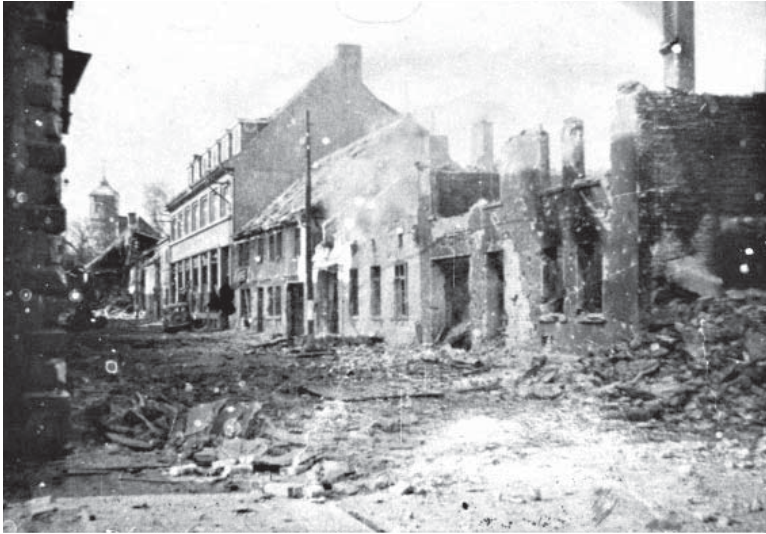
Abb. 19: Zerstörte Häuser in der Ritterstraße in Arnswalde. Aufgenommen während Feuerpausen zwischen den Kämpfen im Februar 1945 von Dr. Bernhard Claudé; Archiv der Stiftung Brandenburg, Signatur BX1817.
