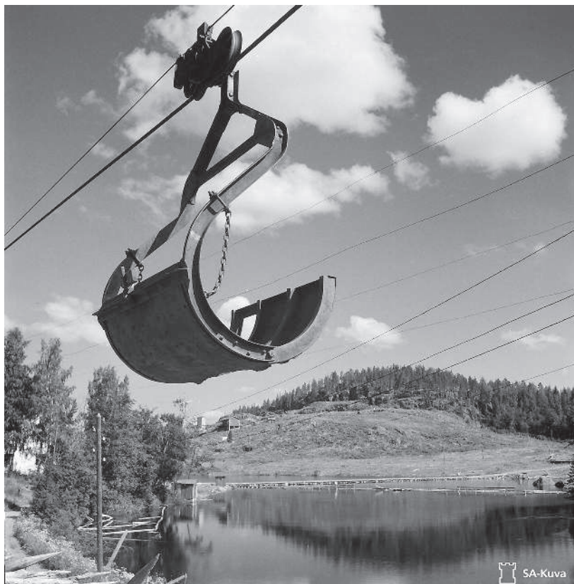
Kuva 10. Jänisjoen varrella olevan Läskelä-yhtiön Leppäkosken selluloosatehtaan ilmarata. Taustalla laaja hakkuualue. Kuva: SA-kuva 1944.
