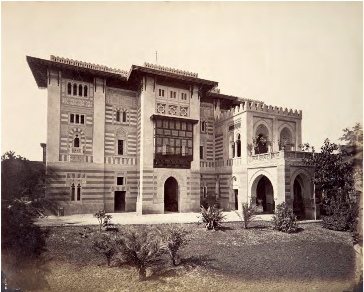
FIGURE 97 Beniamino Facchinelli, Casa del Conte Saint-Maurice costruita tutta in pezzi e modelli antichi sull'architettura araba (Cairo) . Façade of the Saint-Maurice house from the garden. Mounted albumen print. 26 × 20 cm. Raccolta artistica di fotografie sull'architettura araba, ornati ecc. dal XII° al XIII° secolo fotografia italiana del Cav. B. Facchinelli, Cairo (Egitto) , MDXXXLXXXVII [sic: XXX for CCC, soit 1887], f. 67 PARIS, BIBLIOTHÈQUE DE L'INHA, FOL PHOT 65
