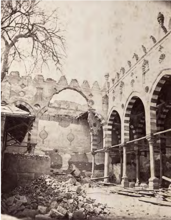
FIGURE 32 Beniamino Facchinelli, Cortile e Minareto del Mirdan (Cairo) [Courtyard of the al-Maridani Mosque after damage caused by the 1856 earthquake]. Mounted albumen print. 15 × 19 cm. Raccolta artistica di fotografie sull'architettura araba, ornati ecc. dal XII° al XIII° secolo fotografia italiana del Cav. B. Facchinelli, Cairo (Egitto) MDXXXLXXXVII [sic: xxx for CCC, i.e. 1887], f. 114 PARIS, BIBLIOTHÈQUE DE L'INHA, FOL PHOT 65
