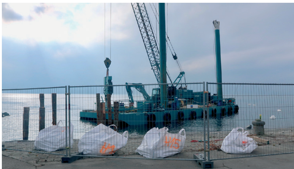
Figure 51 Barge flottante pour le vibro-fonçage des pieux lacustres et big bags numérotés de pierres retirées du perré, 20 novembre 2018. © Dominique Vinck
