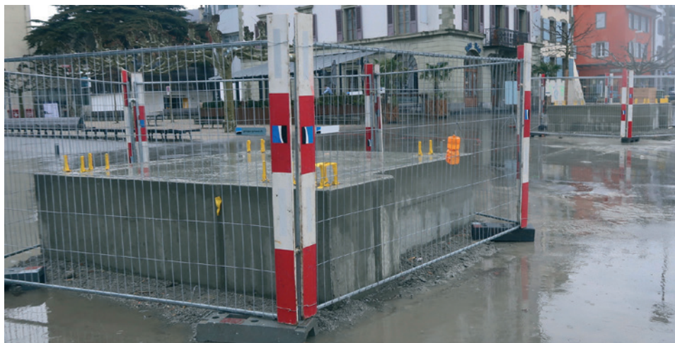
Figure 49 Fondations pour les mâts du portique Ouest, 21 décembre 2018. © Dominique Vinck
