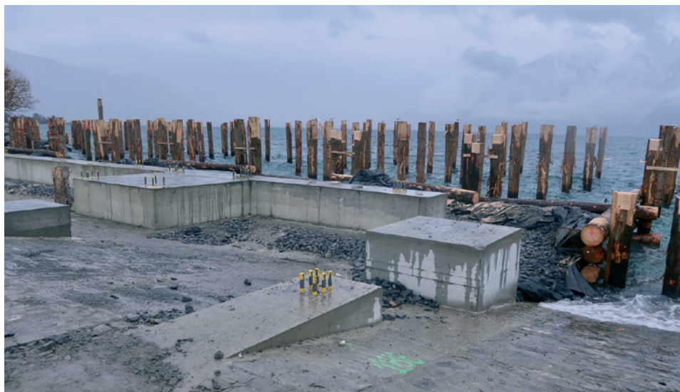
Figure 45 Plots de béton et pieux en bois pour la partie Sud de l'arène et les terrasses sur le lac, en date du 21 décembre 2018. © Dominique Vinck
