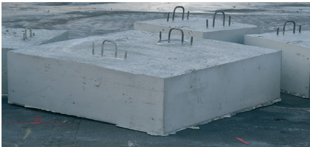
Figure 50 Socles en béton munis d’anneaux permettant de les positionner et de les récupérer, 22 octobre 2018.
