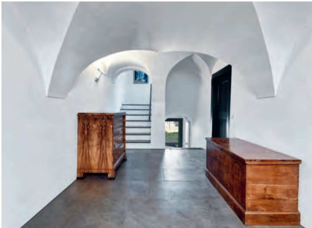
ABB. 111 Wartau, Azmoos. Poststrasse 60. Zustand nach der Restaurierung. Gegenüber der Halle von Poststrasse 56/58 wurden im jüngeren Nachbarhaus die Gewölbe weniger gedungen ausgeführt. Das Entrée wirkt grosszügig, seine Gestaltung harmonisch. Foto Jürg Zürcher, St. Gallen 2019.
