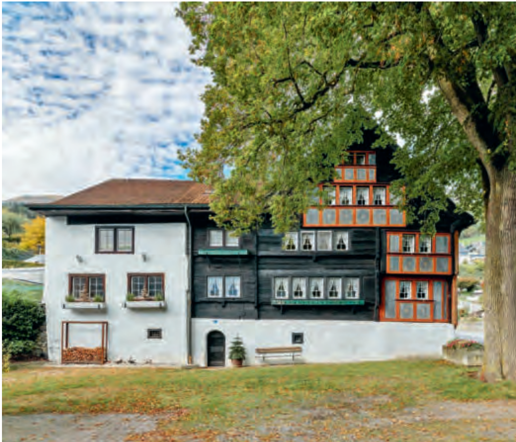
ABB. 197 Sevelen, Ober- räfis. Hostetgass 27/29. Der massive Teil links bildet den Kernbau, zu dem sich Vergleichsbeispiele in der gesamten Region Werden- berg finden lassen, beson- ders aber in Grabs und Sennwald. Daran schliesst ein traufständiger Strick- bau von um 1560 an. Sein Tätschdach wurde um 1700 aufgegeben, als man das Gebäude nochmals gegen rechts erweiterte und ein Satteldach erstellte, das Alt- und Anbau unter sich vereinigte. Foto Jürg Zürcher, St. Gallen 2019.
