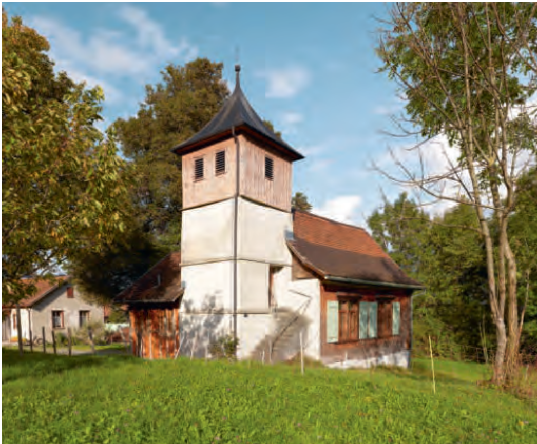
ABB. 77 Wartau, Malans. Schulhausweg. Ehem. Kapelle/ehem. Schulhaus in idyllischer Lage abseits des Dorfes. Im Bildvordergrund der spätmittelalterliche Glockenturm mit hölzerner Aufstockung von 1887/88. Der auf den Grundmauern des Kapelenschiffes erbaute Schulraum von 1819 ist an den grossen Doppelfenstern und dem Schindelschirm ablesbar. Foto Jürg Zürcher, St. Gallen 2019.
