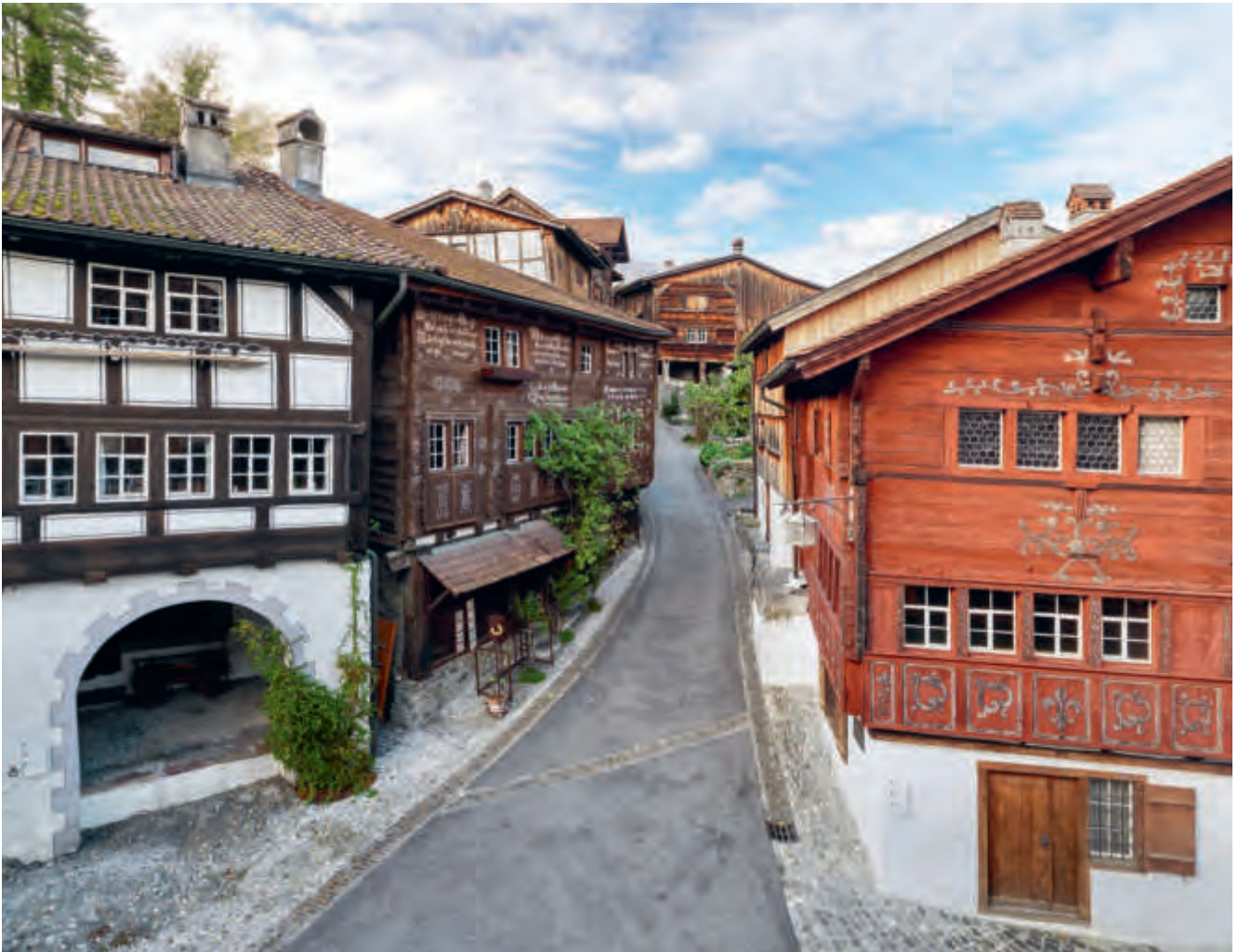
ABB. 21 Grabs, Werdenberg. Blick ins Oberstädtchen mit Städtli 25 und Städtli 26 (links) sowie Städtli 41 (rechts). Zu sehen sind die jüngeren Bauphasen der Stadt, als Strickbauweise und Fachwerkbau zur Anwendung kamen. Anders, als es heute Städtli 25 suggeriert, wurde konstruktives Fachwerk nicht offen gezeigt, sondern verkleidet oder überputzt und mit Zuglädentäfer dekorativ aufgewertet. Foto Jürg Zürcher, St. Gallen 2018.
