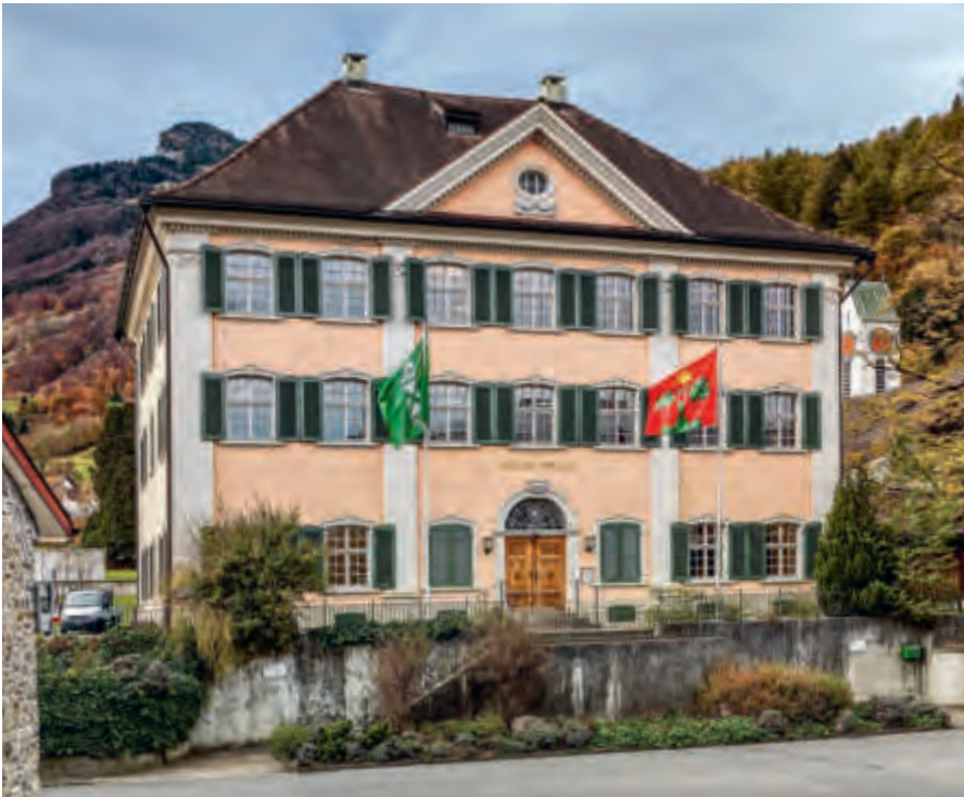
ABB. 117 Wartau, Azmoos. Poststrasse 51. Rathaus/ sog. Rotes Haus. Das Wohn- und Geschäftshaus der Familie Sulser wurde bereits zur Bauzeit durch Vorgärten und eine Stützmauer von der Poststrasse abgegrenzt und durch eine axial auf das Portal zuführende einläufige Treppe erschlossen. 1933 wurde diese Anlage durch einen Betonvorbau mit Zugang zum Archiv und eine zweiläufige Treppe ersetzt, die um 1980 zugunsten des repräsentativen Charakters des Hauses umgestaltet wurde. Foto Jürg Zürcher, St. Gallen 2018.
