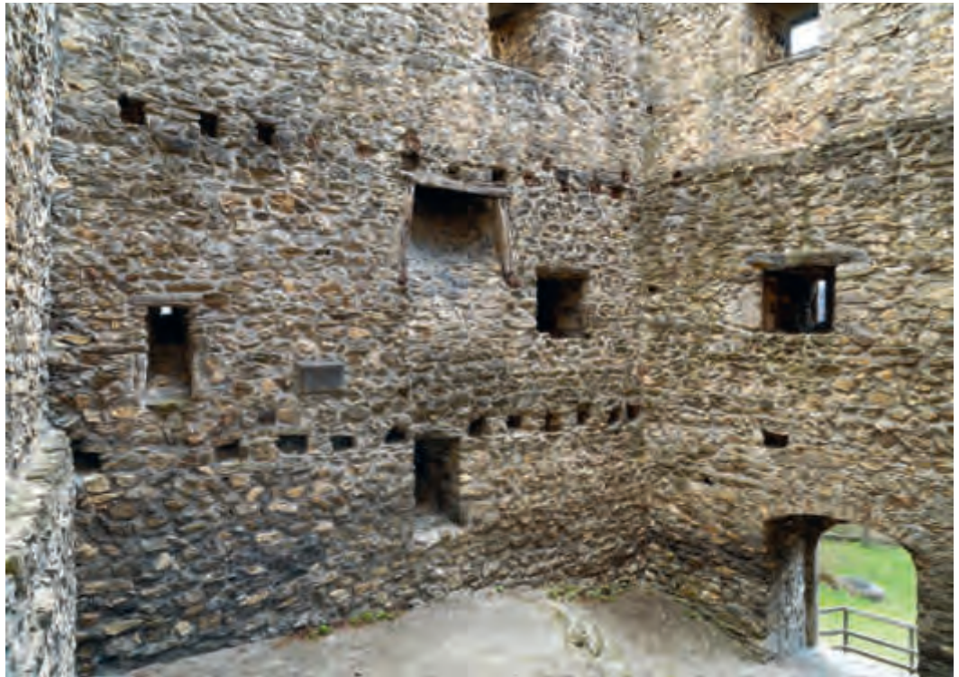
ABB. 58 Wartau, Gretschins. Burg Wartau (Liegenschaft 1584). Blick in den Westtrakt mit dem 1932 erneuerten Hofzugang und dem sichtbaren Abzug des abgegangenen Kamins im ersten Obergeschoss. Auffallend sind die kleinen Fensterformate im weitgehend geschlossenen Erdgeschoss und in der obergeschossigen Burgküche. Foto Jürg Zürcher, St. Gallen 2018.
