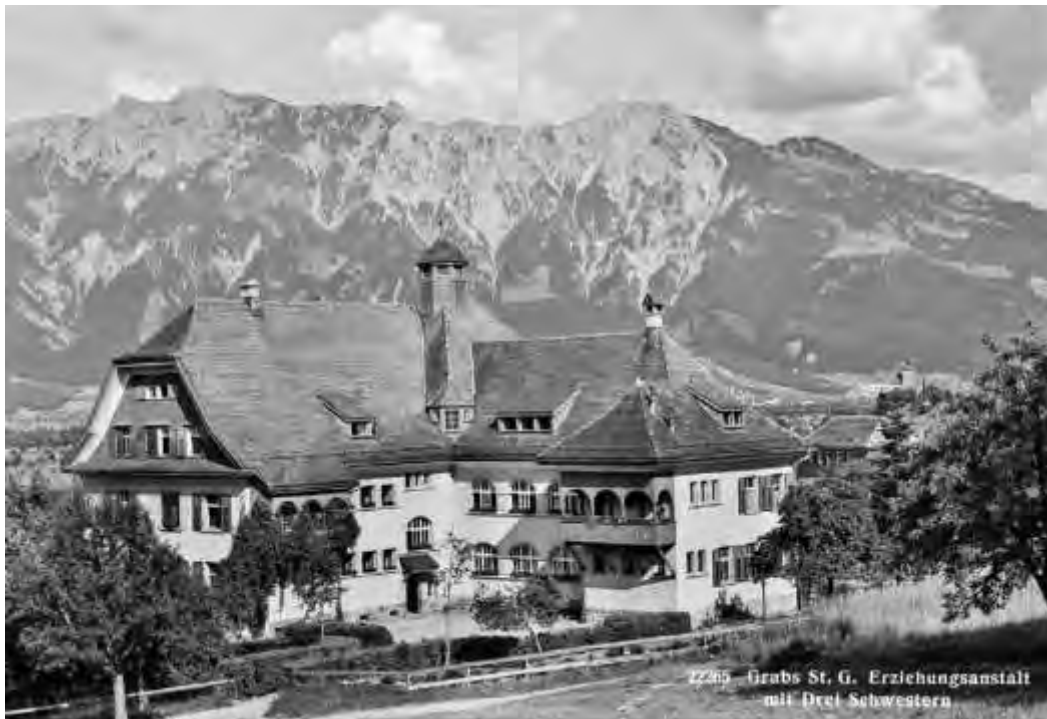
ABB. 384 Grabs, Studen. Lukashausschule 2. Sog. Lukashausschule. Werdenberger Erziehungsanstalt von 1912/13 mit pittoresker Dachlandschaft. Mit dem Verlust des Dachstuhls durch Brandstiftung 1948 verlor das Gebäude erheblich an architektonischer Qualität. Foto Foto Gross, St. Gallen 1941. (StASG, W 283/1-05288).
