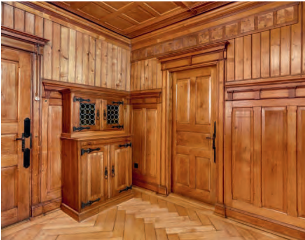
ABB. 139 Wartau, Trübbach. Poststrasse 6. Doktorhaus Saxer. Partie des unter Ernst Gensch als Stube genutzten ehemaligen Wartezimmers. Die Baupläne vermerken bereits das Krallen- oberhalb des Brusttäfers. Unter Ernst Gensch wurden das Buffet und weitere Möbel im Stil der Neurenaissance hinzugefügt, ebenso das Efeuband in Brandmalerei über der Tür. Foto Jürg Zürcher, St. Gallen 2019.
