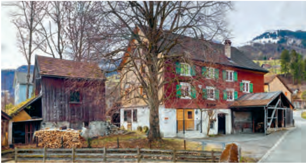
ABB. 361 Grabs, Dorf. Glockenweg 3. Hammerschmiede. Nordostansicht der früher direkt der Unterer Mühle Zur Glocke gegenüberliegenden Hammerschmiede mit einem älteren Nebengebäude (links, mit Leistschirm) und offenem, direkt am Hof bzw. an der Strasse gelegenen Pferdebeschlagplatz (rechts). Foto Jürg Zürcher, St. Gallen 2018.
