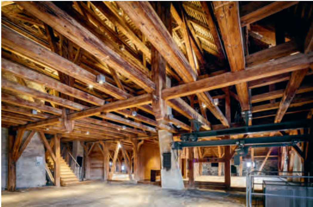
ABB. 280 Grabs, Werdenberg. Schlossweg 6. Schloss Werdenberg. Unterstes Dachgeschoss. Holzkonstruktion aus der Zeit des Wiederaufbaus 1696/97. Foto Daniel Ammann, Herisau 2015.
