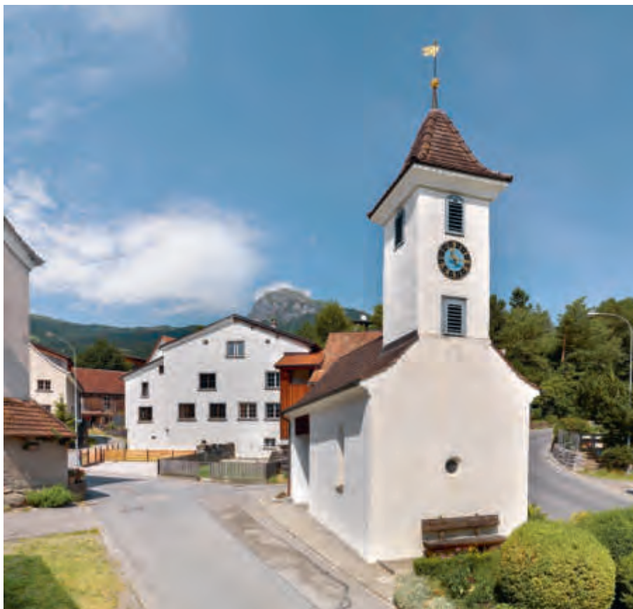
ABB. 64 Wartau, Fontnas. Dorfplatz mit Erasmuskapelle. Das hinter der Kapelle sichtbare Haus Dorfstrasse 13/15/Plattastutzweg 2 entstand zwischen 1589 und 1607 und war Wohnsitz von Leonhard Müller, Ammann des Schlosses Wartau. Regional untypisch sind seine Kubatur und das niedrig geneigte Satteldach – offenbar eine bauliche Anlehnung an die Bauernhäuser Graubündens. Nach dem Brand 1816 wurde das stattliche Haus infolge der damals beengten Wohnsituation unterteilt. Für die Region ungewöhnlich blieb das im 19. Jh. neu aufgerichtete Rafendach. Foto Jürg Zürcher, St. Gallen 2019.
