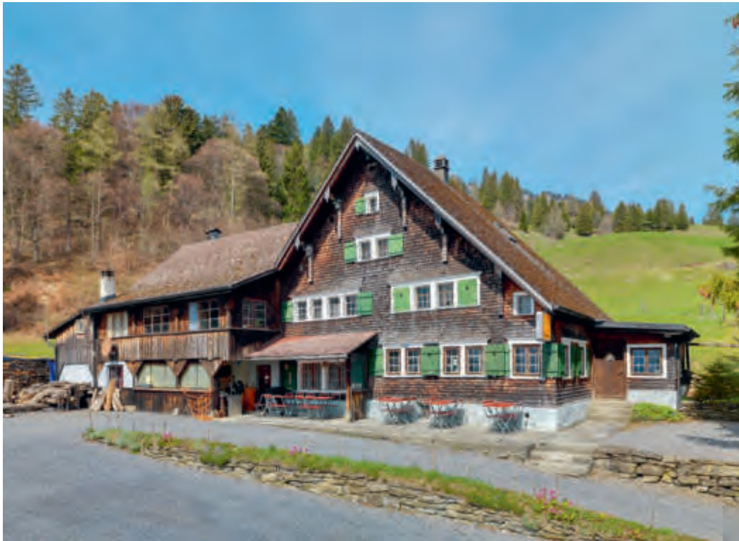
ABB. 129 Wartau, Lavadarsch. Lavadarsch 3. Berggasthof. Vermutlich verbirgt sich hinter dem Schindelschirm ein älterer Strickbau, der Ende des 18. Jh. mit dem bestehenden Steilgiebel seine heutige Baugestalt erhielt. Der Bau gehört zu den wenigen historischen Berggasthöfen im Bandgebiet. Foto Jürg Zürcher, St. Gallen 2019.
