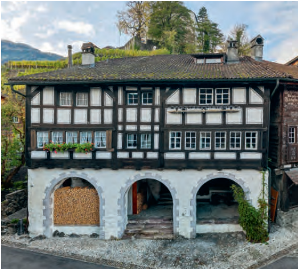
ABB. 329 Grabs, Werdenberg. Städtli 24/25. Südostansicht. Die in der Fassade erhaltenen zweigeschossigen Ständer des Bohlenständerbaus zeichnen die Grundrissdisposition im Inneren nach: rechts Städtli 25 mit imposanter Stube, mittig ein schmaler Gang, links eine grosszügige Nebenstube in Städtli 24. Später wurde das Fachwerk überputzt und Massivbauweise imitiert. Foto Jürg Zürcher, St. Gallen 2018.
