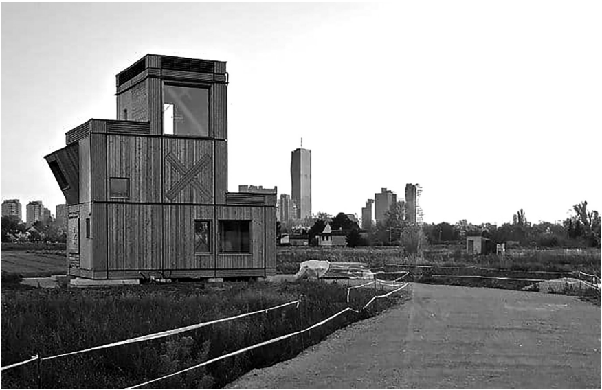
Abb. 3: 3-geschossiger Vivihouse-Prototyp. Foto: Vivihouse, CC BY-SA.
