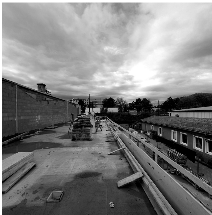
Abb.1 und 2: Baustelle habiTAT -Hausprojekt SchloR , Wien-Simmering. Foto: Gabu Heindl Architektur, CC BY-SA.
