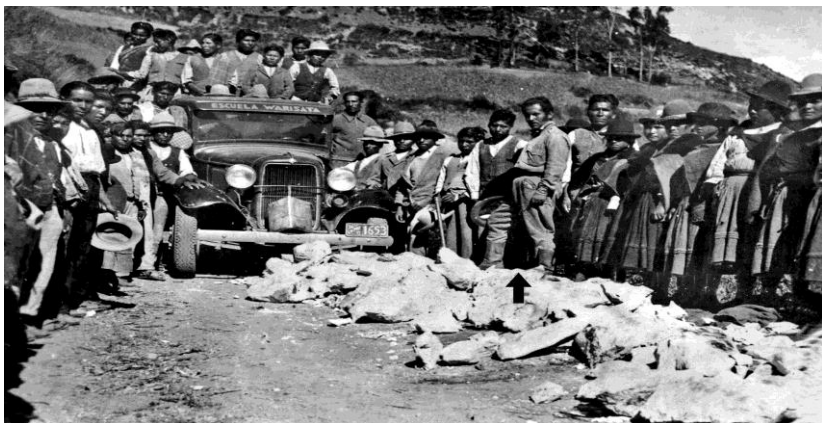
Imagen n° 4. Periodo de construcción de Warisata 193 .
