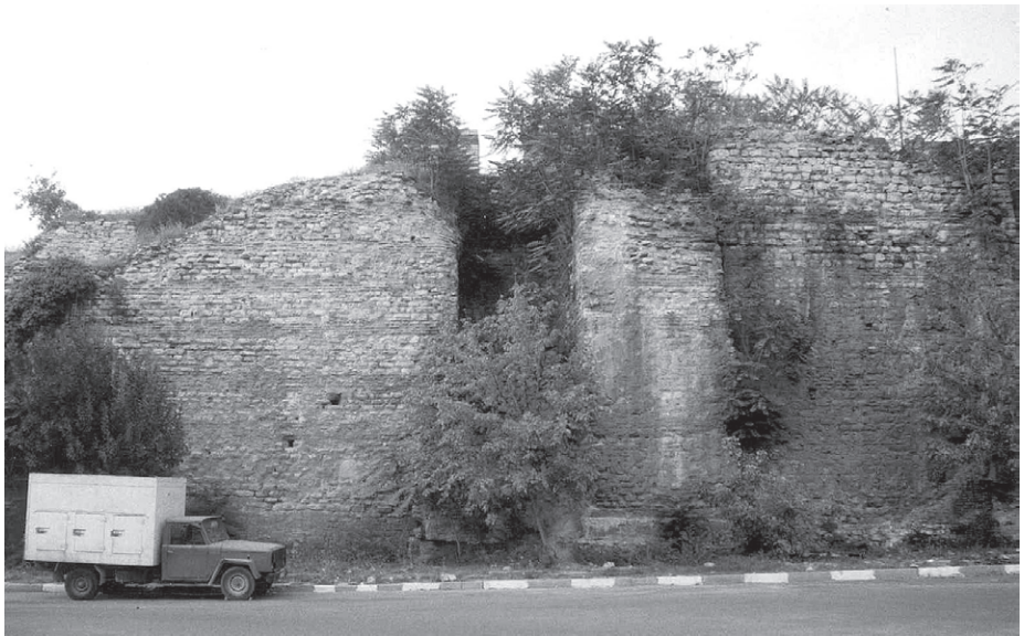
Abb. 98 Landmauer, Turm 86, stadtseitige Kurtinennische
