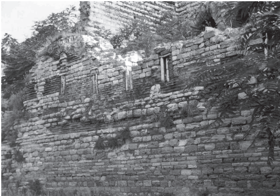
Abb. 84 Landmauer, Kurtine südlich vom Vortor des Romanos-Tors, Feldseite
