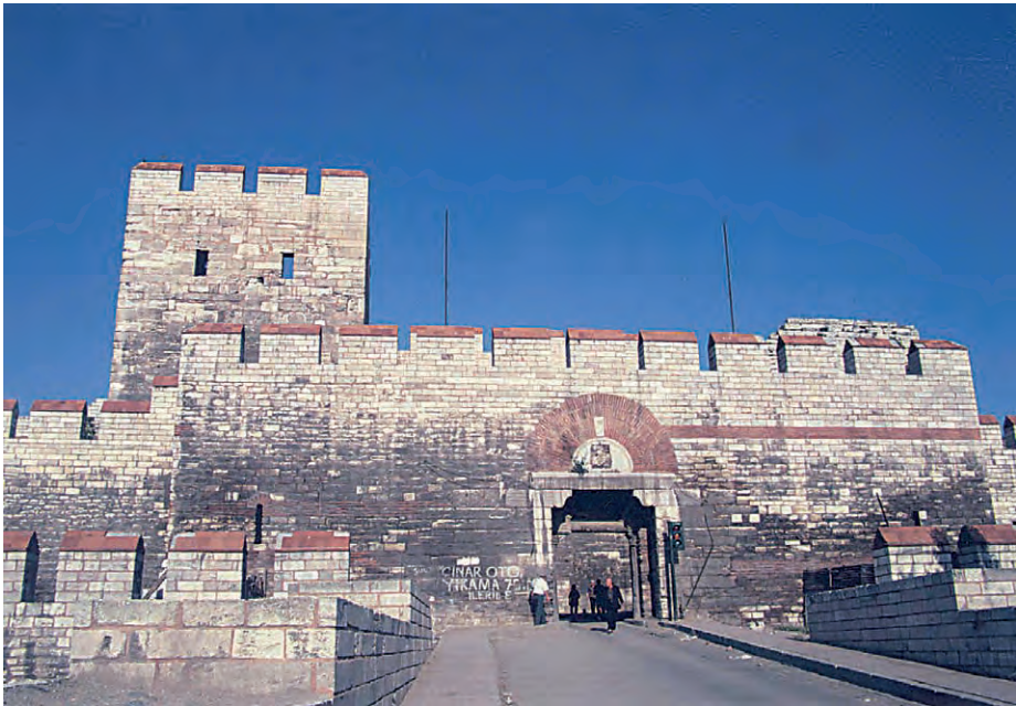
Abb. 14 Landmauer, MevlevihaneKapı, Vortor, Feldseite
