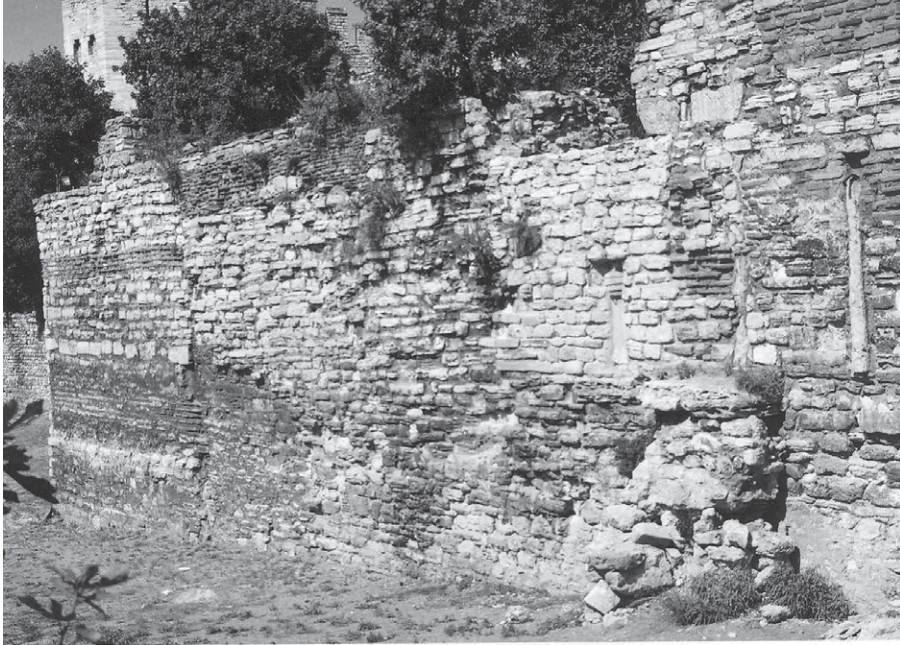
Abb. 123 Landmauer, Goldenes Tor, Nordwestecke des Vorwerks und Baufugen
