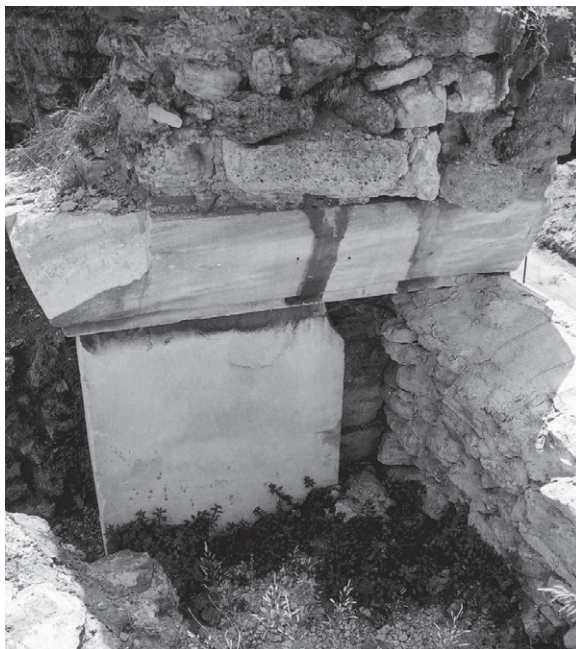
Abb. 130 Landmauer, Goldenes Tor, Vortor, Nordseite, zugemauerte Öffnung, von Norden
