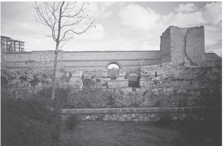
Abb. 118 Landmauer, Turm 30 und Kurtine 30/31, Nebenöffnung, Feldseite
