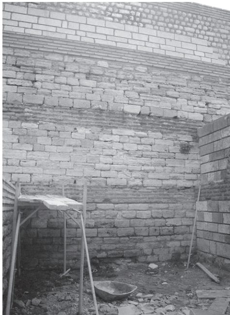
Abb. 90 Landmauer, Turm 65, südlicher Torturm des Topkapı, Inneres
