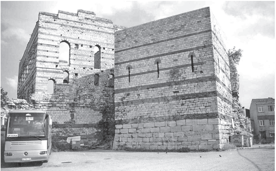
Abb. 175 Tekfur Sarayı, Westgiebel und Turm 96a, von Südwesten
