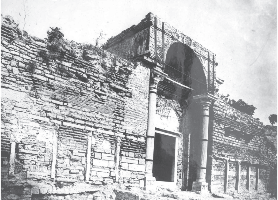
Abb. 125 Landmauer, Goldenes Tor, Vorwerk und Vortor, Feldseite
