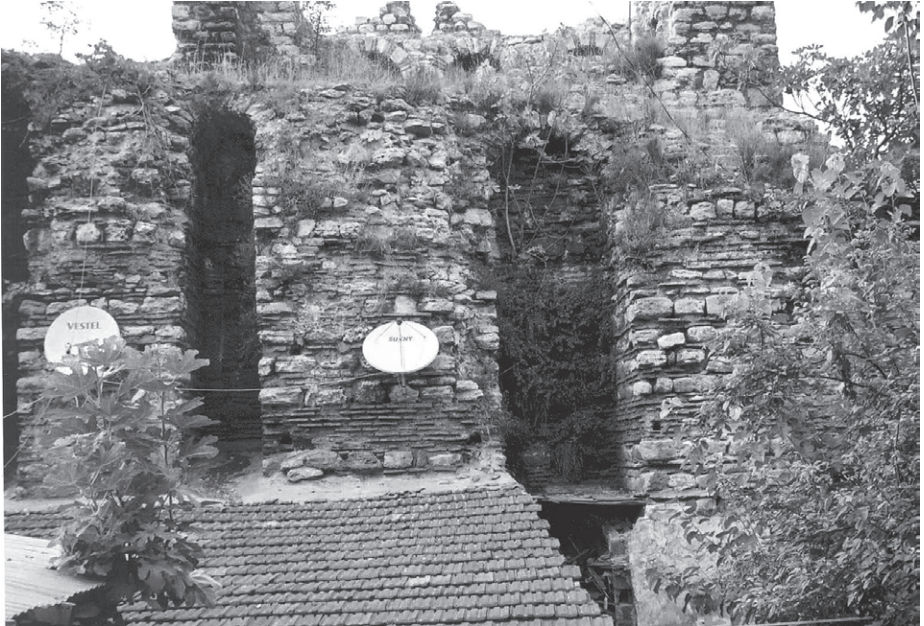
Abb. 154 Komnenen-Mauer, Nordtrakt, Stadtseite von Turm 12
