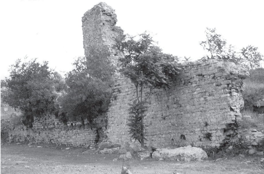
Abb. 95 Landmauer, Vormauerkurtine nördlich von Sulukulekapı und Turm 79
