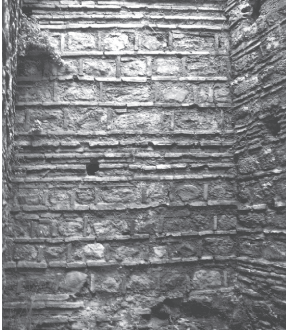
Abb. 164 Blachernen-Mauer, Cloissonnémauerwerk, innerhalb von Turm 13
