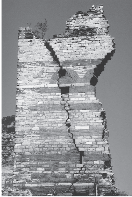
Abb. 51 Landmauer, Turm 45, Westseite
