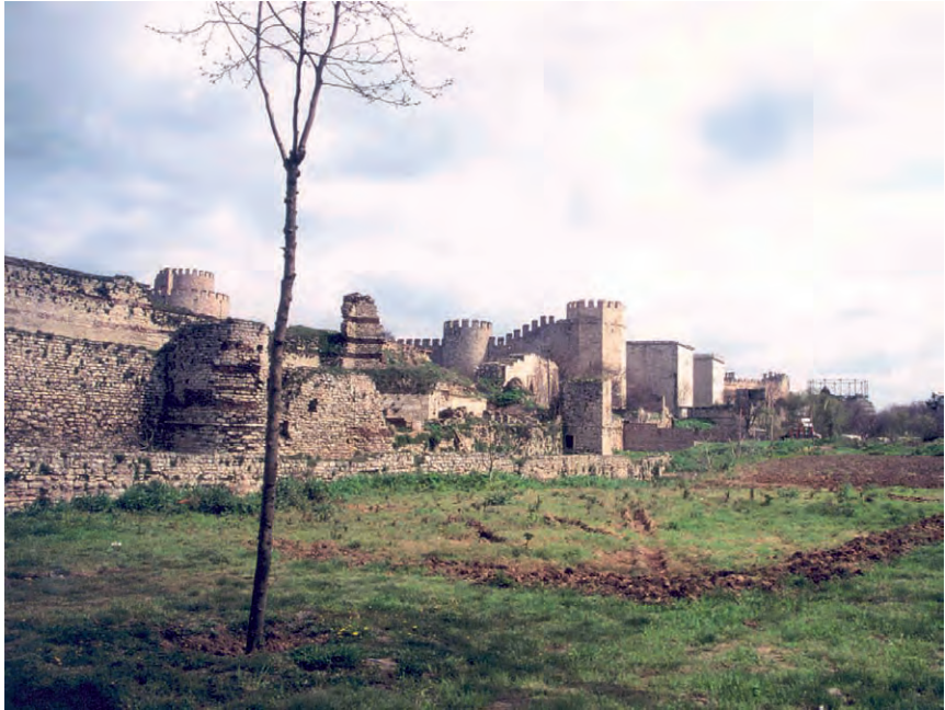
Abb. 3 Landmauer, Blick in Richtung Yedikule, von Nordwesten
