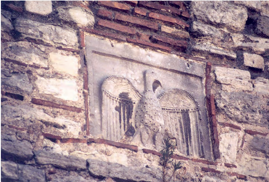
Abb. 10 Landmauer, Yedikulekapısı, Stadtseite, Adler-Relief
