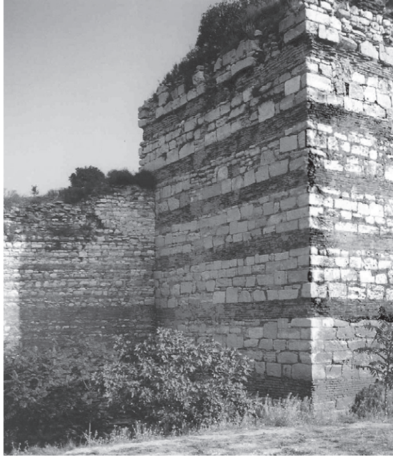
Abb. 150 Komnenen-Mauer, Turm 9, Nordflanke und Kurtine 9/10
