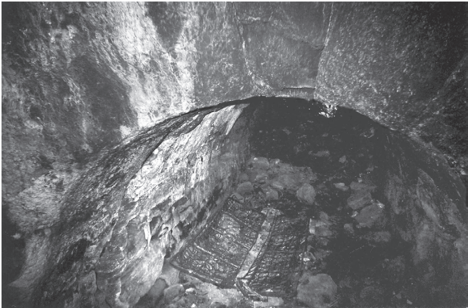
Abb. 100 Landmauer, Turm 86, Eingang
