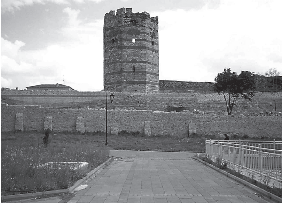
Abb. 49 Landmauer, Graben und Turm 63, Feldseite
