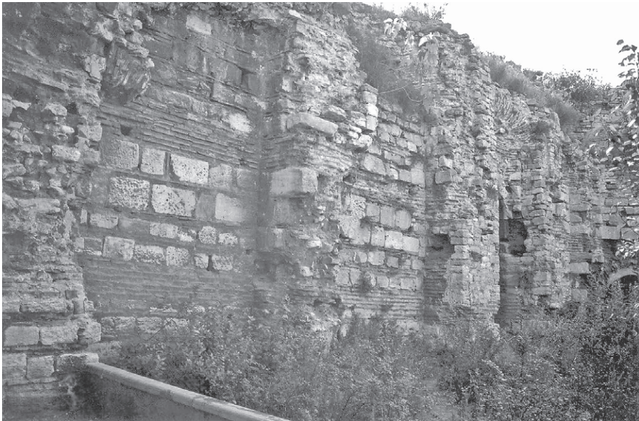
Abb. 153 Komnenen-Mauer, Südtrakt, Kurtine 2/3, Stadtseite
