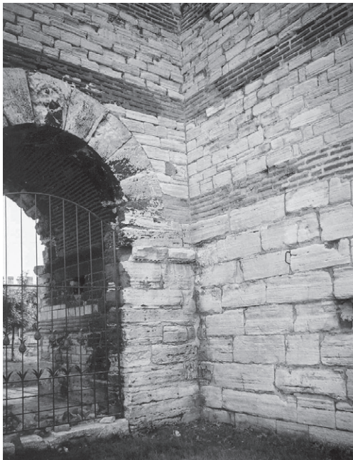
Abb. 112 Landmauer, Kurtine 1/2, Nebenöffnung und Nordflanke von Turm 1
