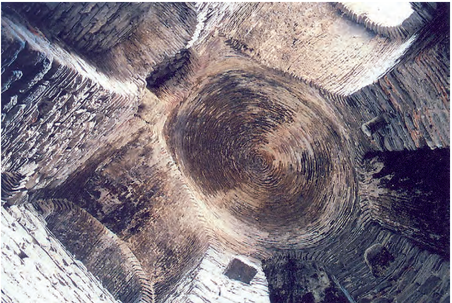
Abb. 19 Komnenen-Mauer, Turm 1, Inneres
