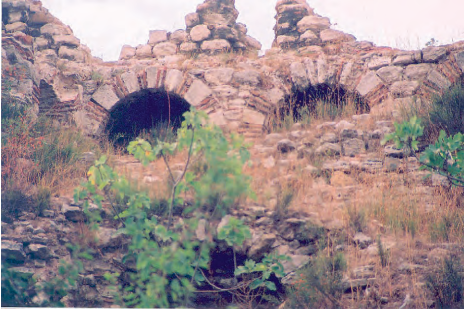
Abb. 24 Komnenen-Mauer, Turm 12, Inneres
