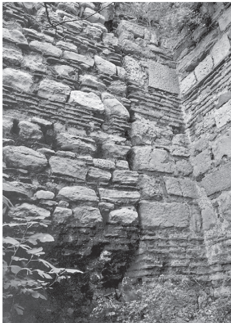
Abb. 155 Komnenen-Mauer, Treppe hinter Turm 8, Detail
