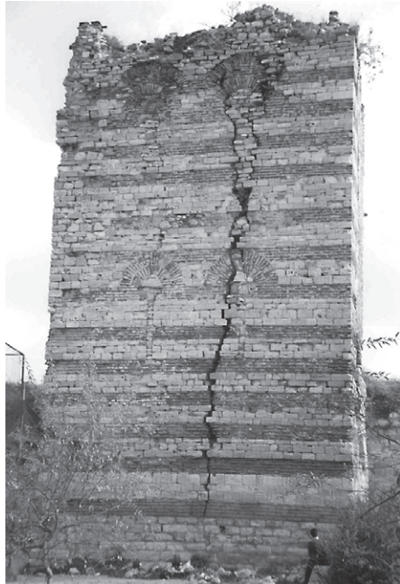
Abb. 57 Landmauer, Turm 93, Westseite
