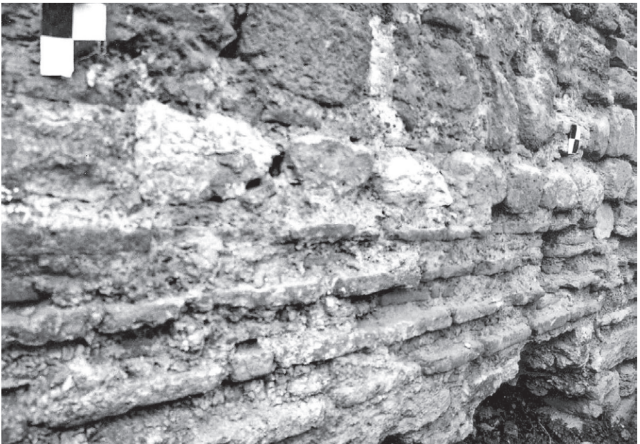
Abb. 179 Rückseite vom Turm 96a, Mauerwerk, Stadtseite
