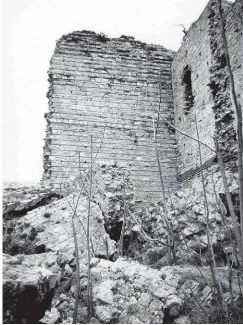
Abb. 83 Landmauer, Turm 59, südlicher Torturm des Romanos-Tors, Nordflanke von Süden
