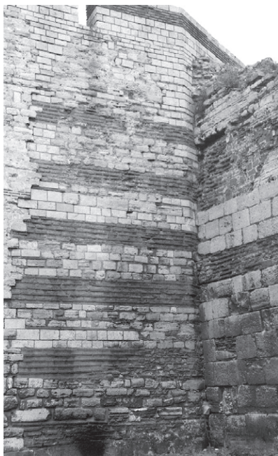
Abb. 103 Landmauer, Turm 86 und Kurtine 85/86, Feldseite
