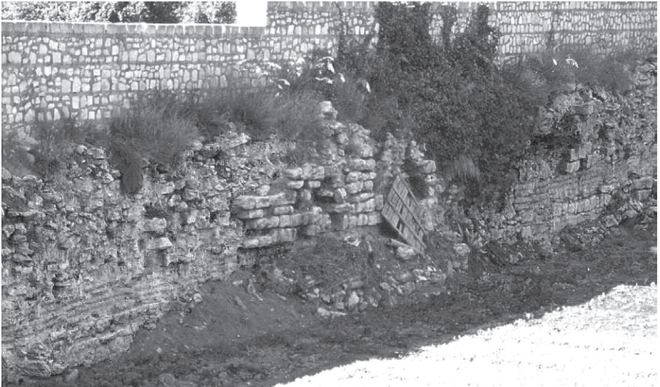
Abb. 66 Landmauer, Grabenmauer zwischen Yedikule und Belgratkapı
