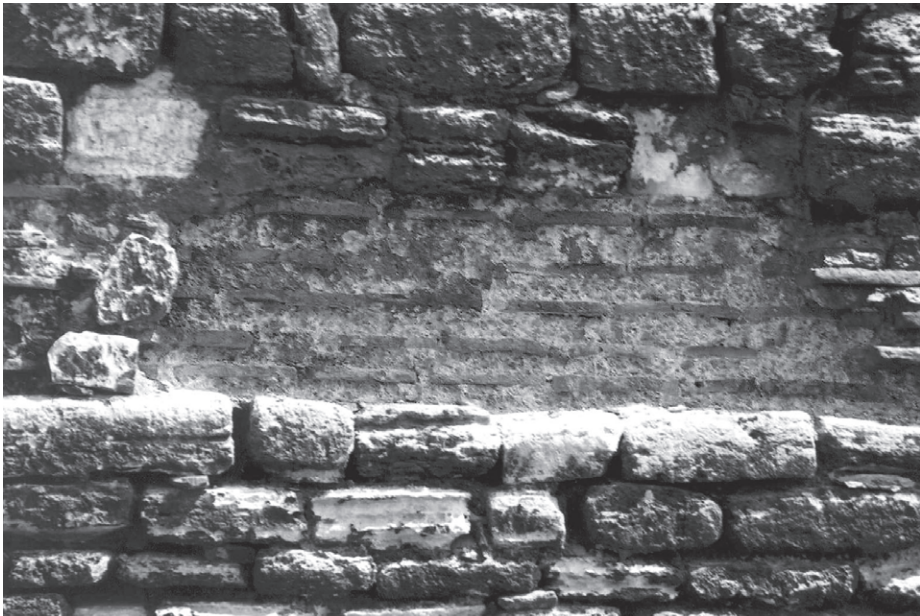
Abb. 108 Landmauer, Kurtine 82/83, Detail, Feldseite
