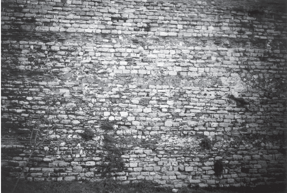
Abb. 107 Landmauer, Kurtine 82/83, Feldseite
