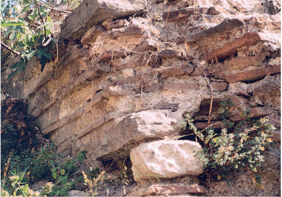
Abb. 26 Blachernen-Mauer, Cloissonnémauerwerk, stadtseitige Verlängerung, Detail
