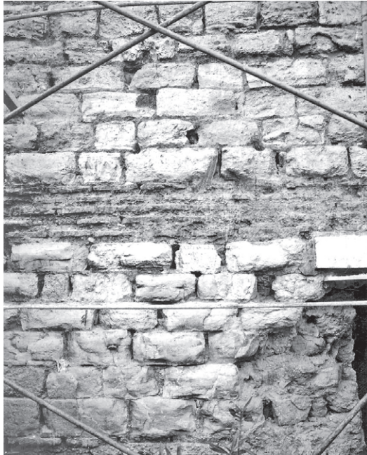
Abb. 180 Tekfur Sarayı, Mauerwerk unterhalb des Ostgiebels
