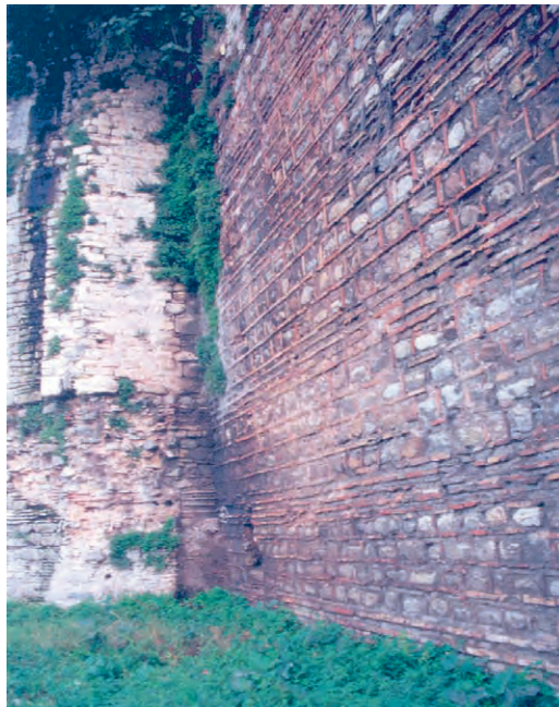
Abb. 23 Blachernen-Mauer, Cloissonnémauerwerk, Feldseite
