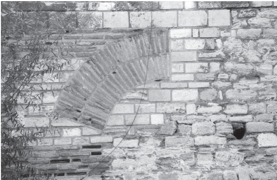
Abb. 92 Landmauer, Topkapı, Stadtseite, Bogenrest
