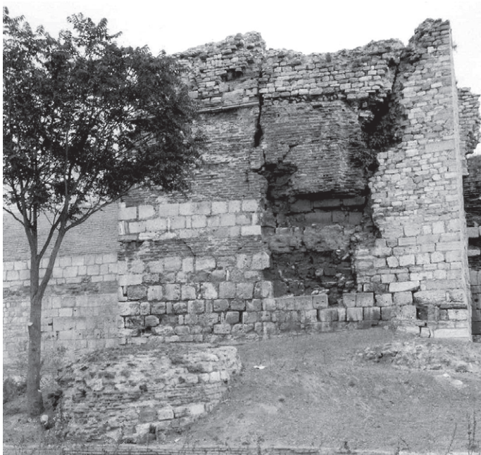
Abb. 56 Landmauer, Turm 88, Westseite
