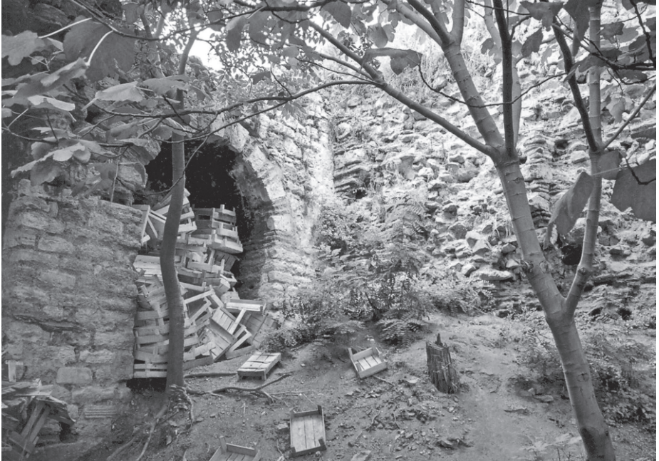
Abb. 162 Ecke zwischen Komnenen-Mauer 12/13 und Cloissonnémauerwerk, Stadtseite
