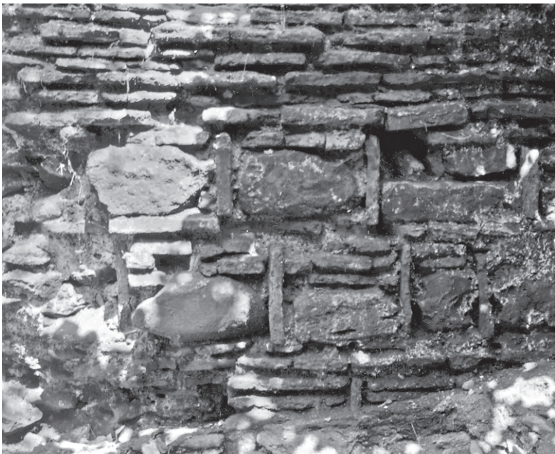
Abb. 163 Blachernen-Mauer, Cloissonnémauerwerk, Detail, stadtseitige Verlängerung
