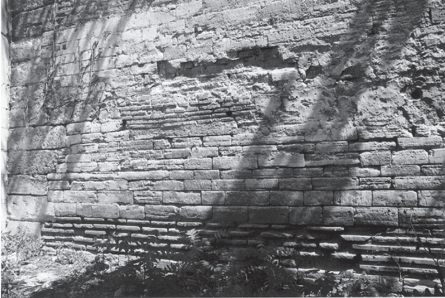
Abb. 127 Landmauer, Kurtine 8/9, südlich des Südpylonen, Feldseite
