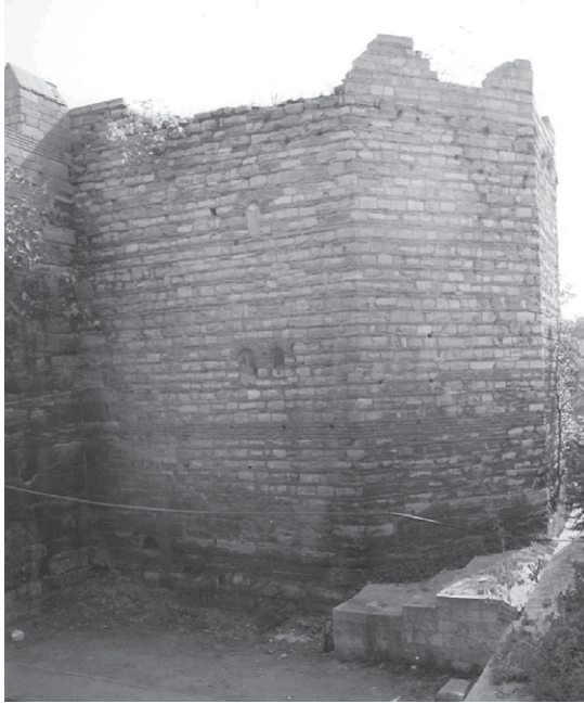
Abb. 71 Landmauer, Turm 35, südlicher Torturm von Silivrikapi
