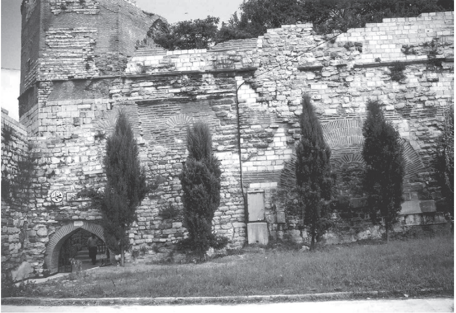
Abb. 142 Untere Blachernen-Mauer, Leon-Vorwerk, Feldseite
