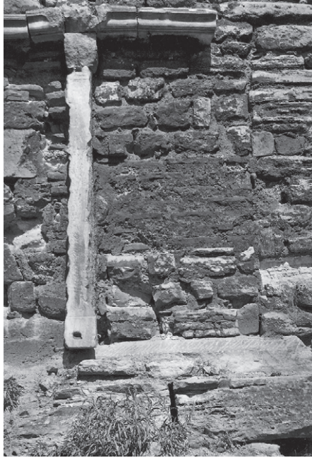
Abb. 131 Landmauer, Goldenes Tor, Vortor, Südseite, Baufuge, Feldseite
