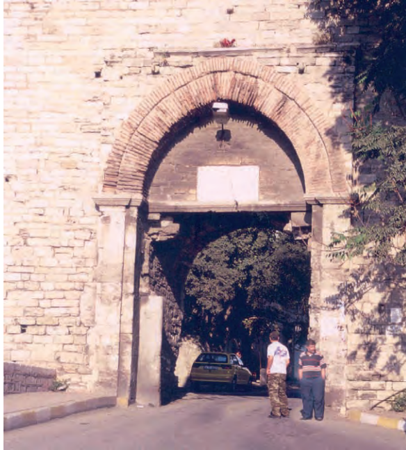
Abb. 9 Landmauer, Yedikulekapısı, Feldseite
