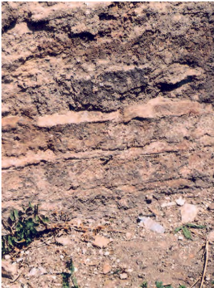
Abb. 27a Tekfur Sarayı, Stadtseite, Mauerwerk, Detail
