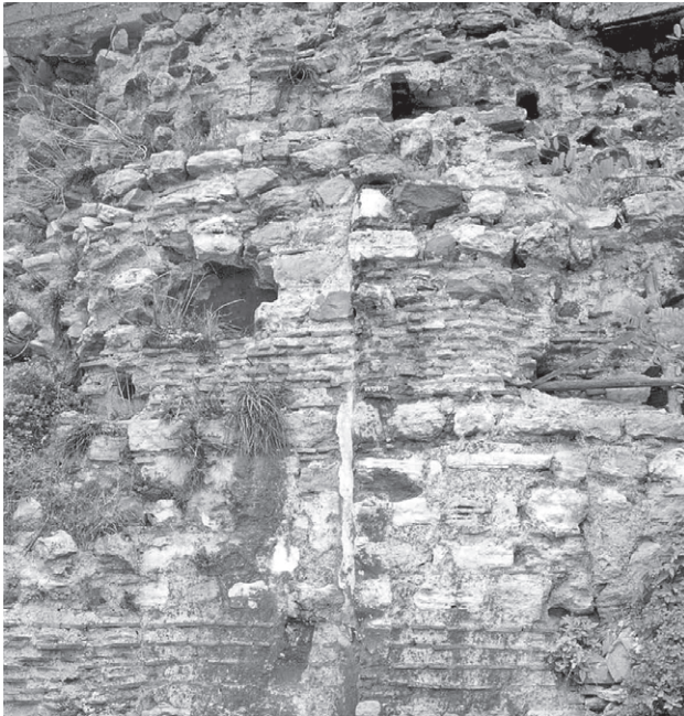
Abb. 173 Terrassenmauer hinter der Blachernen-Kirche, Detail
