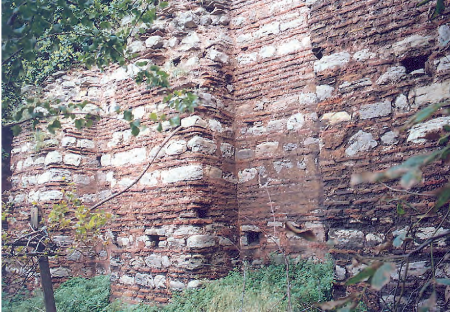
Abb. 20 Komnenen-Mauer, Kurtine Tekfur Sarayı-Nordturm/Turm 1, Stadtseite
