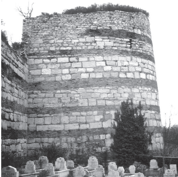
Abb. 149 Komnenen-Mauer, Turm 5, Nordseite
