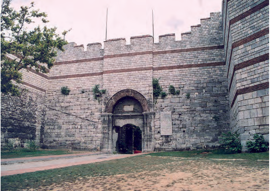
Abb. 18 Landmauer, Edirnekapı, Feldseite
