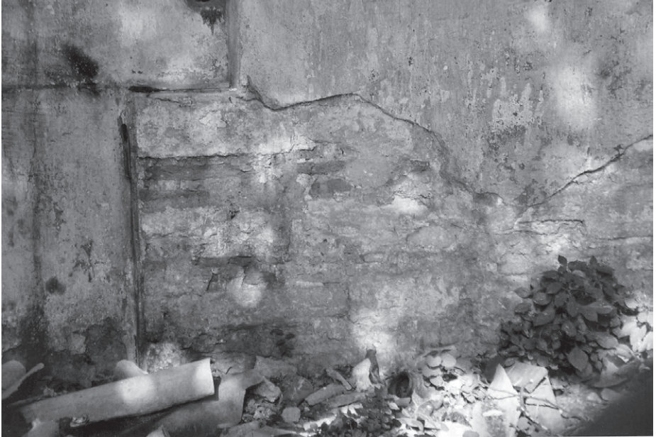
Abb. 113 Landmauer, Yedikule, Kurtine 11/12, Torausklingung, Feldseite
