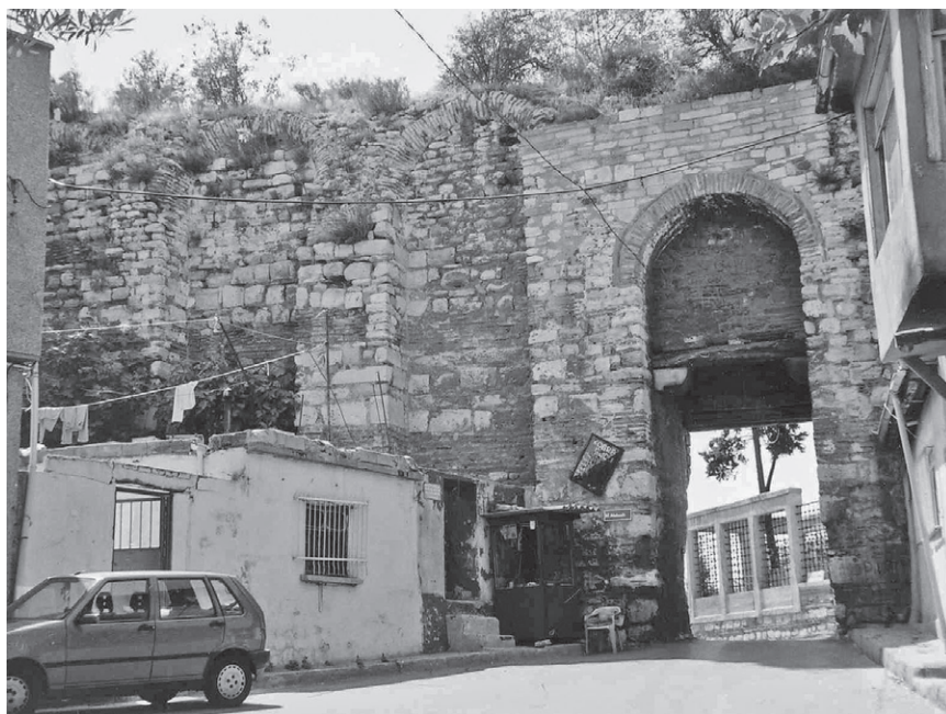
Abb. 157 Komnenen-Mauer, Eğrikapı, Stadtseite
