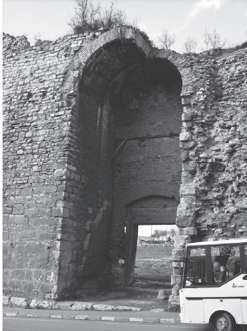
Abb. 93 Landmauer, Sulukulekapı, Stadtseite
