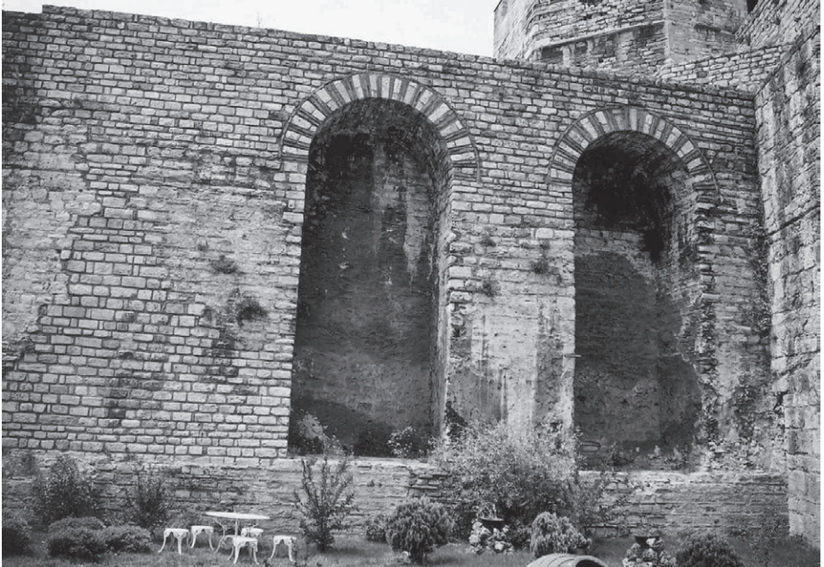
Abb. 117 Landmauer, Yedikule, Kurtine 10/11, Stadtseite
