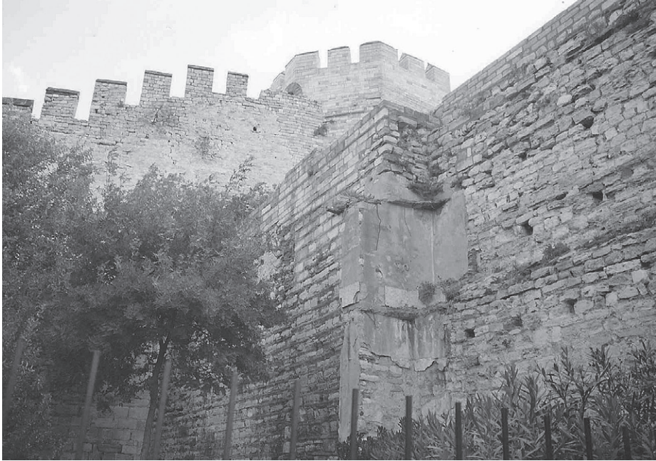
Abb. 115 Landmauer, Yedikule, Kurtine 11/12, Stadtseite
