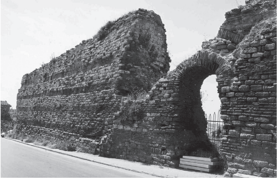
Abb. 105 Landmauer, Kurtine 81/82 und Eingang von Turm 82, Stadtseite
