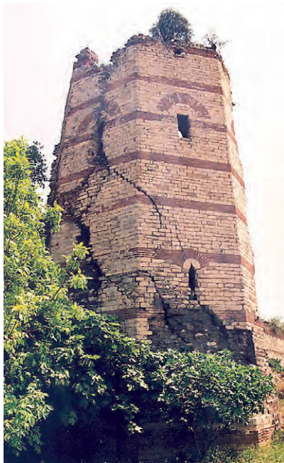
Abb. 4 Landmauer, Turm 17, von Nordwesten
