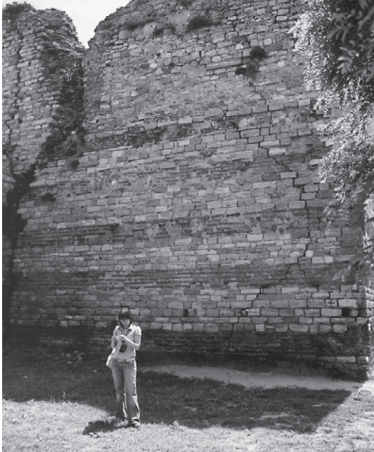
Abb. 55 Landmauer, Turm 75, Nordflanke
