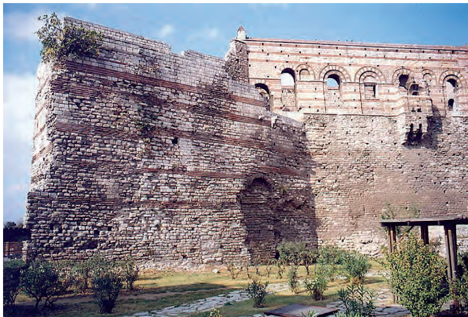
Abb. 6 Landmauer, Stadtseite des Vorturms 96a und Tekfur Sarayı
