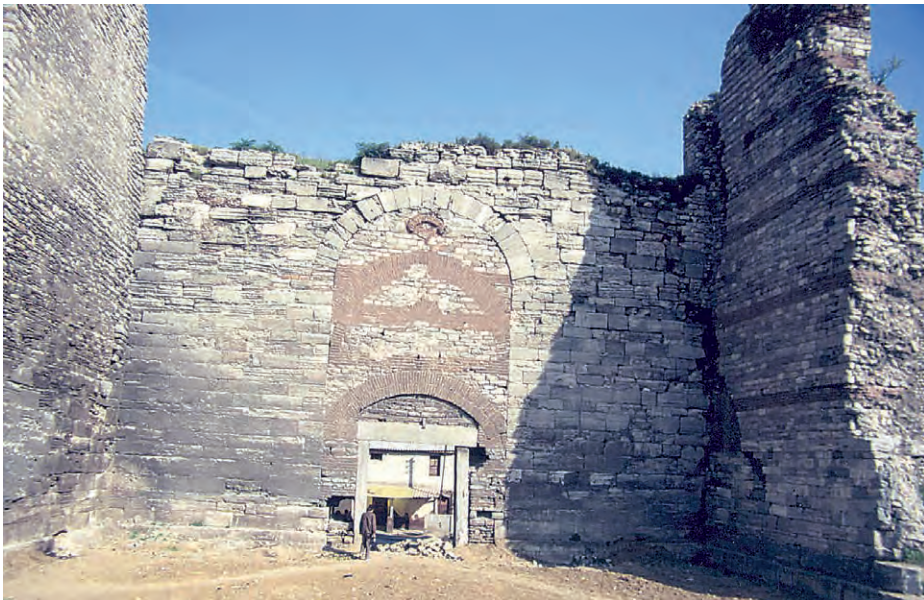
Abb. 17 Landmauer, Sulukulekapı, Feldseite
