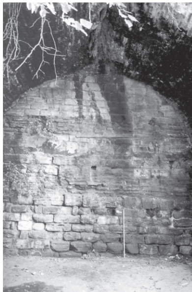
Abb. 145 Untere Blachernen-Mauer, Zweifronten-Wehrgang, Stadtseite, unter dem Treppenbogen
