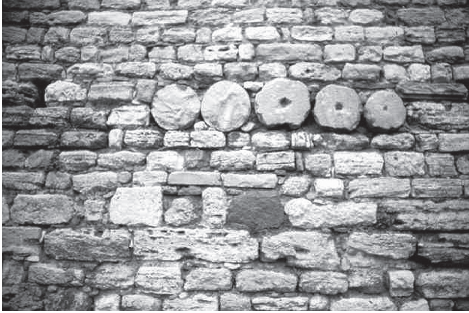
Abb. 160 Komnenen-Mauer, Kurtine 12/13, Detail, Feldseite
