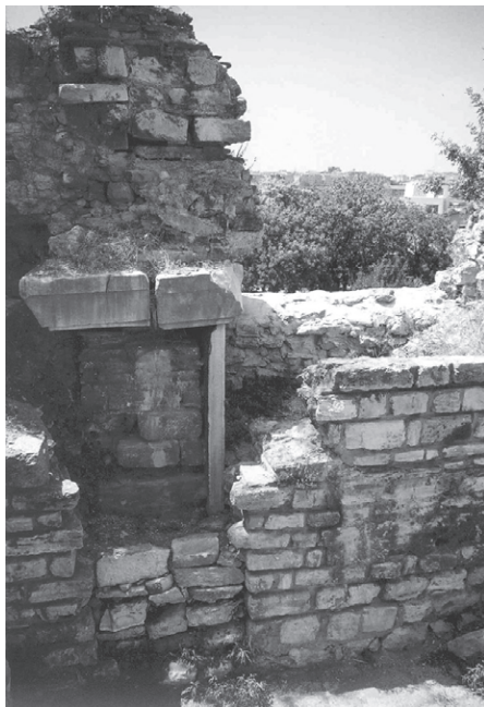
Abb. 129 Landmauer, Goldenes Tor, Vortor, Nordseite, zugemauerte Öffnung, Stadtseite
