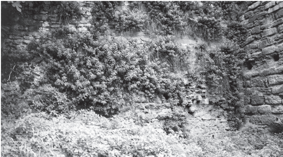
Abb. 165 Untere Blachernen-Mauer, Ecke zwischen Substruktion und 14-Meter-Mauer, Stadtseite
