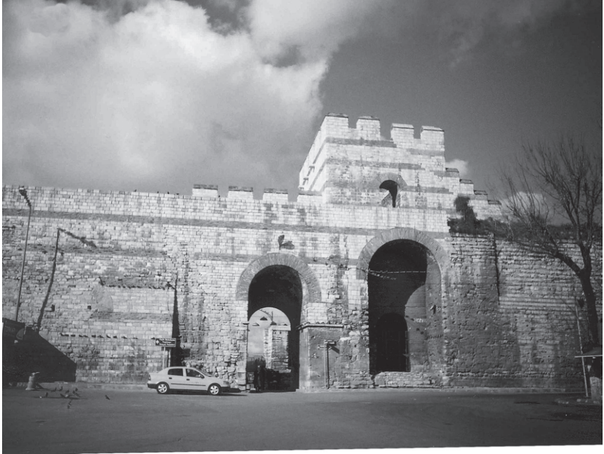
Abb. 89 Landmauer, Topkapı, Stadtseite
