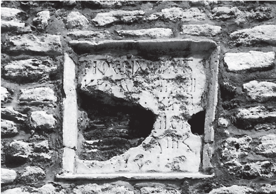
Abb. 60 Landmauer, Vorturm 34a, Inschrift
