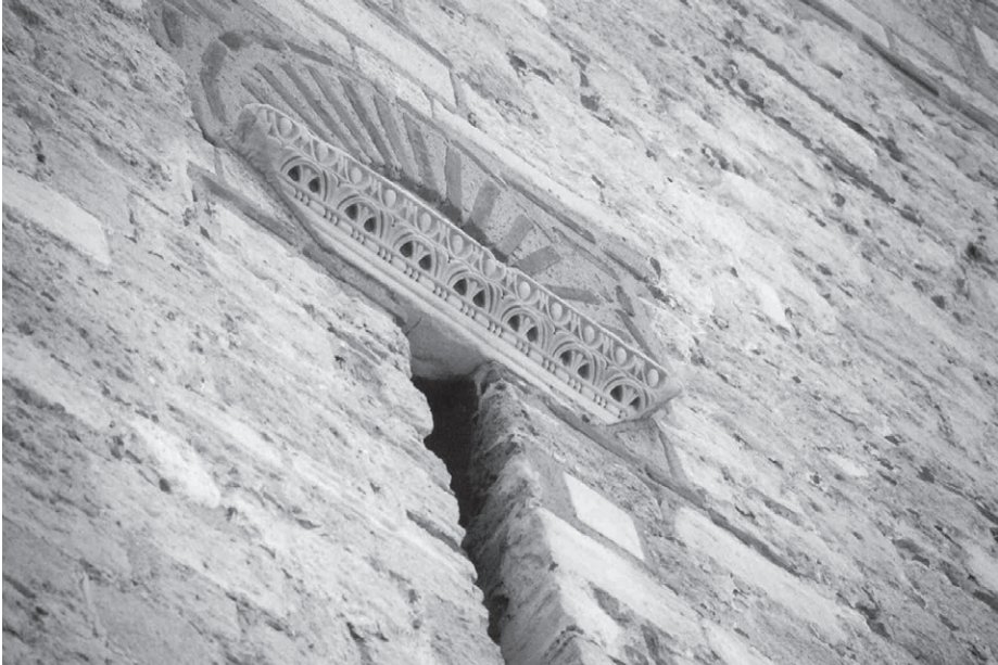
Abb. 197 Landmauer, Turm 61, Gesimsfragment
