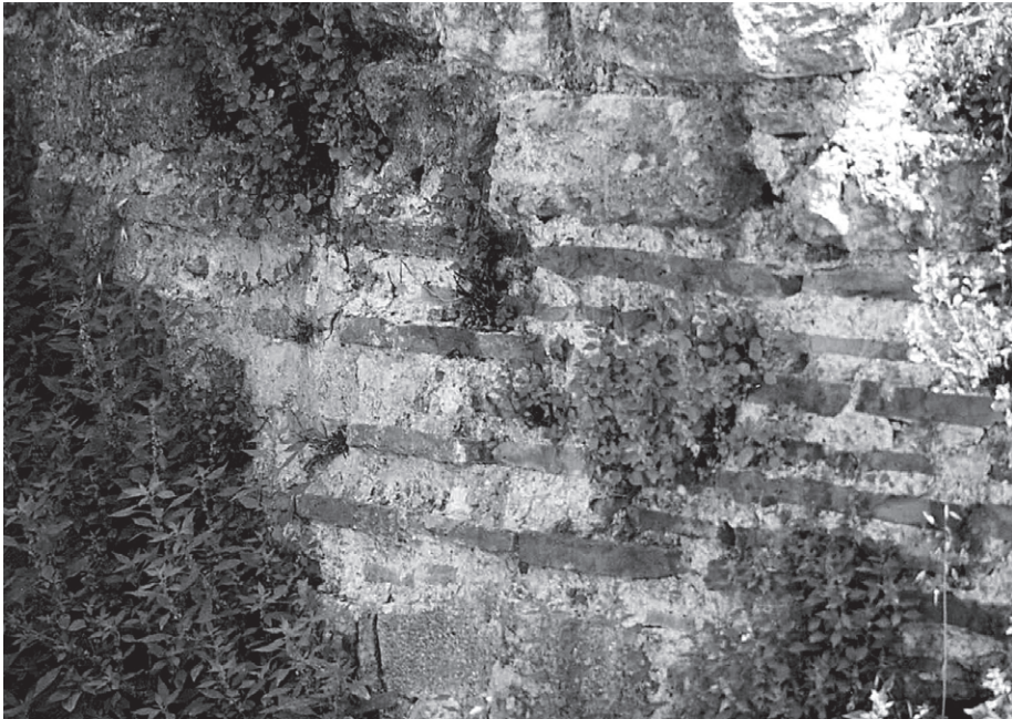
Abb. 64 Landmauer, Vorturm 79a, Mauerwerk, Detail
