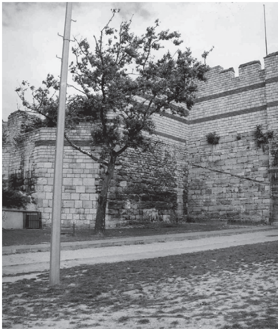
Abb. 96 Landmauer, Turm 87, nördlicher Torturm von Edirnekapı, von Südwesten
