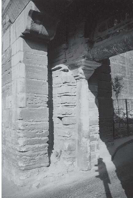
Abb. 81 Landmauer, Mevlevihanekapı, Vortor, Fallgatterschlitz
