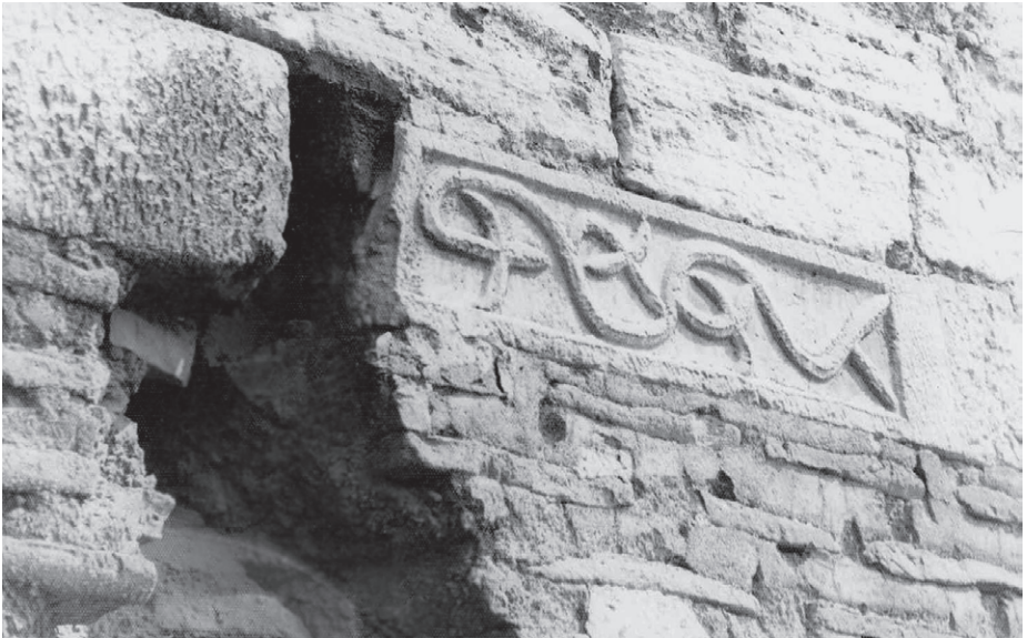
Abb. 110 Landmauer, Turm 84, Detail, Westseite
