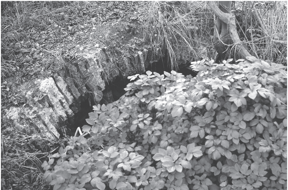
Abb. 139 Untere Blachernen-Mauer, 14-Meter-Mauer, Gewölbe
