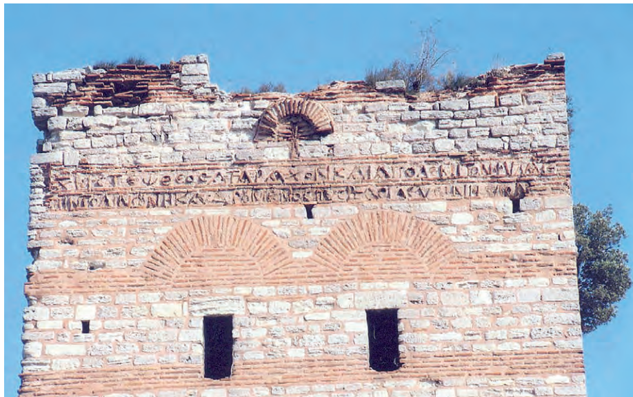
Abb. 5 Landmauer, Turm 54, obere Partie, Westseite
