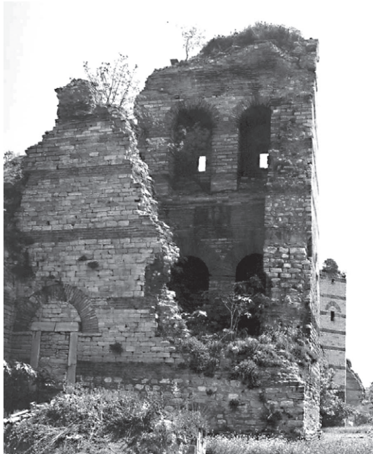
Abb. 50 Landmauer, Turm 18, Nordflanke
