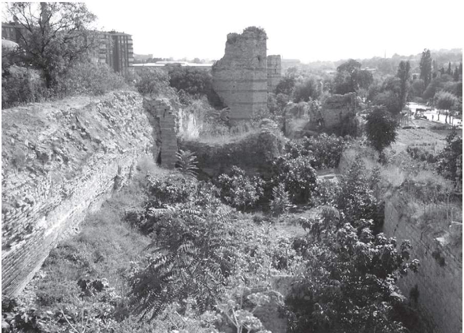
Abb. 74 Landmauer, Blick Richtung Turm 37, von Norden
