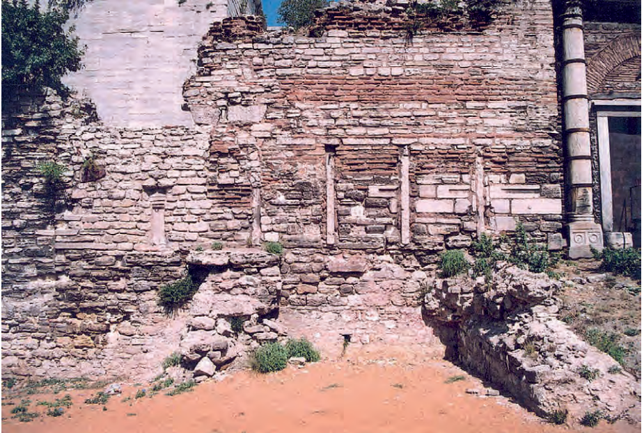
Abb. 7 Landmauer, Goldenes Tor, Vortor, Nordseite
