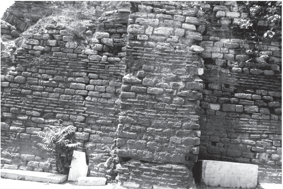
Abb. 106 Landmauer, Kurtine 82/83, Stadtseite
