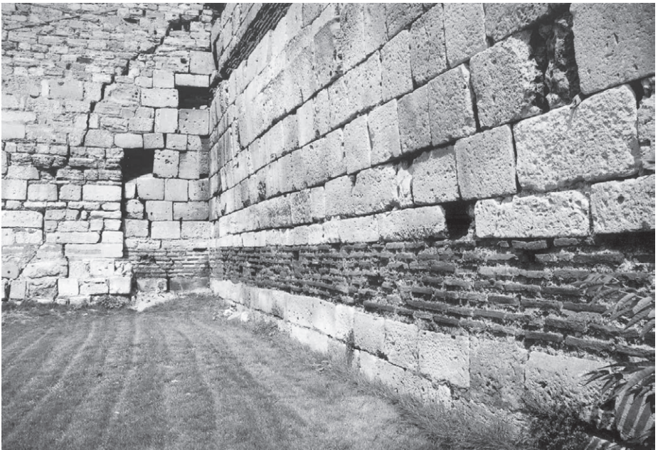
Abb. 102 Landmauer, Turm 88, Südflanke und Kurtine 87/88, Feldseite
