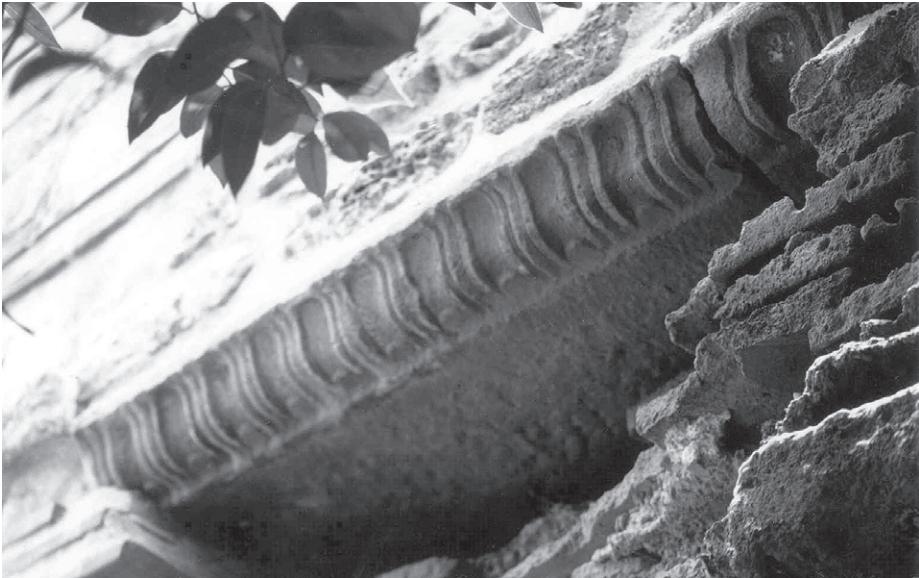
Abb. 206 Marmara-Seemauer, Kurtine 11/15, Gesims mit Pfeifenfries
