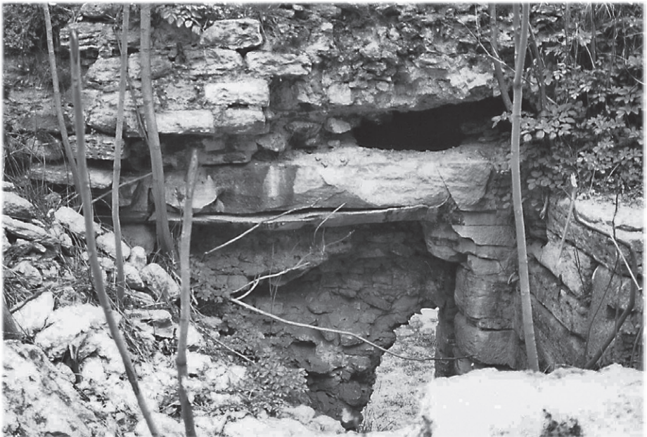
Abb. 82 Landmauer, Romanos-Tor, Vortor, Fallgatterschlitz
