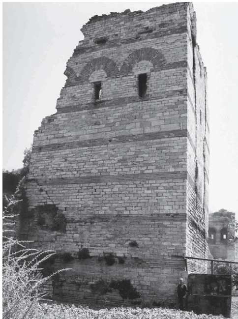
Abb. 54 Landmauer, Turm 19, Nordflanke
