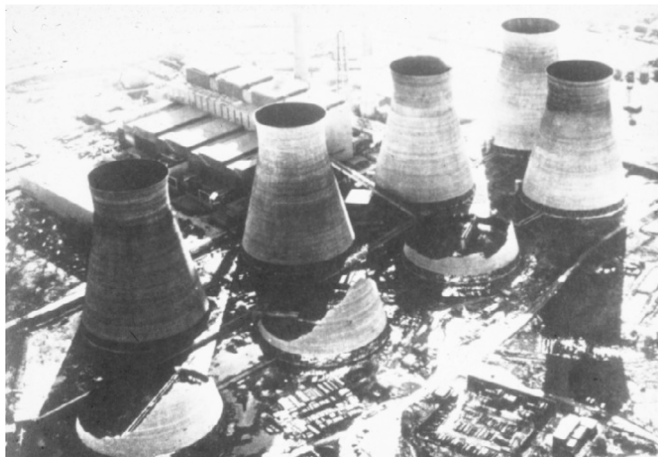
Fig. 19 Foto aerea delle torri di raffreddamento di Ferrybridge, Inghilterra
