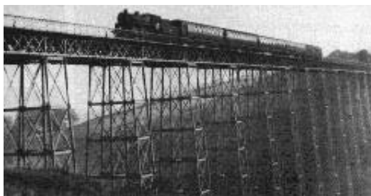
Fig. 6 Foto del Tay Bridge di Bouch (crollato il 28 dicembre 1879)
