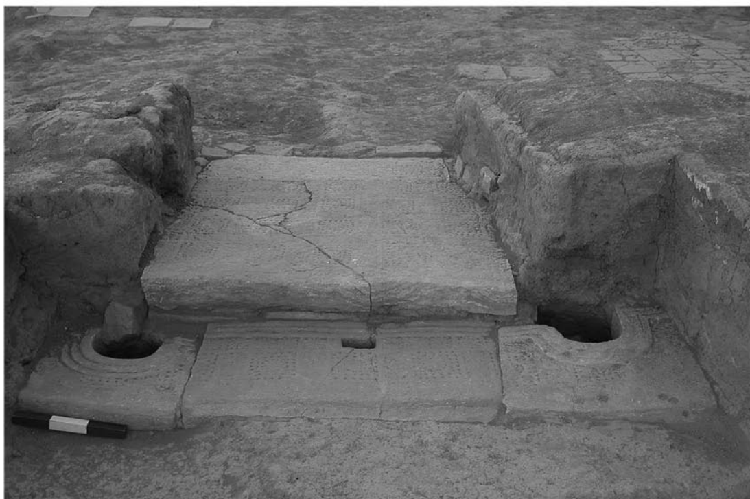
a. Area J2, T-B 6-10. Strato 14 A. Vista generale del Palazzo neoassiro. Da ONO. b. Area J2, T-B 6-10. Strato 14 A. Il varco 363. Da NE.
