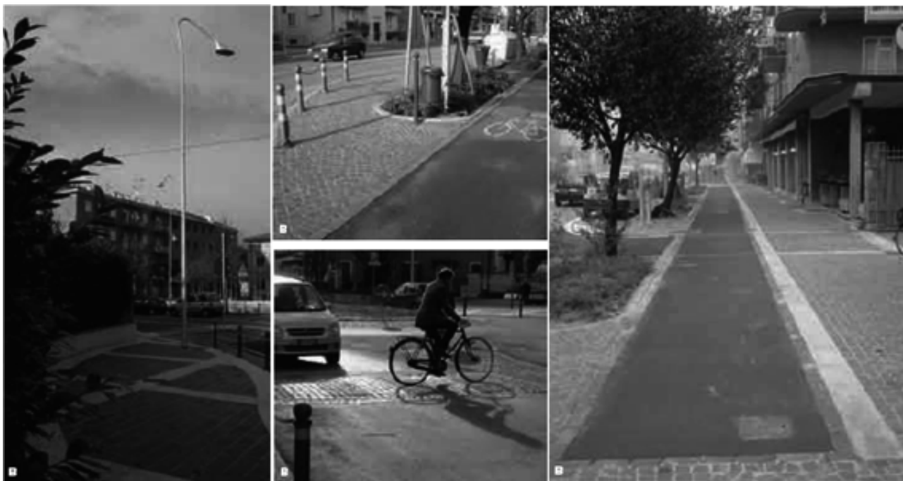
Via Gramsci in corrispondenza con incrocio via Matteotti, dopo l'intervento
