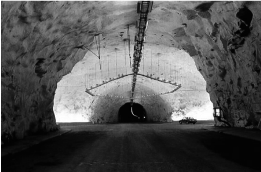
Figura 3.9: interno del Laerdal tunnel (Norvegia)
