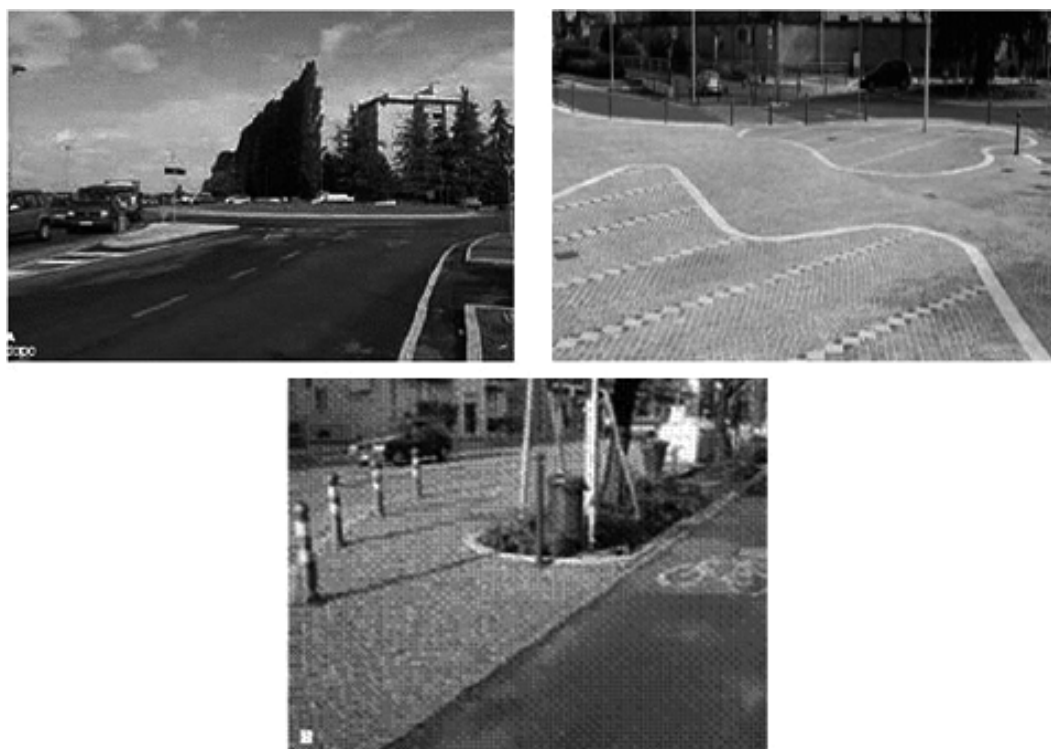
Figura 4.5: esempio di intervento realizzato dalla Città di Castel Maggiore (Provincia di Bologna) su due strade provinciali che si intersecano all'interno del centro abitato
