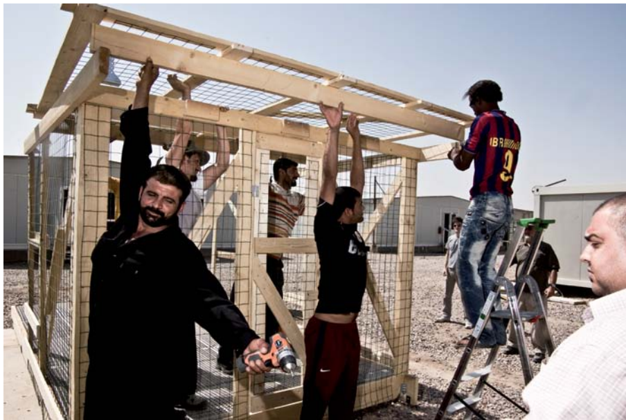
Figura 39. Fasi di assemblaggio
