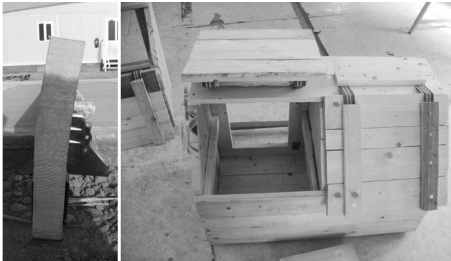
Figura 37. Costruzione del ricovero in Iraq – svergolamento del legname – nidi con cerniere di fortuna
