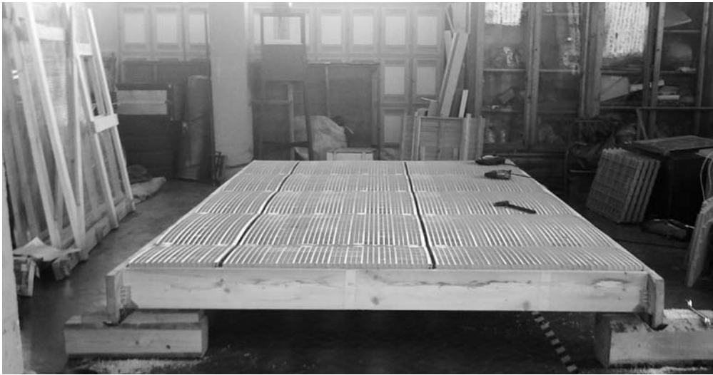
Figura 12. Grigliati/posatoio che si sopraelevano rispetto a W01
