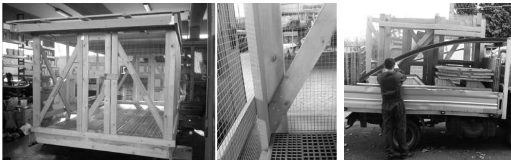
Figura 32. Assemblaggio in officina
